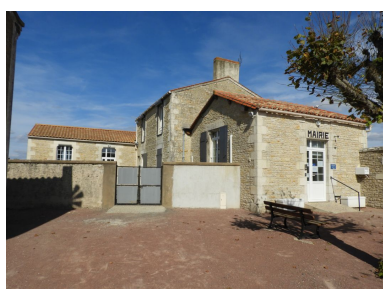
La mairie vue depuis le sud-ouest. Phot. Yannis Suire IVR52_20188500022NUCA
