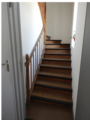
Escalier tournant intérieur en bois. Phot. Yannis Suire IVR52_20188500033NUCA
