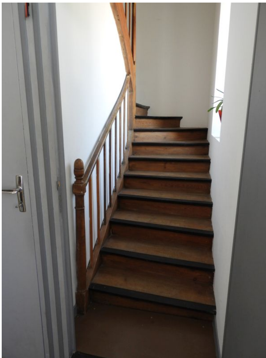
Escalier tournant intérieur en bois.
