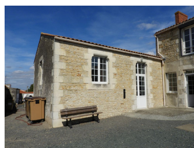
L'aile nord vue depuis le sud-ouest, ancien bâtiment de classes. Phot. Yannis Suire IVR52_20188500024NUCA
