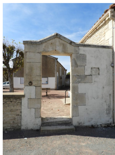
La porte piétonne au sud de la mairie. Phot. Yannis Suire IVR52_20188500021NUCA
