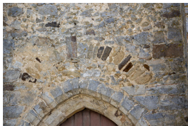
Détail de l'arc de décharge au-dessus du portail d'entrée de l'église Notre-Dame. Phot. Pierre-Bernard Fourny IVR52_20217201125NUCA
