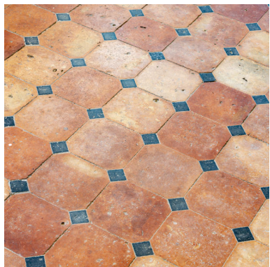
Dallage à cabochon de la chapelle sud de l'église Notre-Dame. Phot. Pierre-Bernard Fourny IVR52_20217201168NUCA
