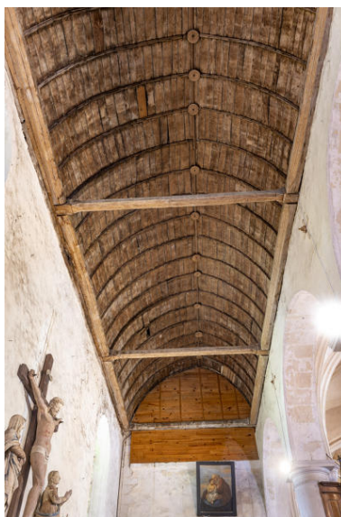
Voûte lambrissée du bas-côté nord de l'église Notre-Dame. Phot. Pierre-Bernard Fourny IVR52_20217201162NUCA
