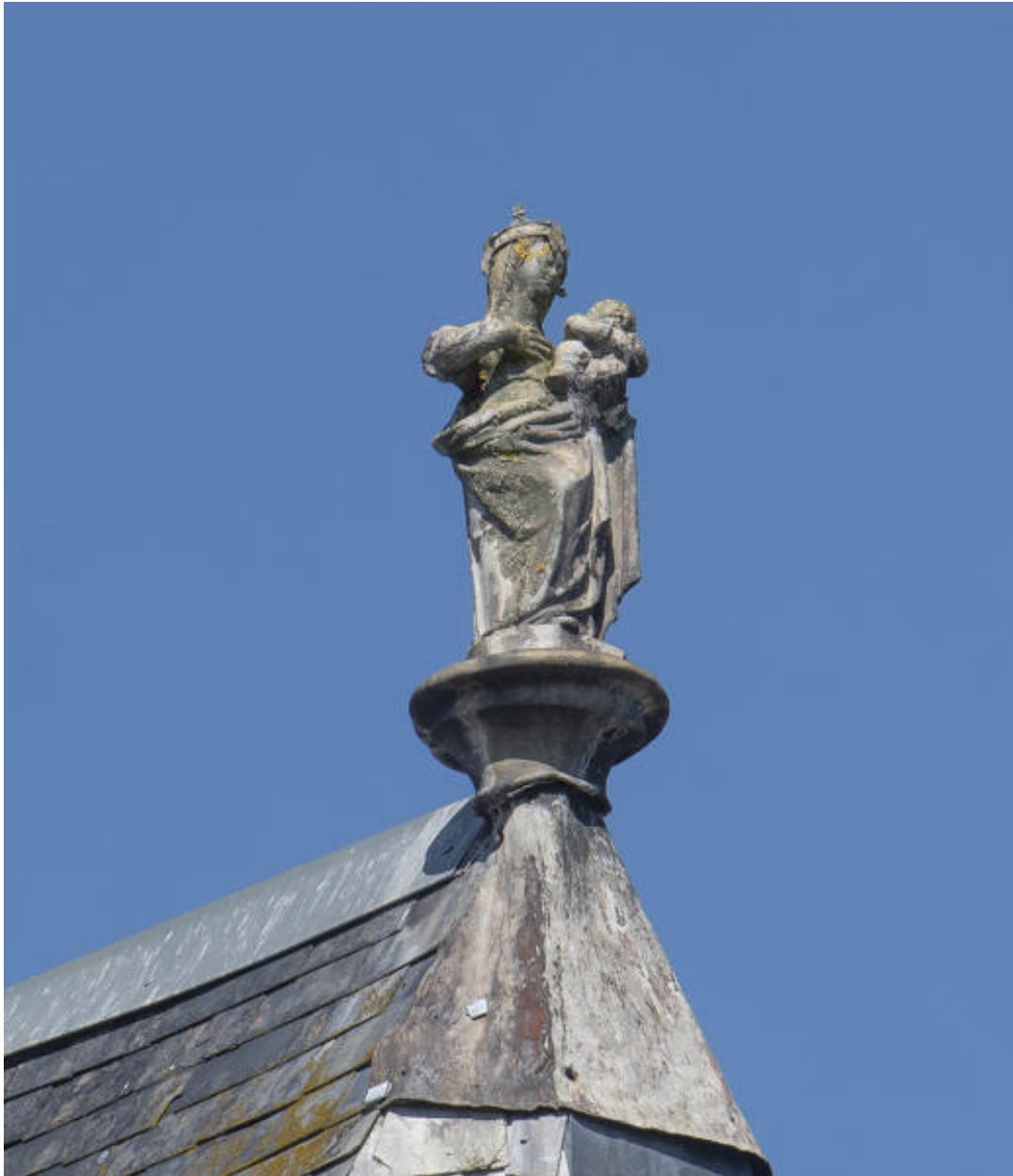
Vierge à l'Enfant en plomb, épi de faîtage sur la toiture de l'abside de l'église Notre-Dame.
