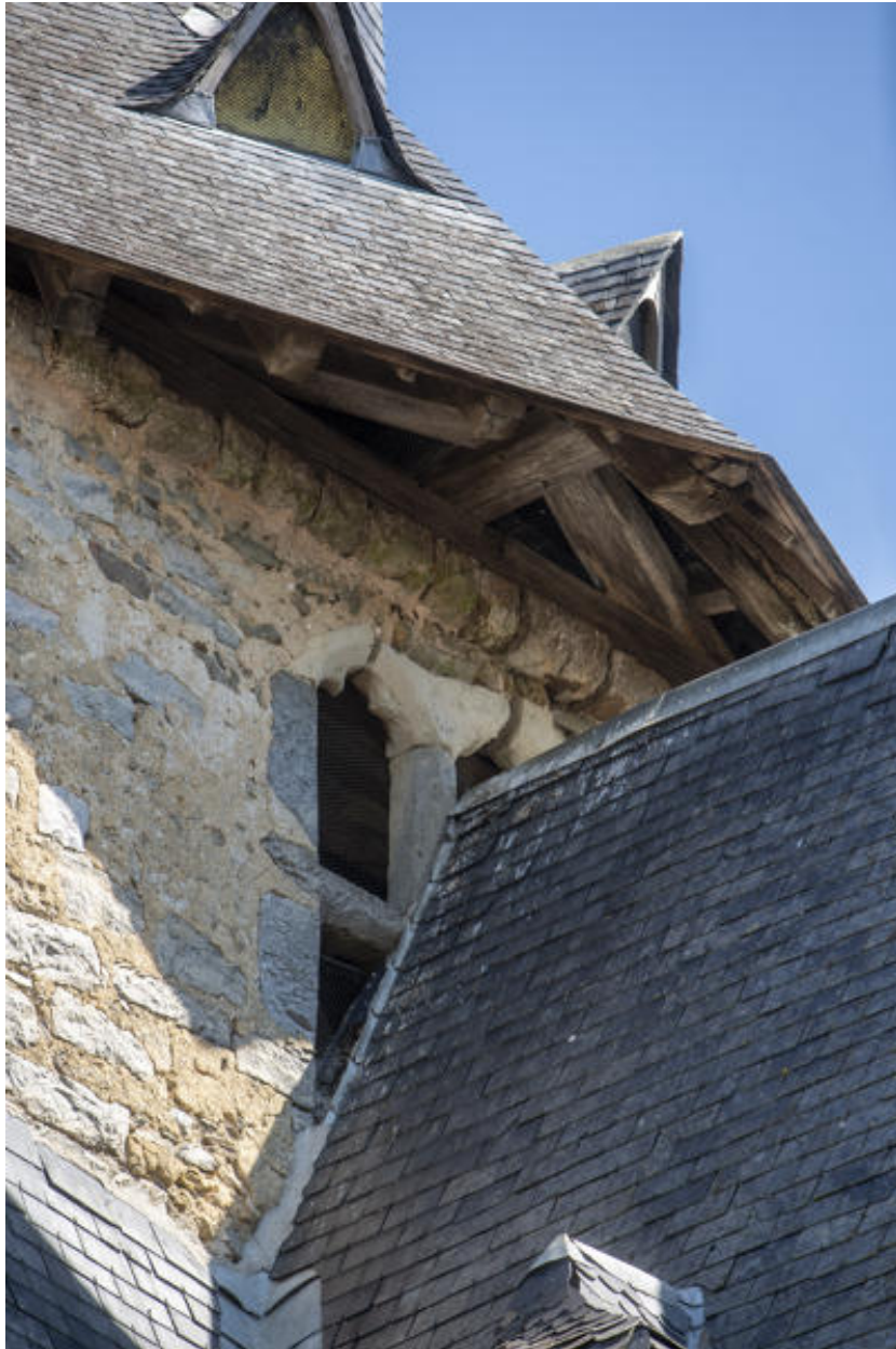
Détail d'une ancienne baie de la tour et du toit du bas-côté sud venant s'appuyer contre celle-ci, église Notre-Dame.
