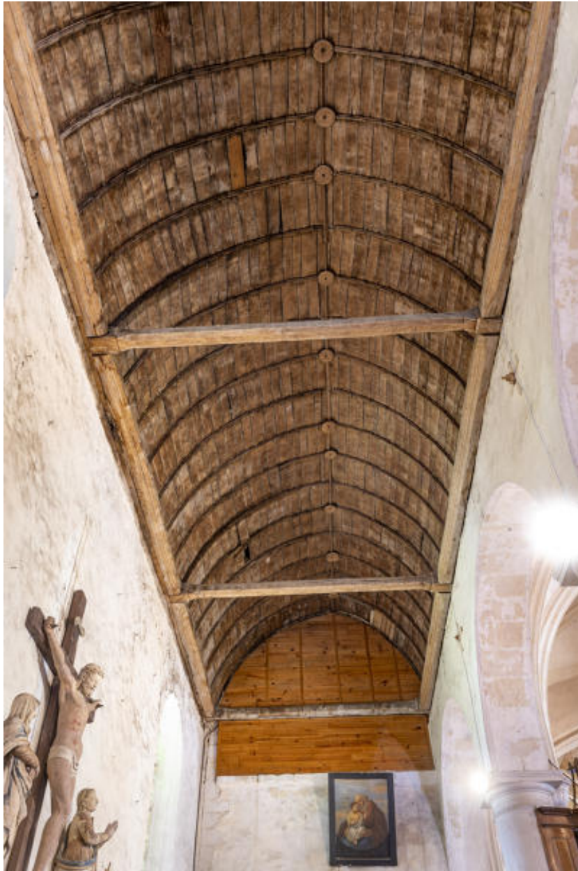
Voûte lambrissée du bas-côté nord de l'église Notre-Dame.
