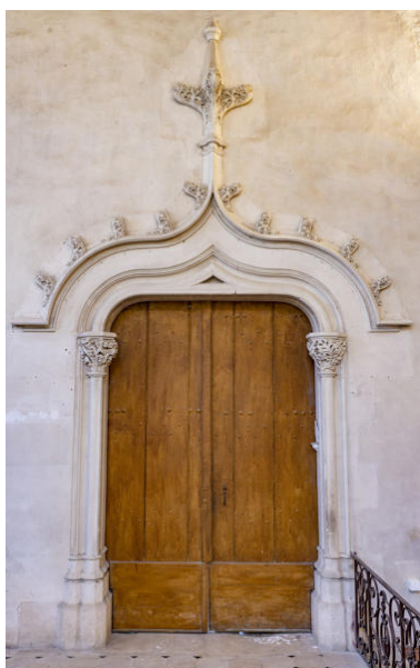
Portail d'accès entre la sacristie et le chœur de l'église Notre-Dame. Phot. Pierre-Bernard Fourny IVR52_20217201166NUCA
