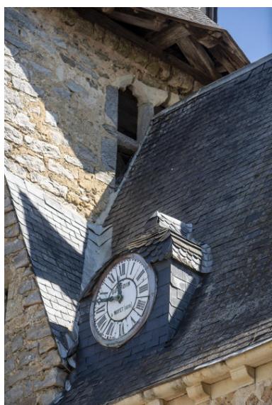
Détail du toit du bas-côté sud et de la tour de l'église Notre-Dame. Phot. Pierre-Bernard Fourny IVR52_20217201121NUCA
