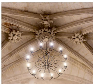
Voûte de la chapelle nord de l'église Notre-Dame. Phot. Pierre-Bernard Fourny IVR52_20217201164NUCA
