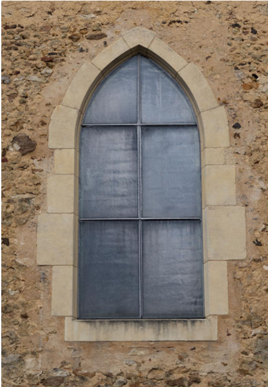
Baie restaurée et ayant perdu son remplage au niveau du bas-côté sud de l'église Notre-Dame.
