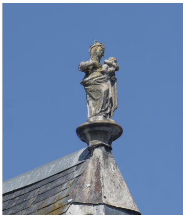
Vierge à l'Enfant en plomb, épi de faîtage sur la toiture de l'abside de l'église Notre-Dame. Phot. Pierre-Bernard Fourny IVR52_20217201117NUCA
