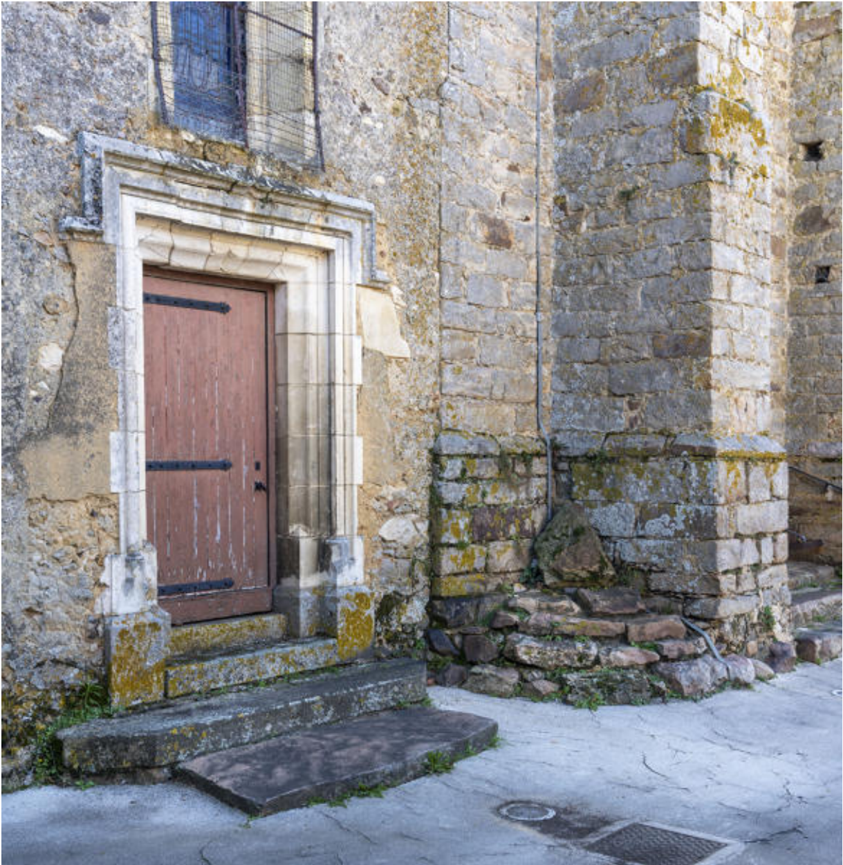
Porte d'entrée au niveau du bas-côtés nord de l'église Notre-Dame.
