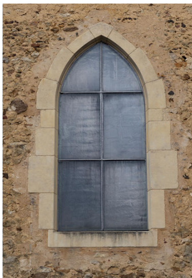
Baie restaurée et ayant perdu son remplage au niveau du bas- côté sud de l'église Notre-Dame. Phot. Pierre-Bernard Fourny IVR52_20217201350NUCA
