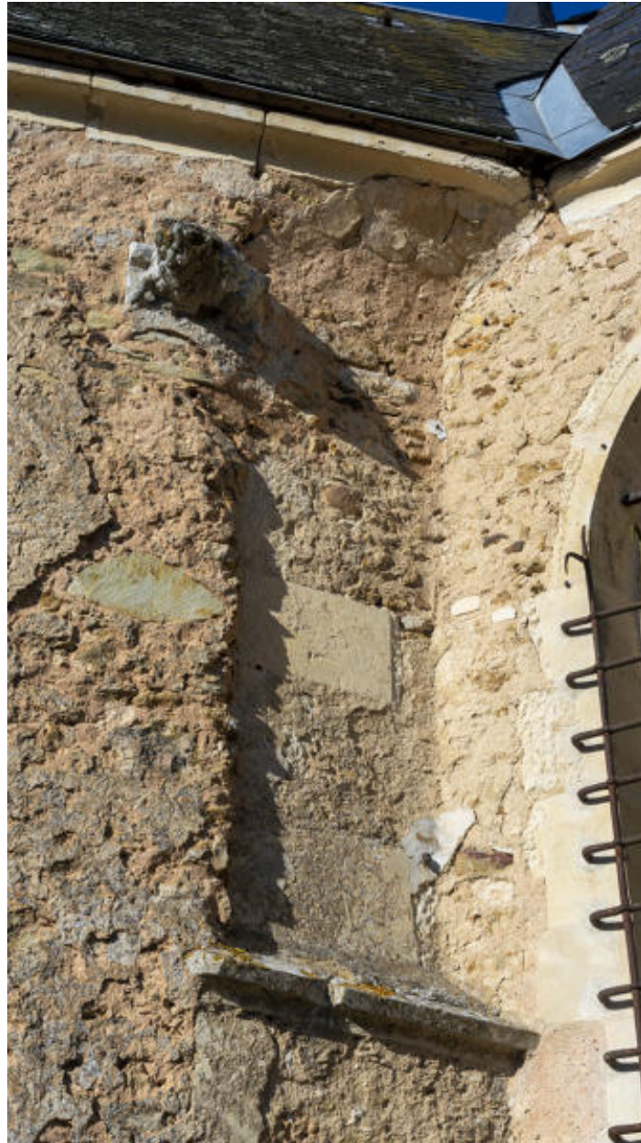
Vue d'un décrochement entre l'abside et la sacristie de l'église Notre-Dame.
