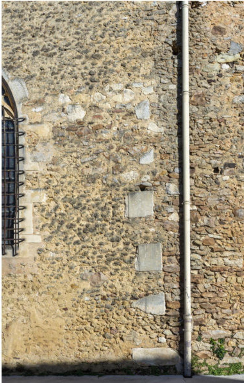
Chaînage d'angle entre la chapelle sud et la sacristie de l'église Notre-Dame.
