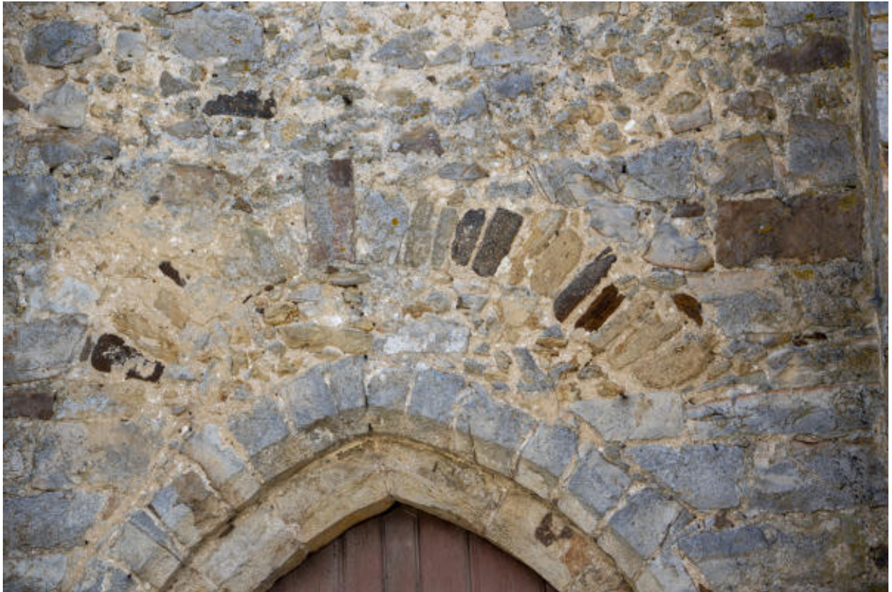
Détail de l'arc de décharge au-dessus du portail d'entrée de l'église Notre-Dame.
