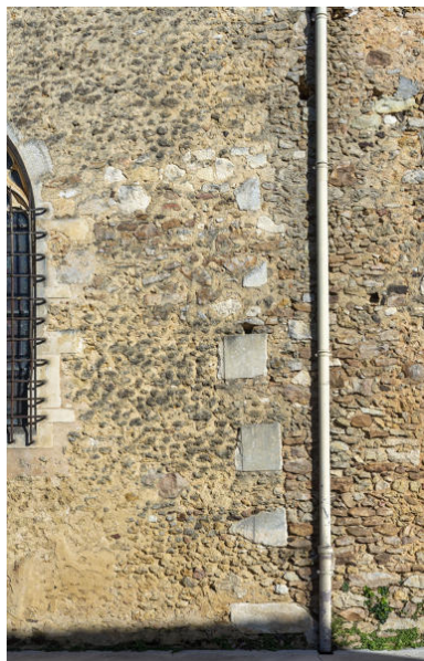
Chaînage d'angle entre la chapelle sud et la sacristie de l'église Notre-Dame. Phot. Pierre-Bernard Fourny IVR52_20217201329NUCA
