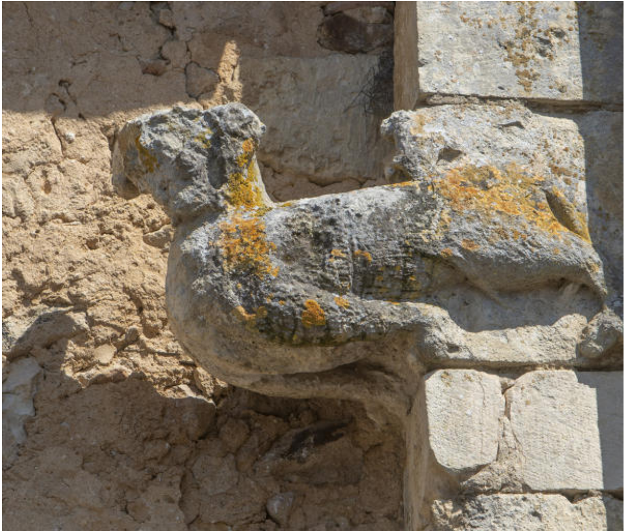
Sculpture au niveau du chaînage d'angle de la chapelle sud de l'église Notre-Dame.
