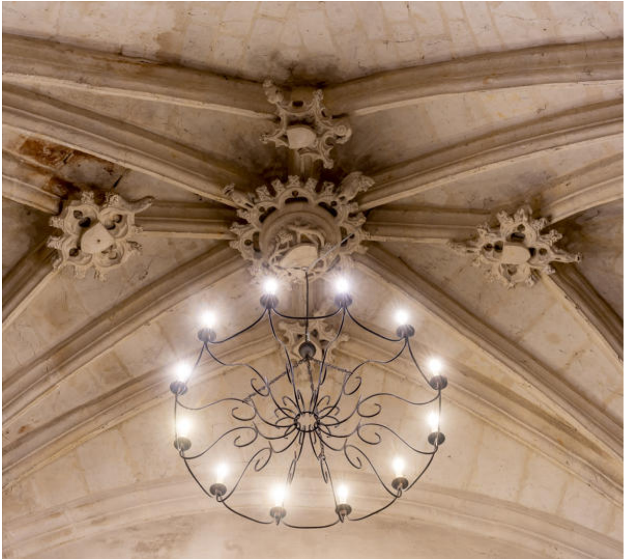
Voûte de la chapelle nord de l'église Notre-Dame.
