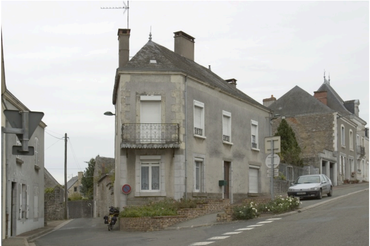
Vue depuis la route à l'ouest.
