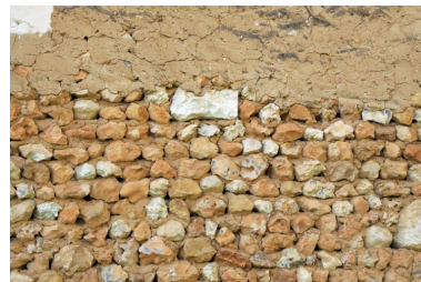
Détail du mur : moellons de silex, enduit en terre et chaux. Phot. Jean-Baptiste Darrasse IVR52_20097201776NUCA
