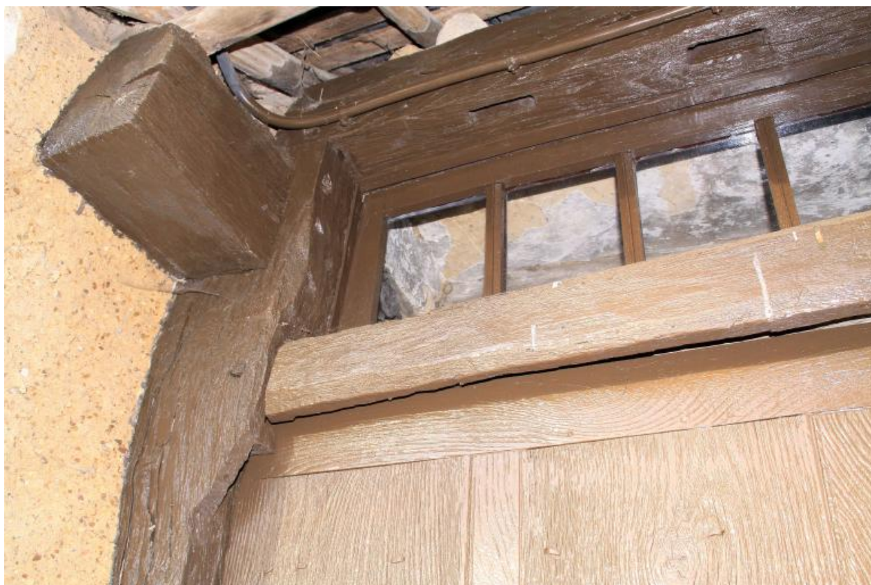
Maison ancienne, façade antérieure sur cour, détail du poteau cornier.
