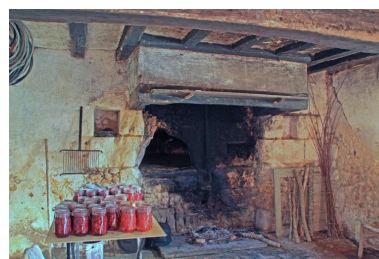
Maison ancienne : cheminée sans piédroits, flanquée de deux niches murales. Phot. Jean-Baptiste Darrasse IVR52_20097201779NUCA
