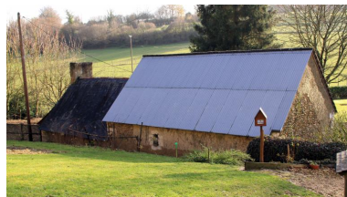
Grange-étable et maison ancienne : façade postérieure semi-enterrée. Phot. Jean-Baptiste Darrasse IVR52_20097201774NUCA
