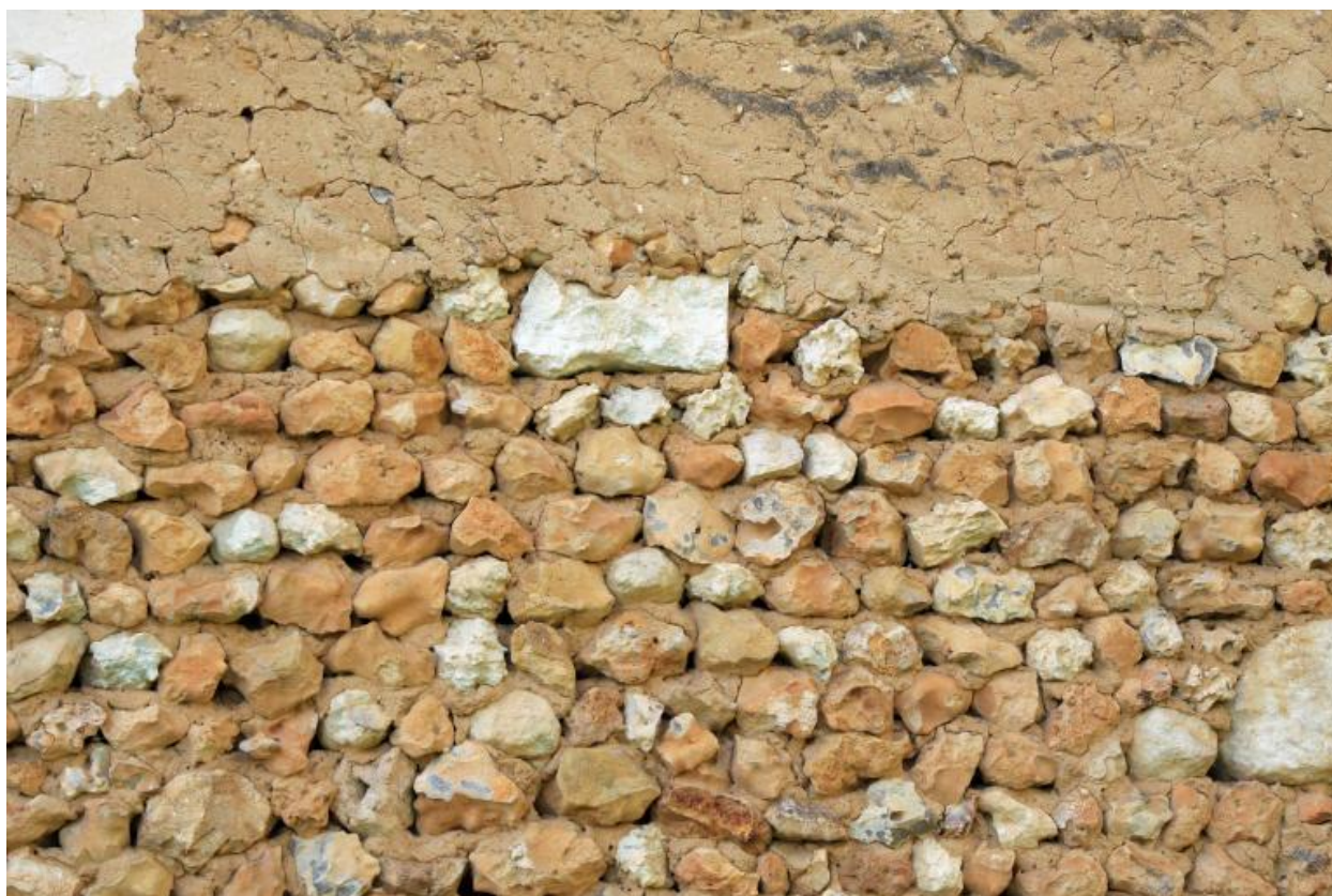
Détail du mur : moellons de silex, enduit en terre et chaux.
