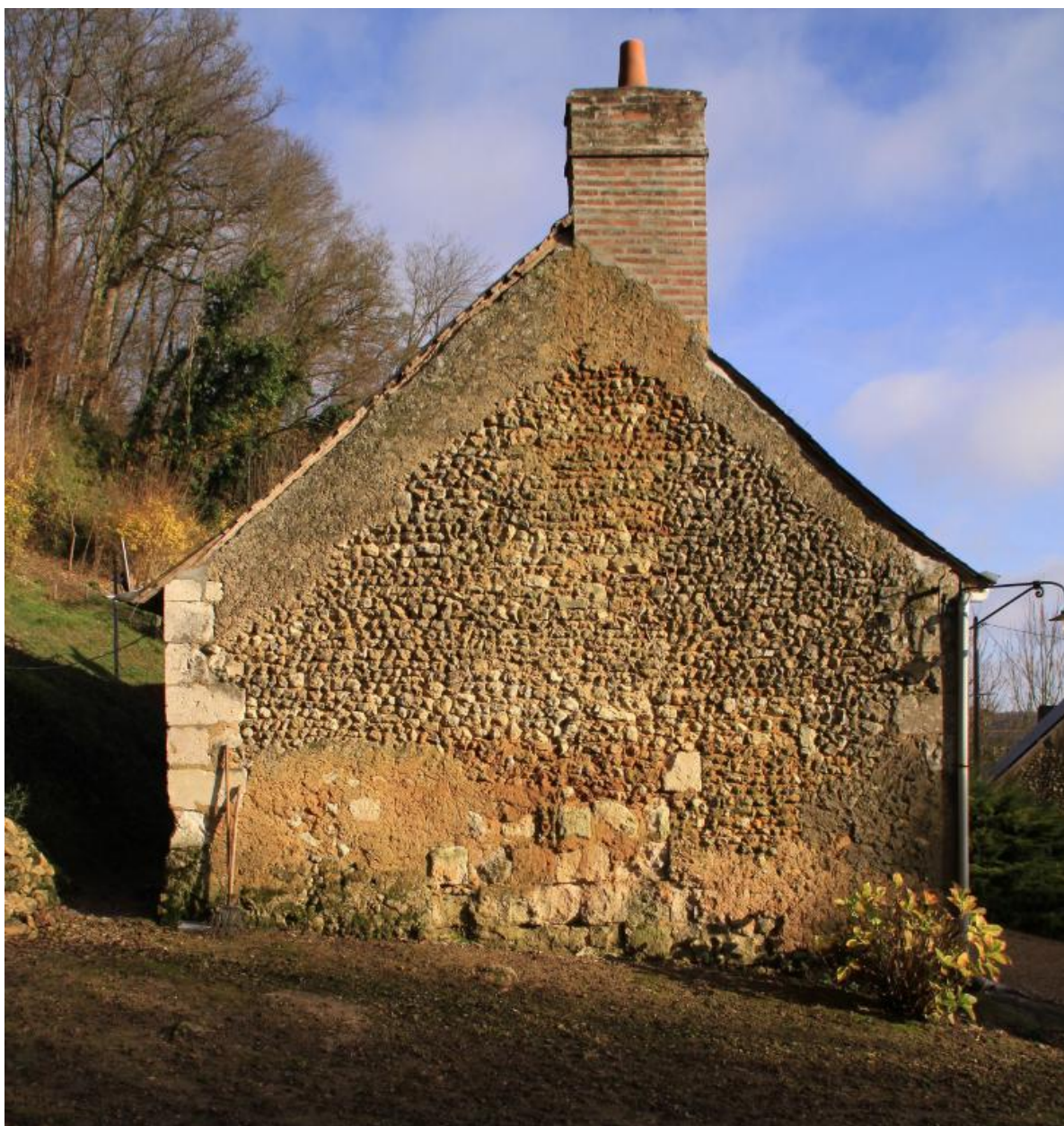
Nouvelle maison : mur-pignon ouest.
