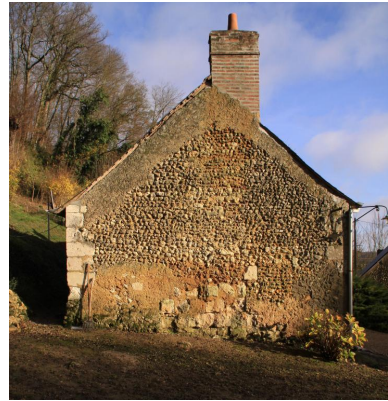
Nouvelle maison : mur-pignon ouest. Phot. Jean-Baptiste Darrasse IVR52_20097201772NUCA
