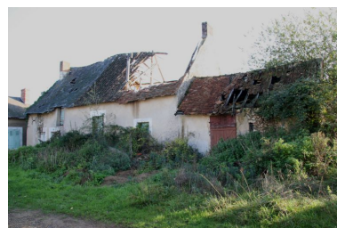
Façade antérieure : maison à grenier à fort surcroît et dépendances. Phot. Jean-Baptiste Darrasse IVR52_20057203728NUCA
