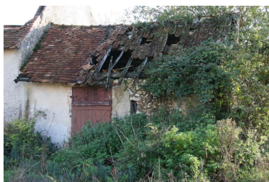
Façade antérieure de la dépendance. Phot. Jean-Baptiste Darrasse IVR52_20057203727NUCA
