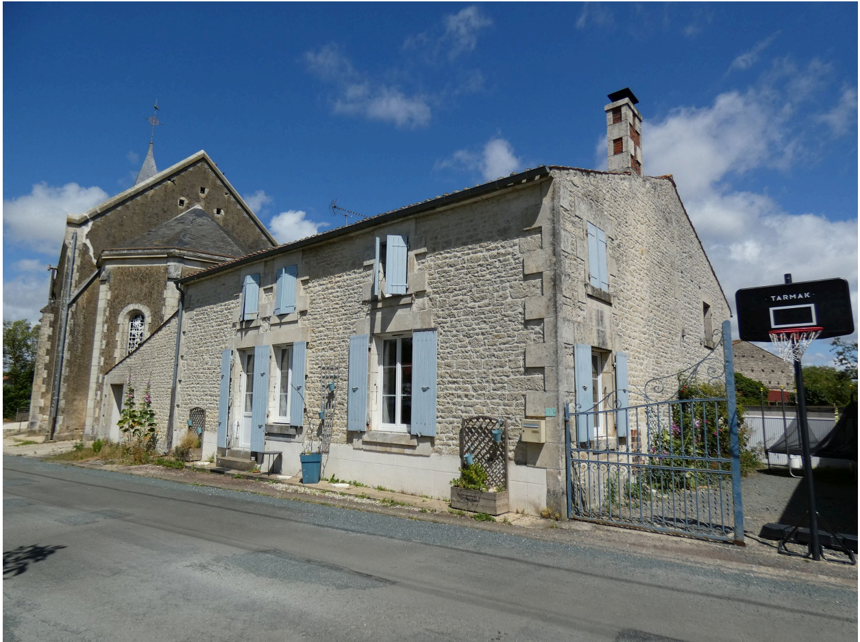
L'ancienne ferme vue depuis l'ouest.
