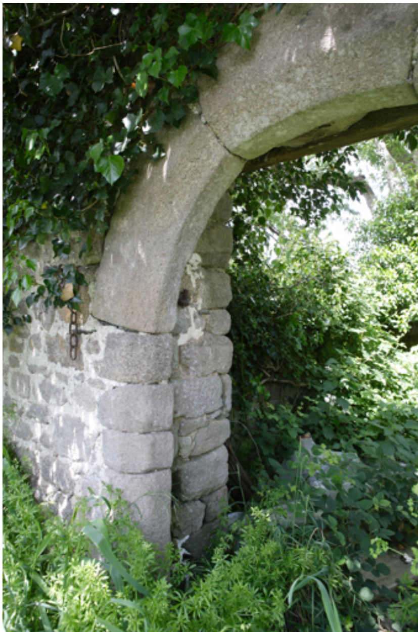
Détail du piédroit de gauche chanfreiné de la porte de la chapelle (?).
