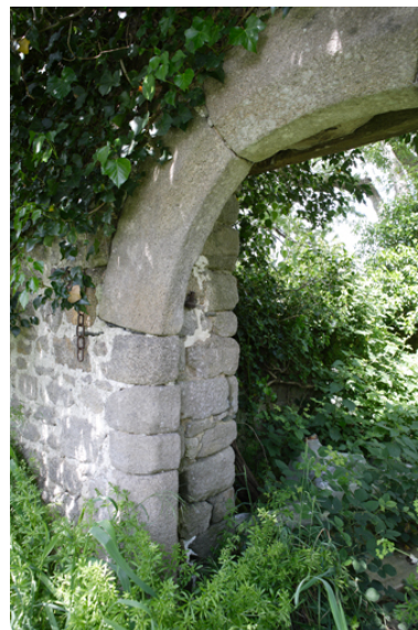
Détail du piédroit de gauche chanfreiné de la porte de la chapelle (?). Phot. Denis Pillet IVR52_20084401644NUCA
