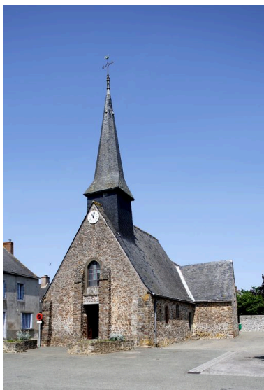
La façade occidentale, la nef et la chapelle sud vues depuis la place au sud-ouest. Phot. François Lasa IVR52_20055301750NUCA
