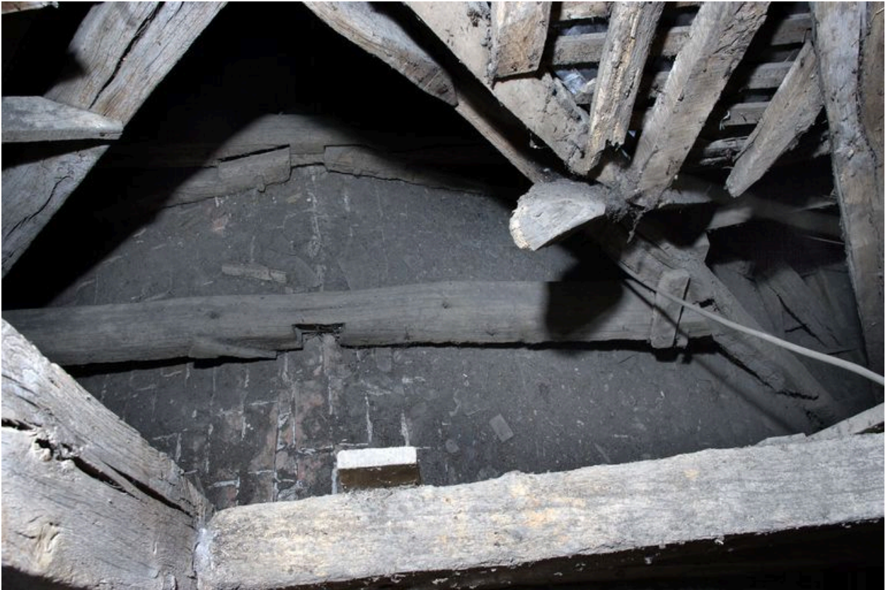
Charpente du choeur, 1ère ferme, côté ouest : vue partielle.
