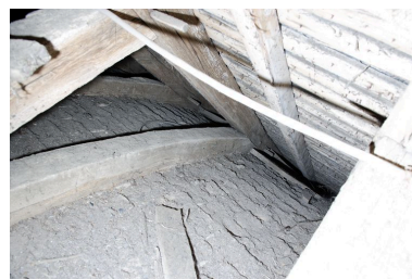
Charpente de la nef. Vue partielle de la partie sud d'une ferme : chevron, faux-entrait, aisselier. Phot. François Lasa IVR52_20055301834NUCA
