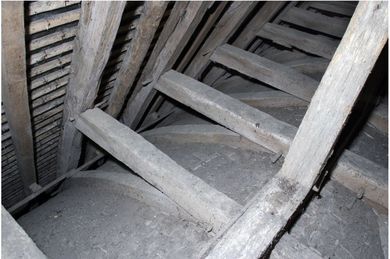
Charpente de la nef. Vue partielle de la partie nord : chevrons, faux entrails, aisseliers, sou-faîtière.
