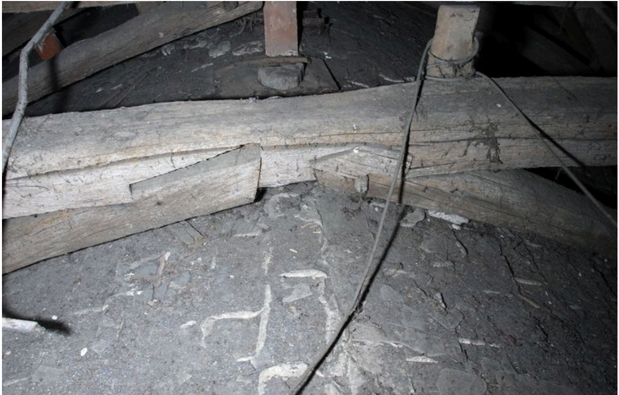
Charpente du choeur, 4e ferme, côté ouest : détail d'assemblage entre le faux entrait et les arbalétriers.
