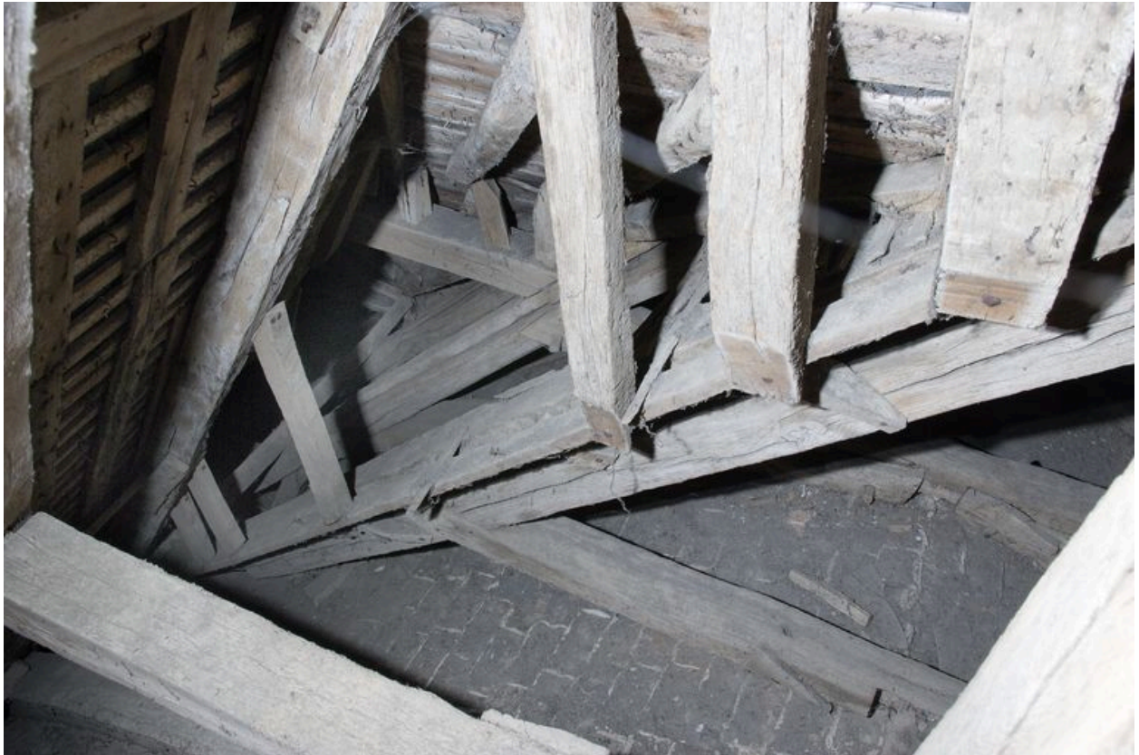
Charpente du choeur : parties nord des deux premières fermes vues depuis la charpente de la nef.
