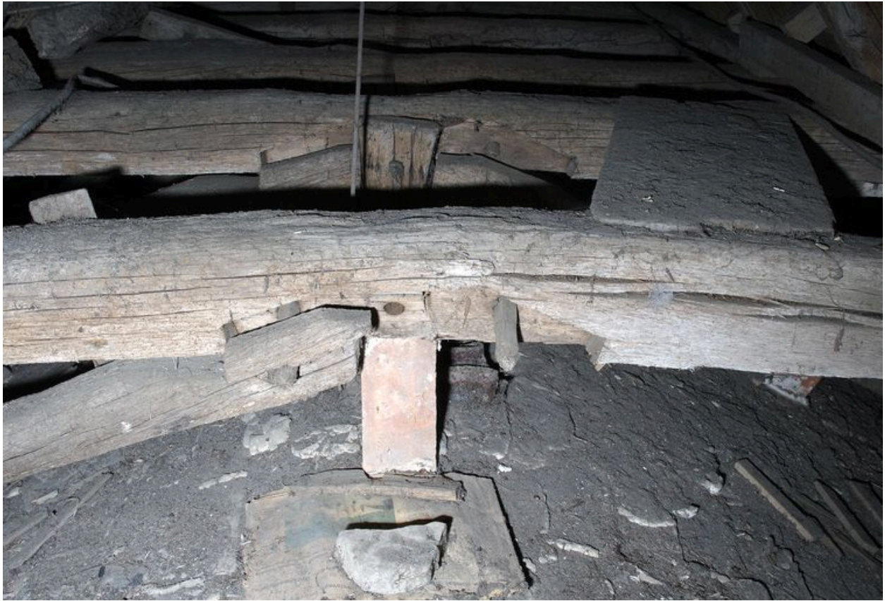
Charpente du choeur, 5e et 6e fermes, côté ouest : détail d'assemblage entre le faux entrait et les arbalétriers.
