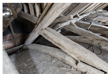
Charpente du choeur. Parties nord des premières fermes depuis l'ouest : chevrons, faux entraits et aisseliers. Phot. François Lasa IVR52_20055301849NUCA
