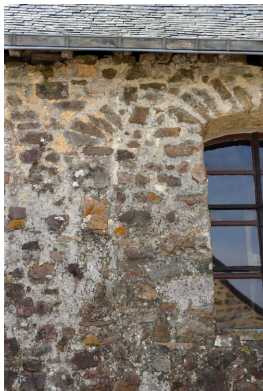
Détail de l'élévation nord du choeur : piédroit et départ d'arc d'une ancienne baie. Phot. François Lasa IVR52_20055301772NUCA
