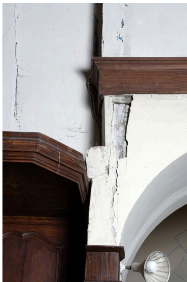
Poteau inclus dans la maçonnerie du mur nord à l'entrée de la nef : il devait supporter la poutre de gloire.. Phot. François Lasa IVR52_20055301813NUCA
