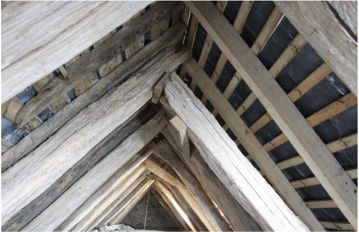
Charpente du chœur : vue partielle de la partie supérieure des chevrons.
