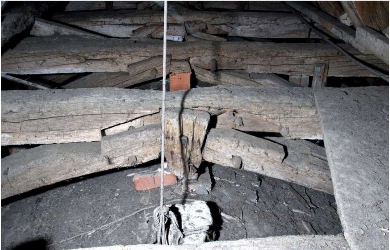
Charpente du choeur, 6e et 7e fermes, côté ouest : détail d'assemblage entre le faux entrain et les arbalétriers.
