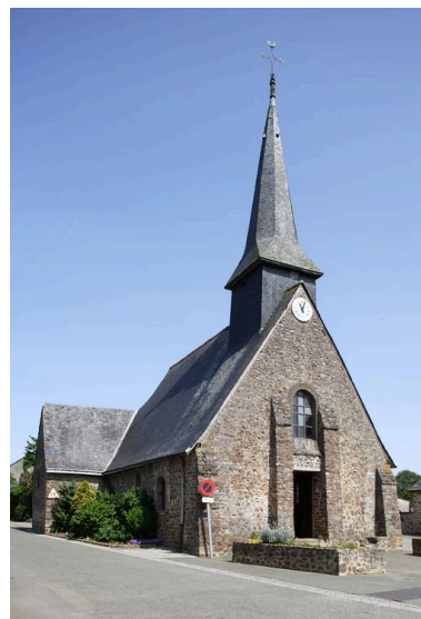
La façade occidentale, la nef et la chapelle nord vues depuis la place au nord-ouest. Phot. François Lasa IVR52_20055301751NUCA
