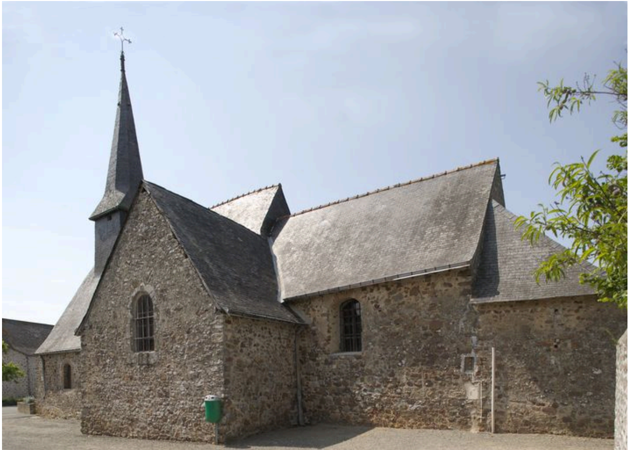
La chapelle sud, le choeur et la sacristie vus depuis le sud-est..
