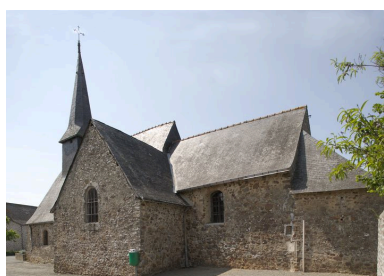
La chapelle sud, le chœur et la sacristie vus depuis le sud-est.. Phot. François Lasa IVR52_20055301764NUCA
