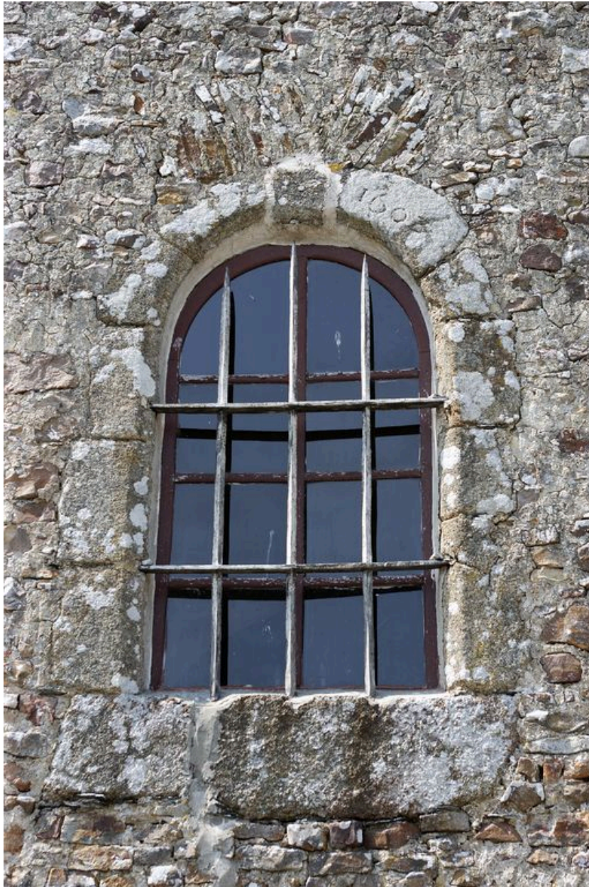
Détail de l'élévation sud de la chapelle sud : la baie avec sa date portée.
