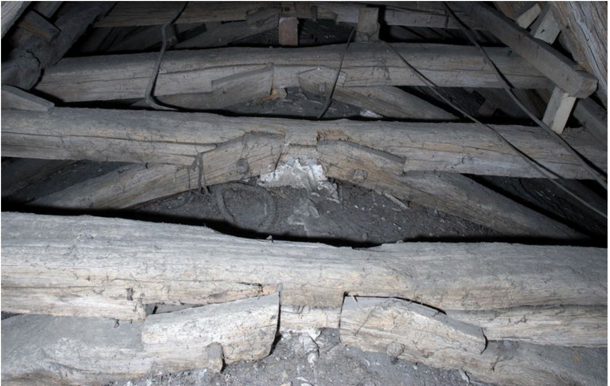
Charpente du chœur, 2e, 3e et 4e fermes, côté ouest : détail d'assemblage entre le faux entrait et les arbalétriers.
