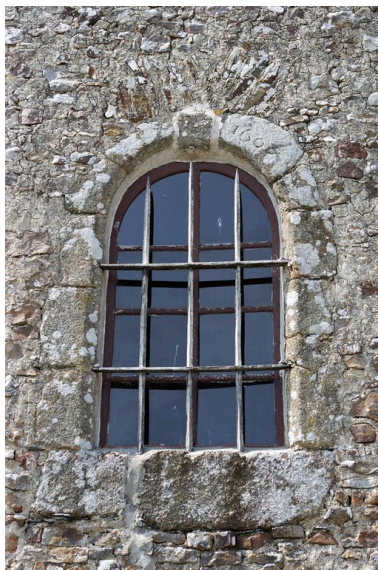
Détail de l'élévation sud de la chapelle sud : la baie avec sa date portée. Phot. François Lasa IVR52_20055301766NUCA
