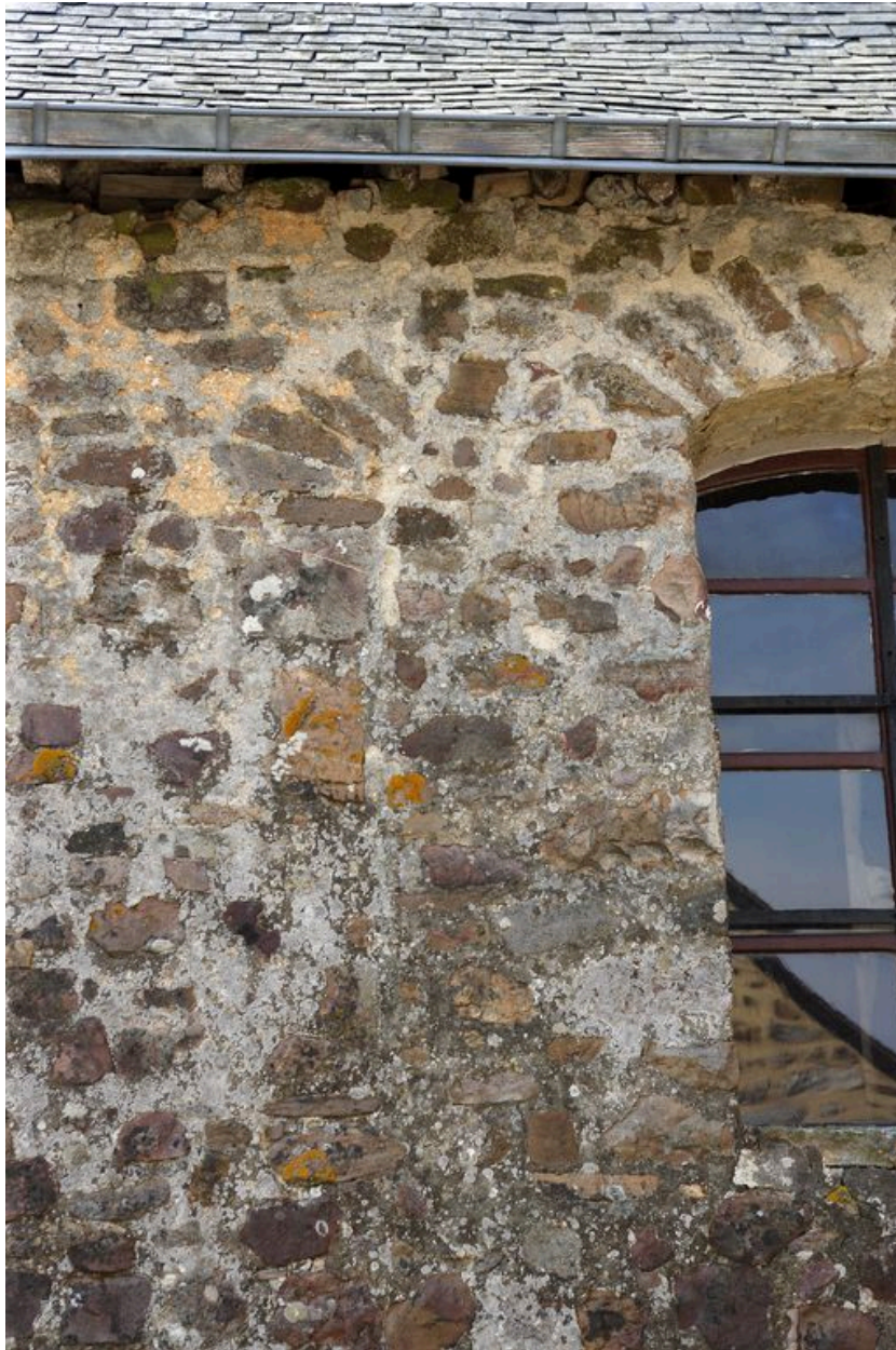
Détail de l'élévation nord du choeur : piédroit et départ d'arc d'une ancienne baie.
