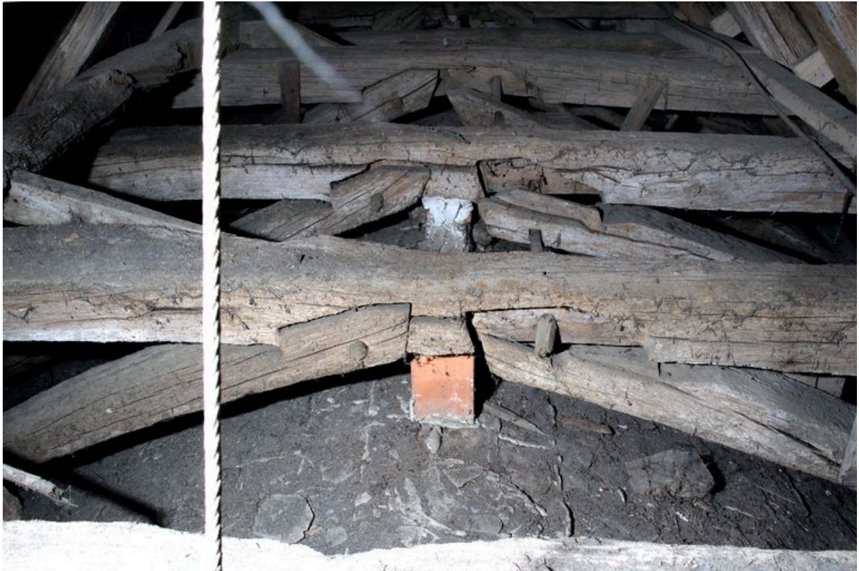
Charpente du choeur, 7e, 8e et 9e fermes, côté ouest : détail d'assemblage entre le faux entrait et les arbalétriers.
