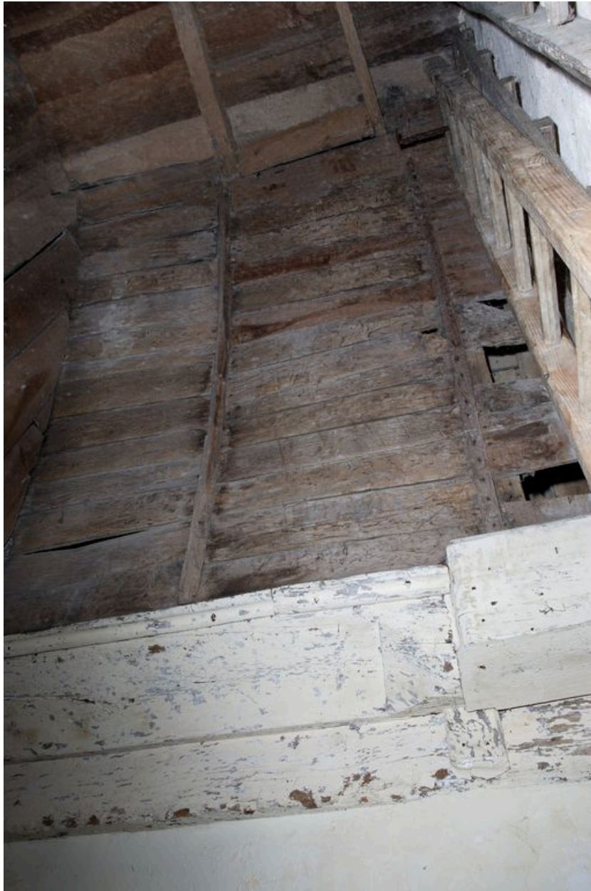
Partie conservée du lambris, située dans la cage d'escalier de la tribune.
