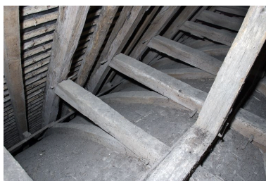
Charpente de la nef. Vue partielle de la partie nord : chevrons, faux entraits, aisseliers, sou-faîtière. Phot. François Lasa IVR52_20055301835NUCA
