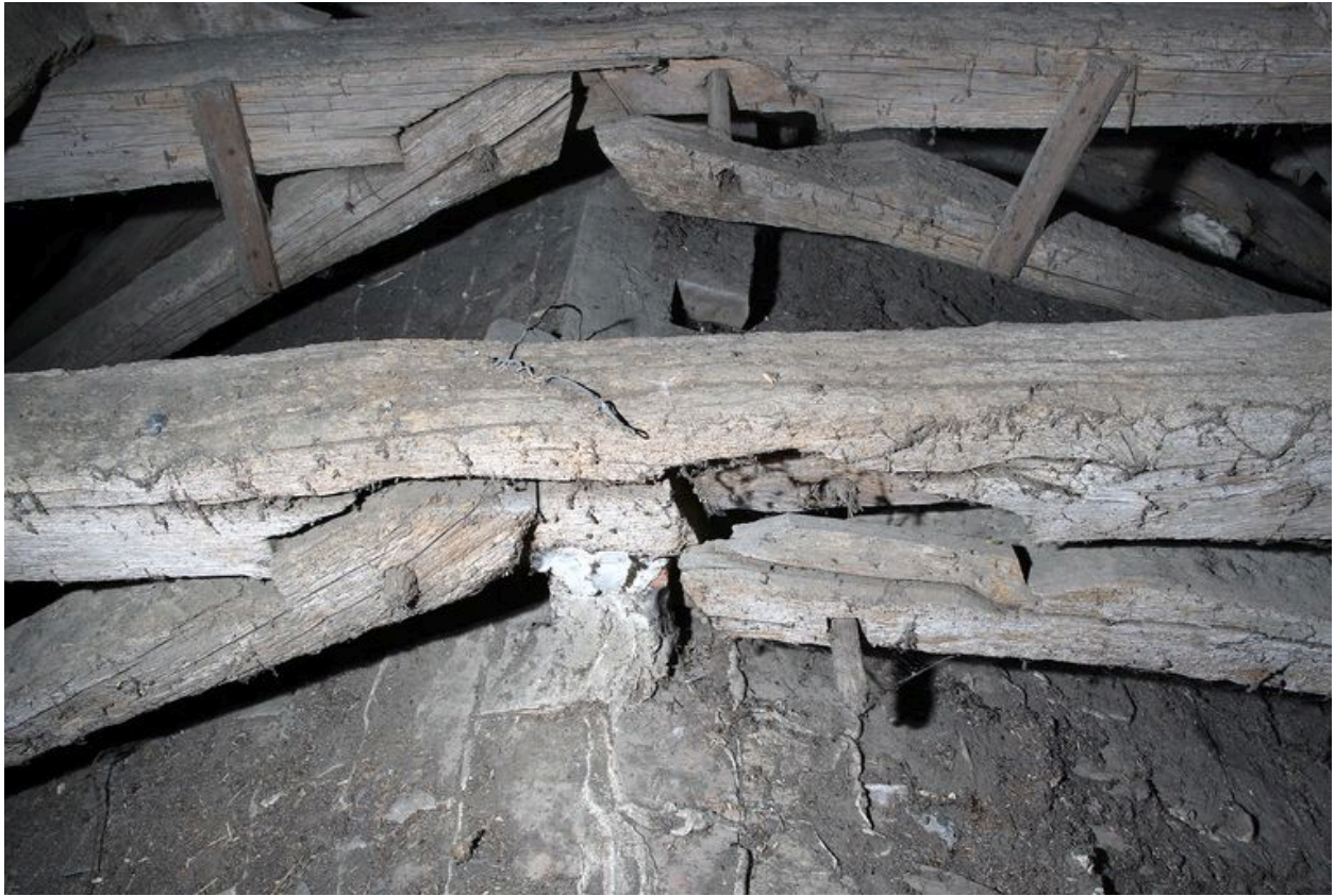
Charpente du chœur, 8e et 9e fermes, côté ouest : détail d'assemblage entre le faux entrain et les arbalétriers.
