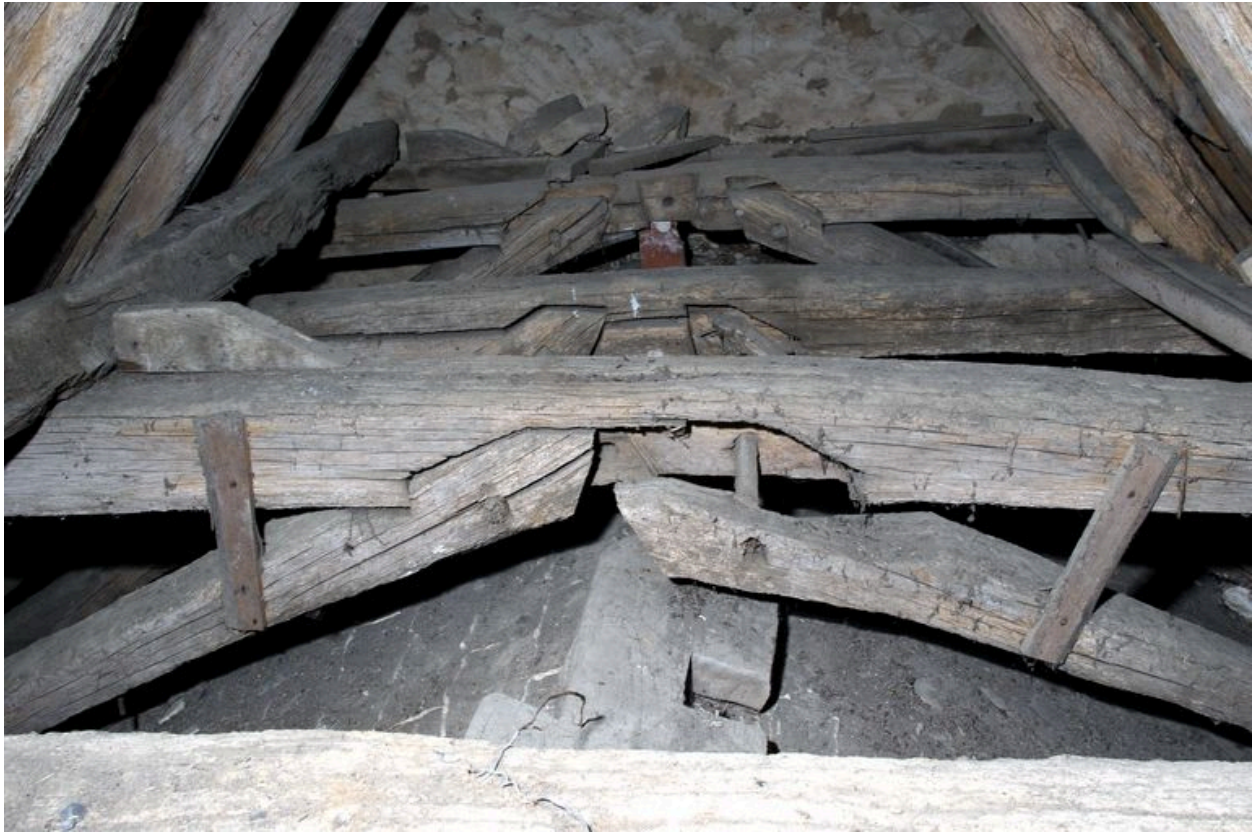
Charpente du chœur, 9e, 10e et 11e fermes, côté ouest : détail d'assemblage entre le faux entrait et les arbalétriers.
