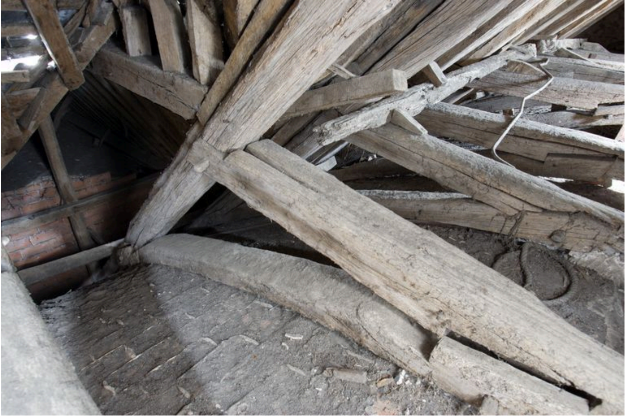
Charpente du choeur. Parties nord des premières fermes depuis l'ouest : chevrons, faux entrails et aisseliers.
