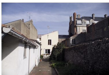
La façade postérieure (à gauche de l'actuelle mairie) depuis la cour de la maison mitoyenne n° 3. Phot. Denis Pillet IVR52_20034401635NUCA
