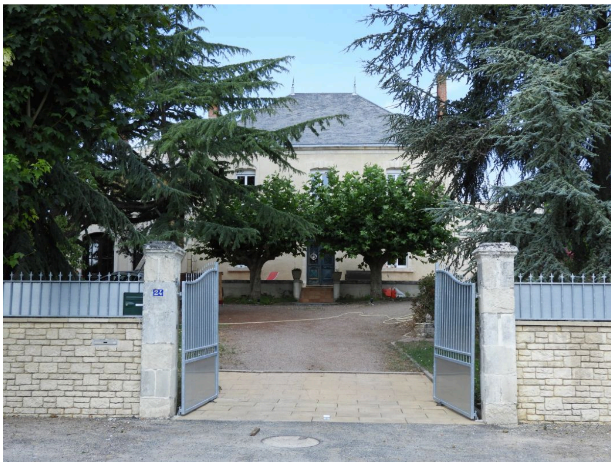
La maison vue depuis le sud-est.
