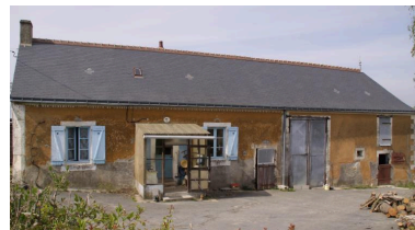
Ferme bloc à terre : façade antérieure sur cour. Phot. Jean-Baptiste Darrasse IVR52_20107200657NUCA
