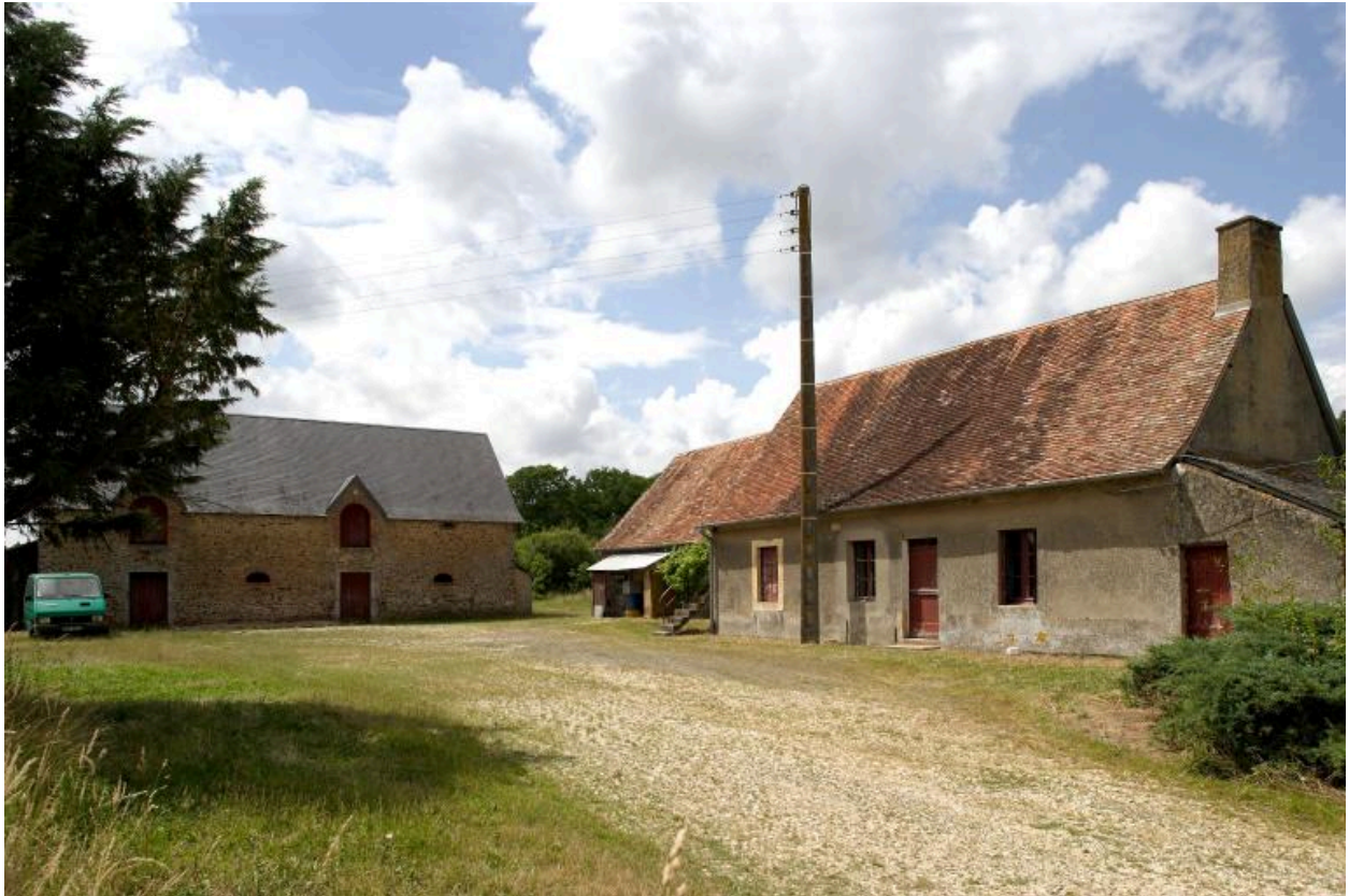
Vue d'ensemble depuis l'est : à gauche, l'étable-grange ; à droite le logis-étable.
