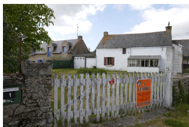
Vue du dernier logis depuis le sud-est. Phot. Denis Pillet IVR52_20084401431NUCA
