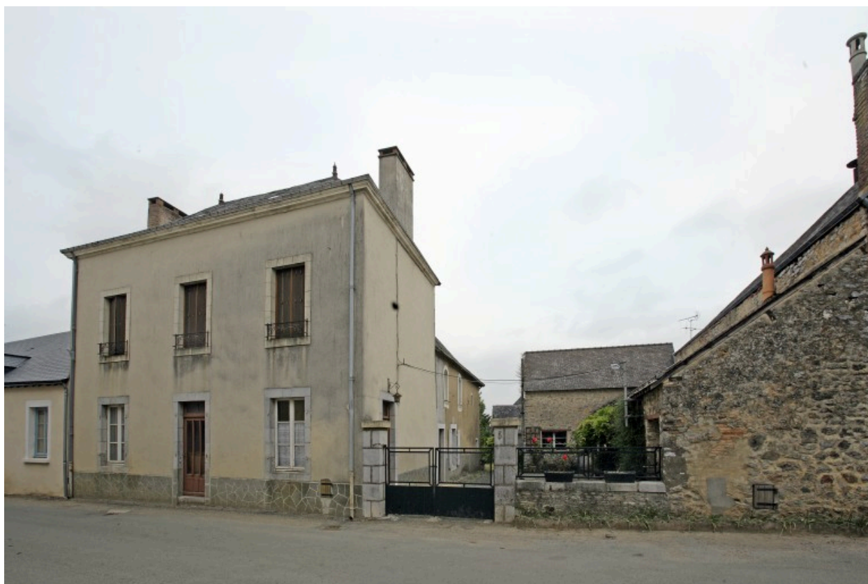
Vue d'ensemble depuis la rue au sud-ouest.
