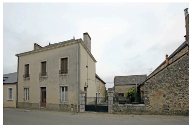
Vue d'ensemble depuis la rue au sud-ouest. Phot. François Lasa IVR52_20075302158NUCA
