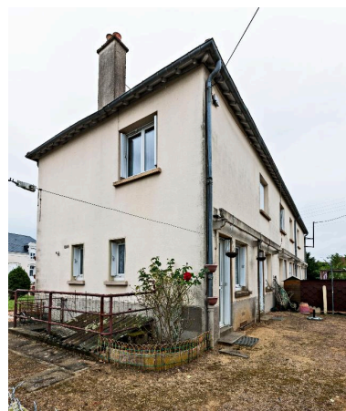
Elévation postérieure du bâtiment de trois logements n° 12 et 14 rue Horncastle et 2 rue Delibes. Phot. Yves Guillotin IVR52_20177200740NUCA
