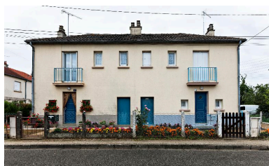
Elévation sur rue du bâtiment de deux logements n° 4 et 6. Phot. Yves Guillotin IVR52_20177200738NUCA
