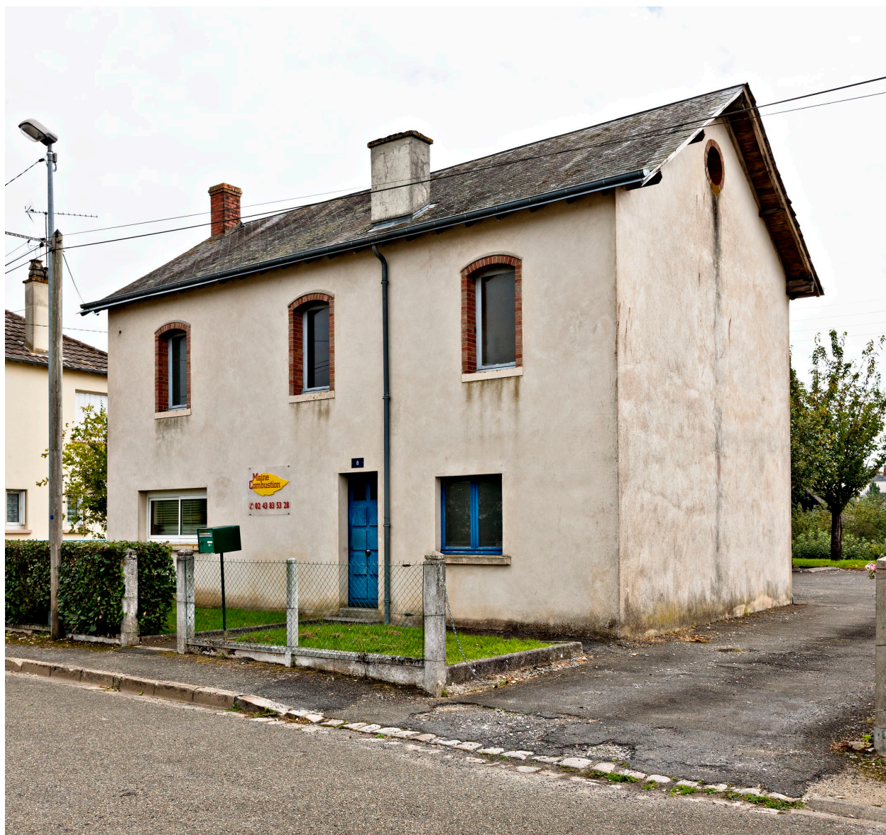
Elévation sur rue de l'ancienne gare.
