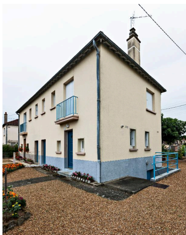
Elévation latérale du bâtiment de deux logements n° 4 et 6. Phot. Yves Guillotin IVR52_20177200739NUCA
