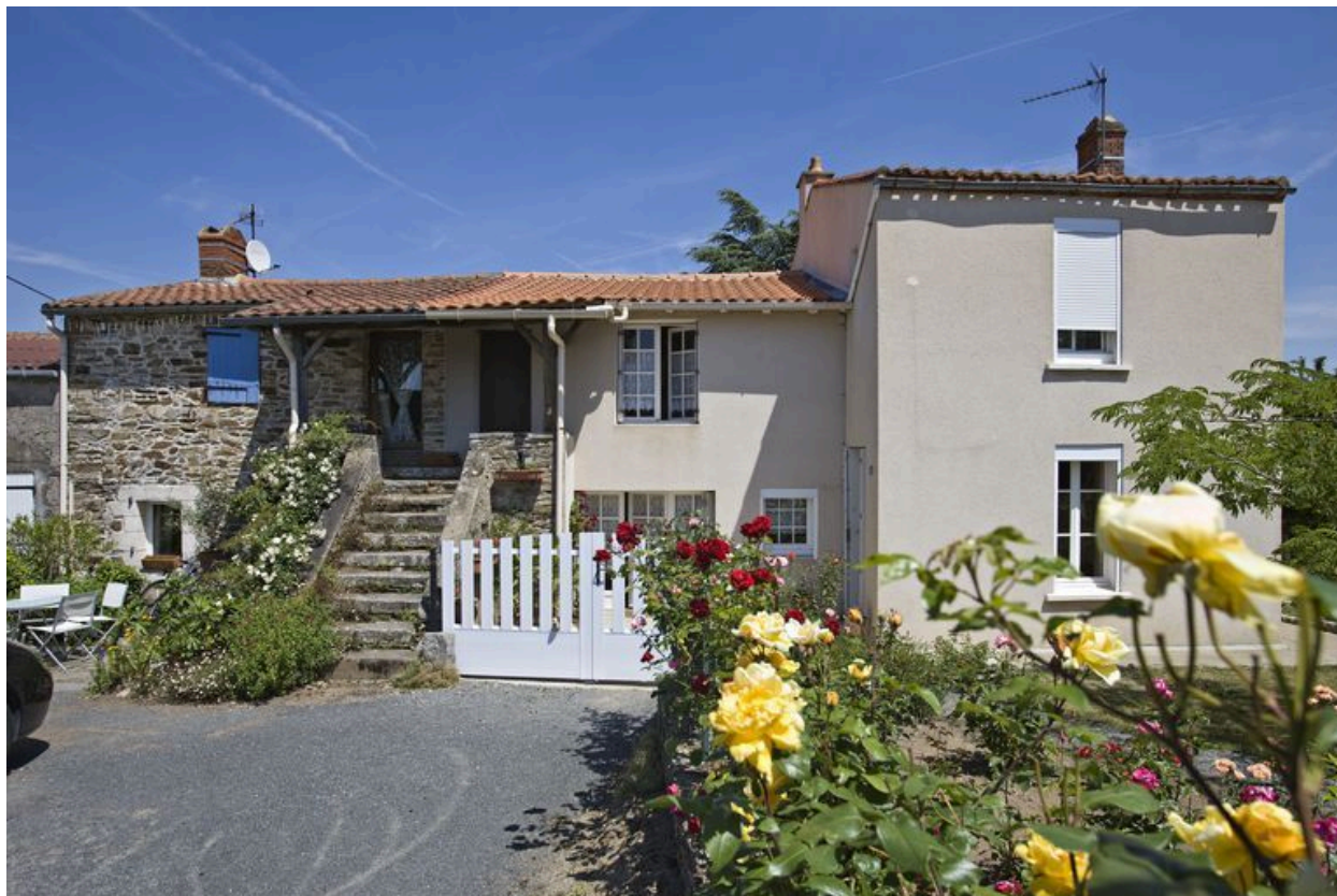
Maison double de vigneron : partie est, remaniée ; partie ouest, restaurée.
