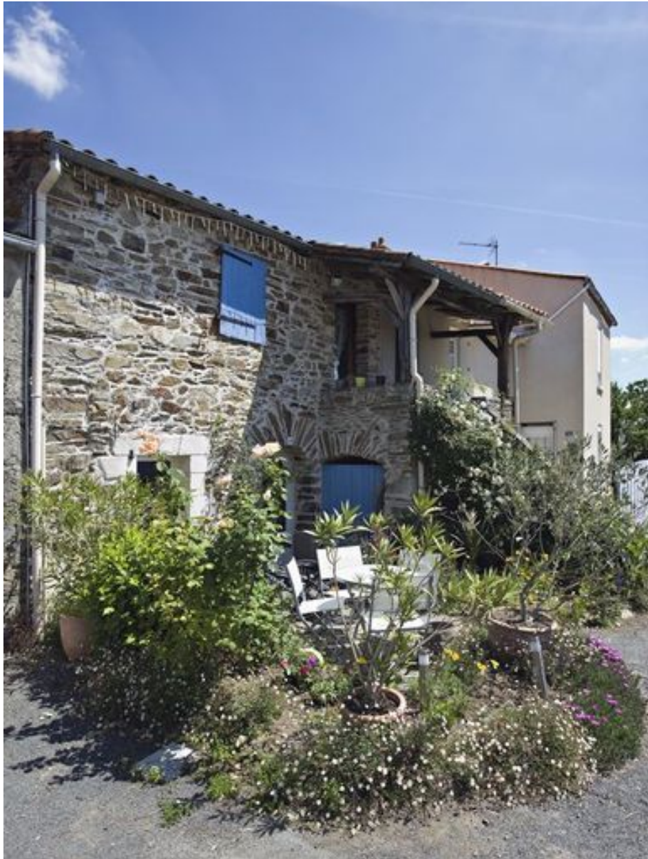
Maison double de vigneron. Partie ouest : détails.
