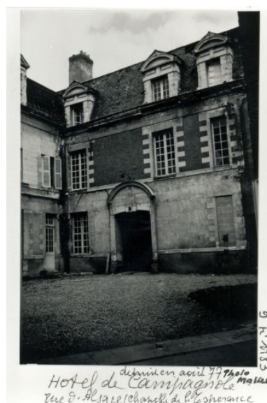
Cour antérieure avec le corps de logis principal, fotogr., de R. Mattéi, 3e quart 20e siècle. Phot. François Lasa, Autr. Roger Mattéi IVR52_19934900642X
