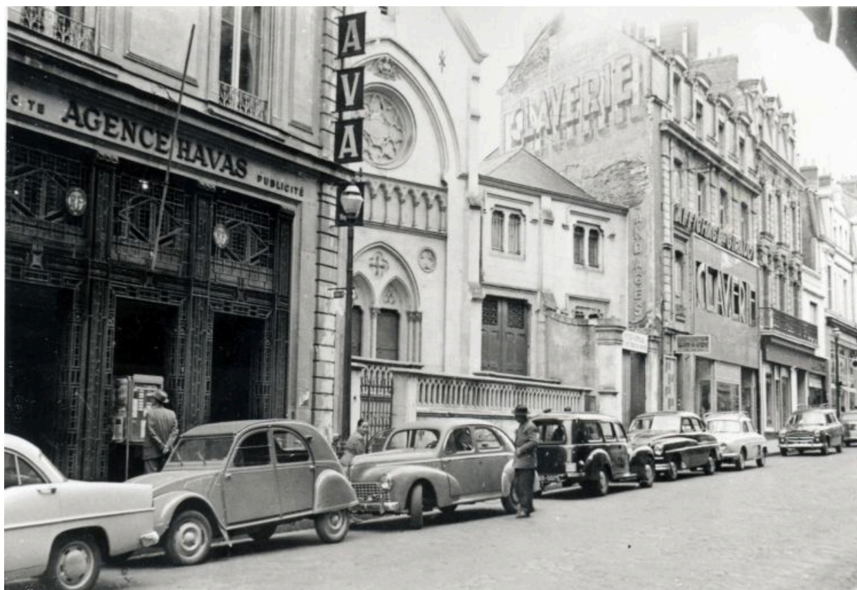
Elévation antérieure de l'église conventuelle, vue de situation sur la rue d'Alsace, fotogr., [av. 1970].
