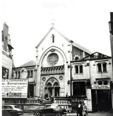
Elévation antérieure de l'église conventuelle sur la rue d'Alsace, fotogr., 1970. Phot. François Lasa IVR52_19984902462X
