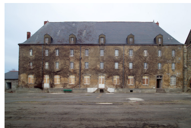
Façade arrière du bâtiment est. Phot. Denis Pillet IVR52_20054402307NUCA
