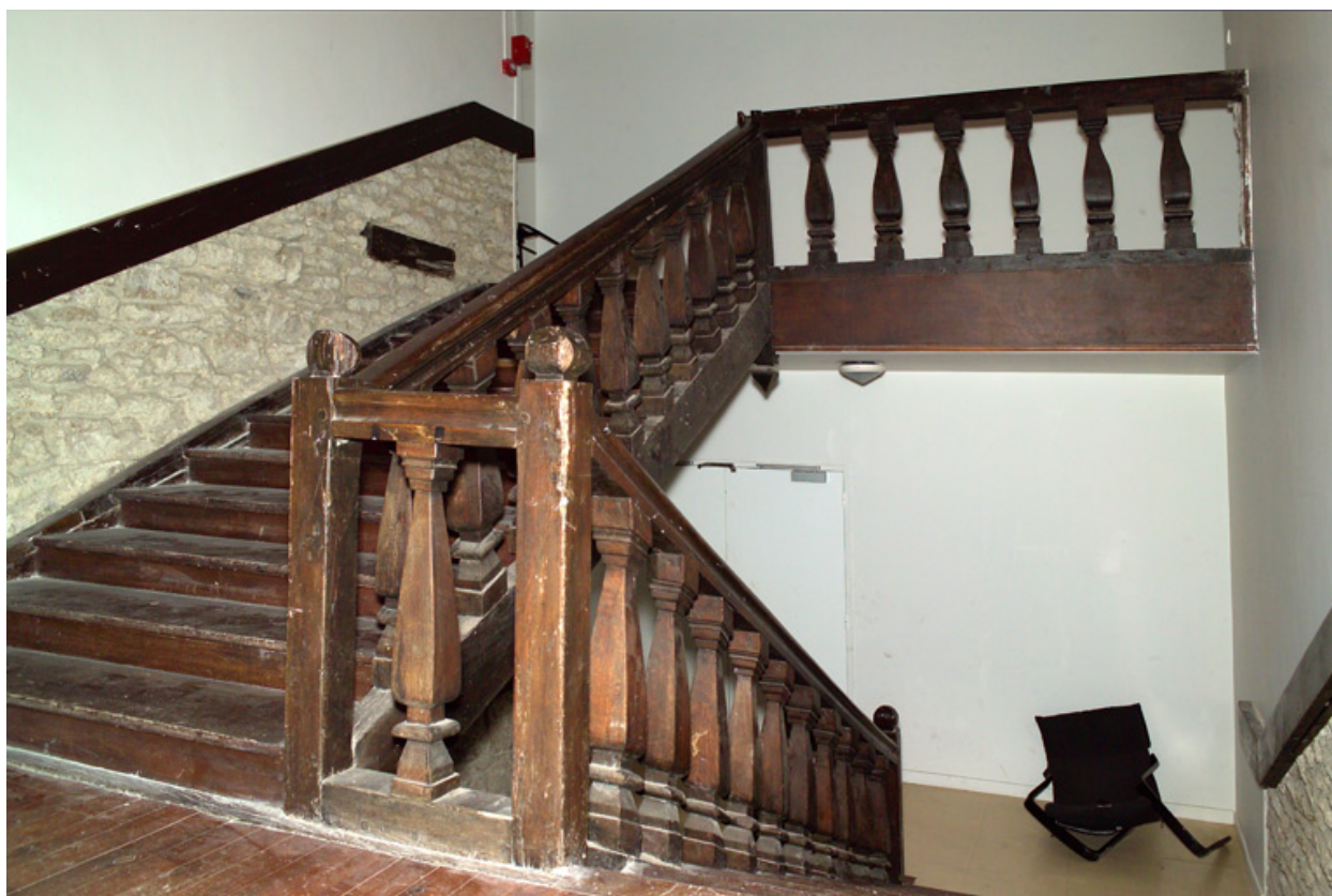
Escalier en bois du bâtiment est.
