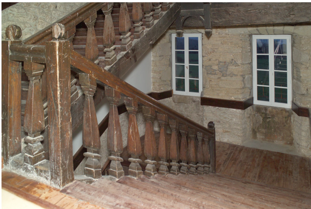
Escalier en bois du bâtiment est.
