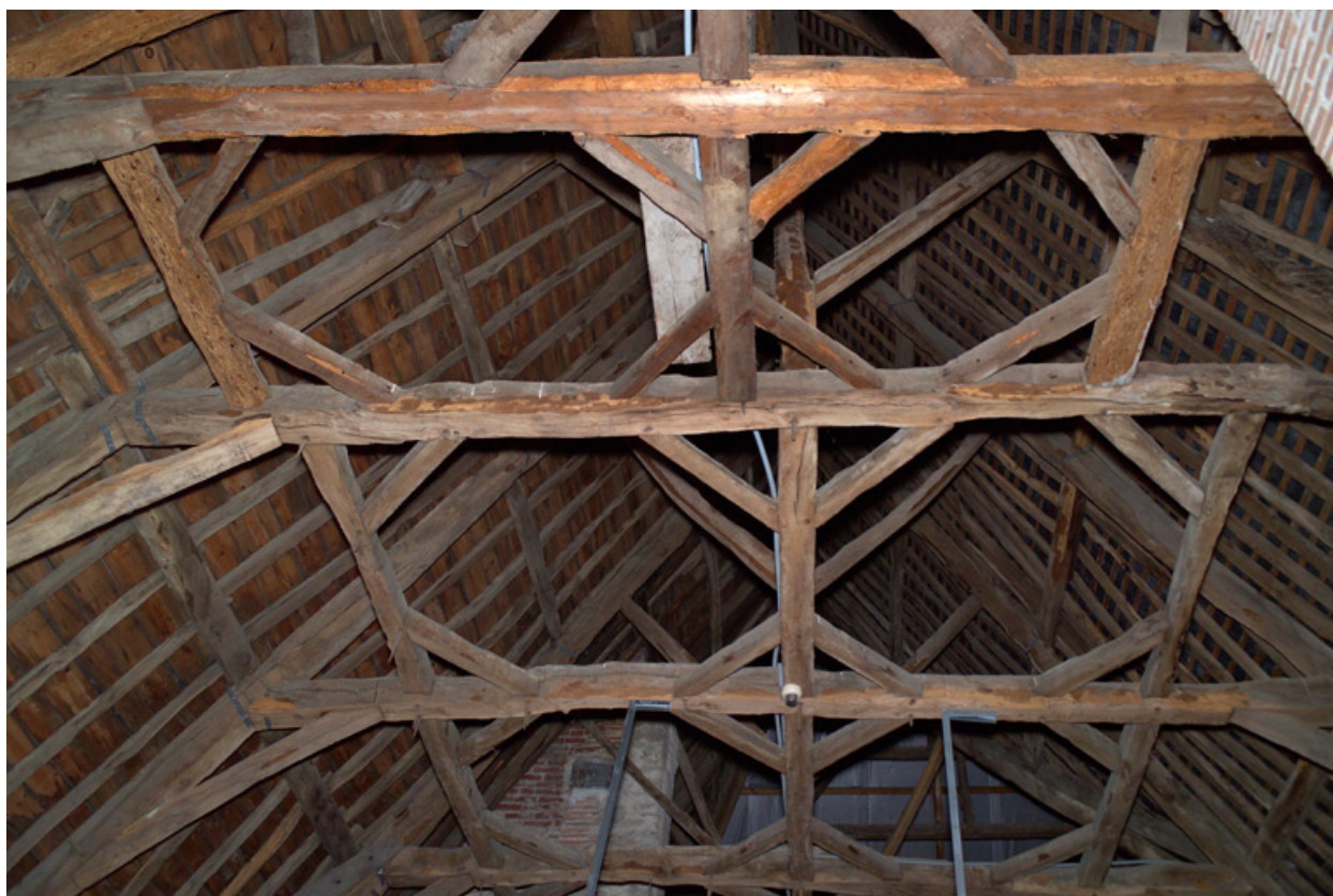
Charpente de l'aile est.
