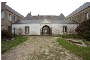
Porche d'entrée. Phot. Denis Pillet IVR52_20054402325NUCA
