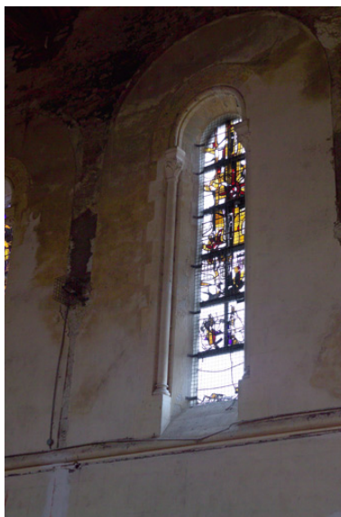
Chapelle, fenêtre haute de la nef. Phot. Denis Pillet IVR52_20054402317NUCA
