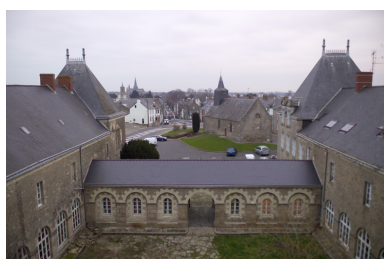
Revers du porche d'entrée. Phot. Denis Pillet IVR52_20054402289NUCA
