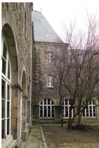
Angle intérieur sud-est, harpage. Phot. Denis Pillet IVR52_20054402330NUCA
