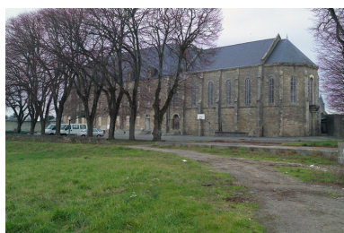
Vue générale de la façade orientale. Phot. Denis Pillet IVR52_20054402313NUCA
