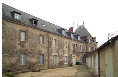
Façade extérieure nord. Phot. Denis Pillet IVR52_20054402337NUCA
