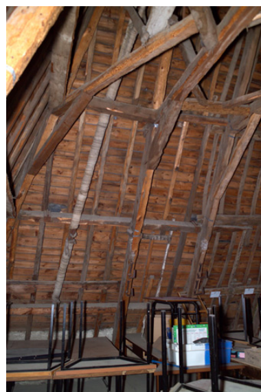
Charpente de l'aile est. Phot. Denis Pillet IVR52_20054402284NUCA
