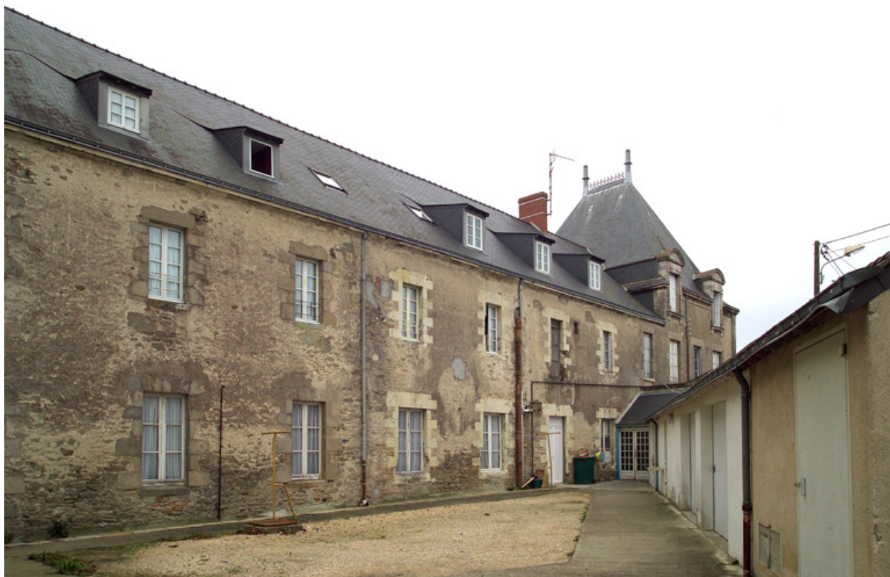
Façade extérieure nord.
