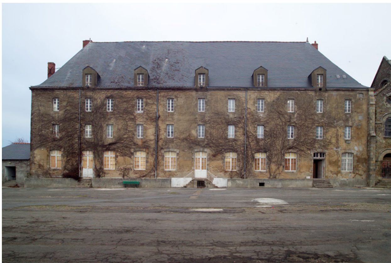
Façade arrière du bâtiment est.
