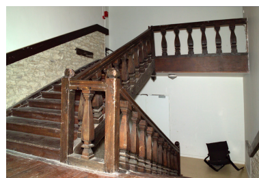
Escalier en bois du bâtiment est. Phot. Denis Pillet IVR52_20054402295NUCA
