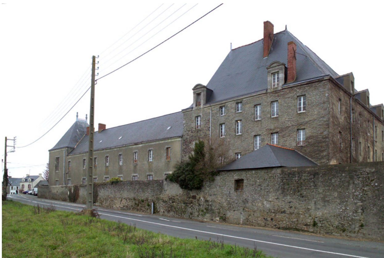
Vue générale de la façade sud.
