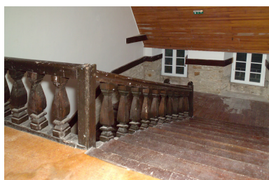
Escalier en bois du bâtiment est. Phot. Denis Pillet IVR52_20054402294NUCA
