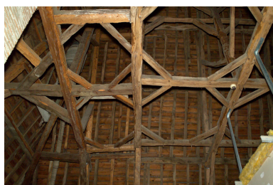
Charpente de l'aile est. Phot. Denis Pillet IVR52_20054402282NUCA
