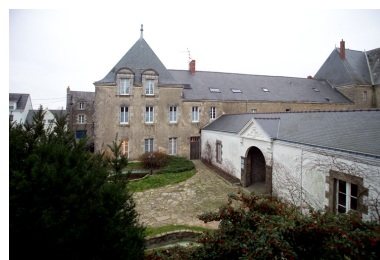
Pavillon nord-ouest et entrée. Phot. Denis Pillet IVR52_20054402322NUCA
