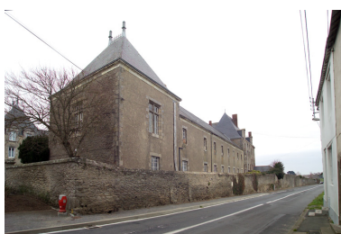
Façade sud depuis le sud-ouest. Phot. Denis Pillet IVR52_20054402338NUCA
