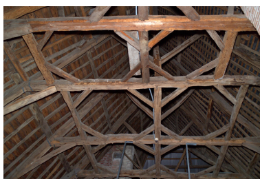
Charpente de l'aile est. Phot. Denis Pillet IVR52_20054402283NUCA
