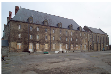
Vue générale de la façade orientale. Phot. Denis Pillet IVR52_20054402308NUCA
