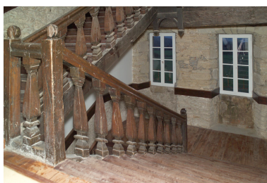
Escalier en bois du bâtiment est. Phot. Denis Pillet IVR52_20054402297NUCA
