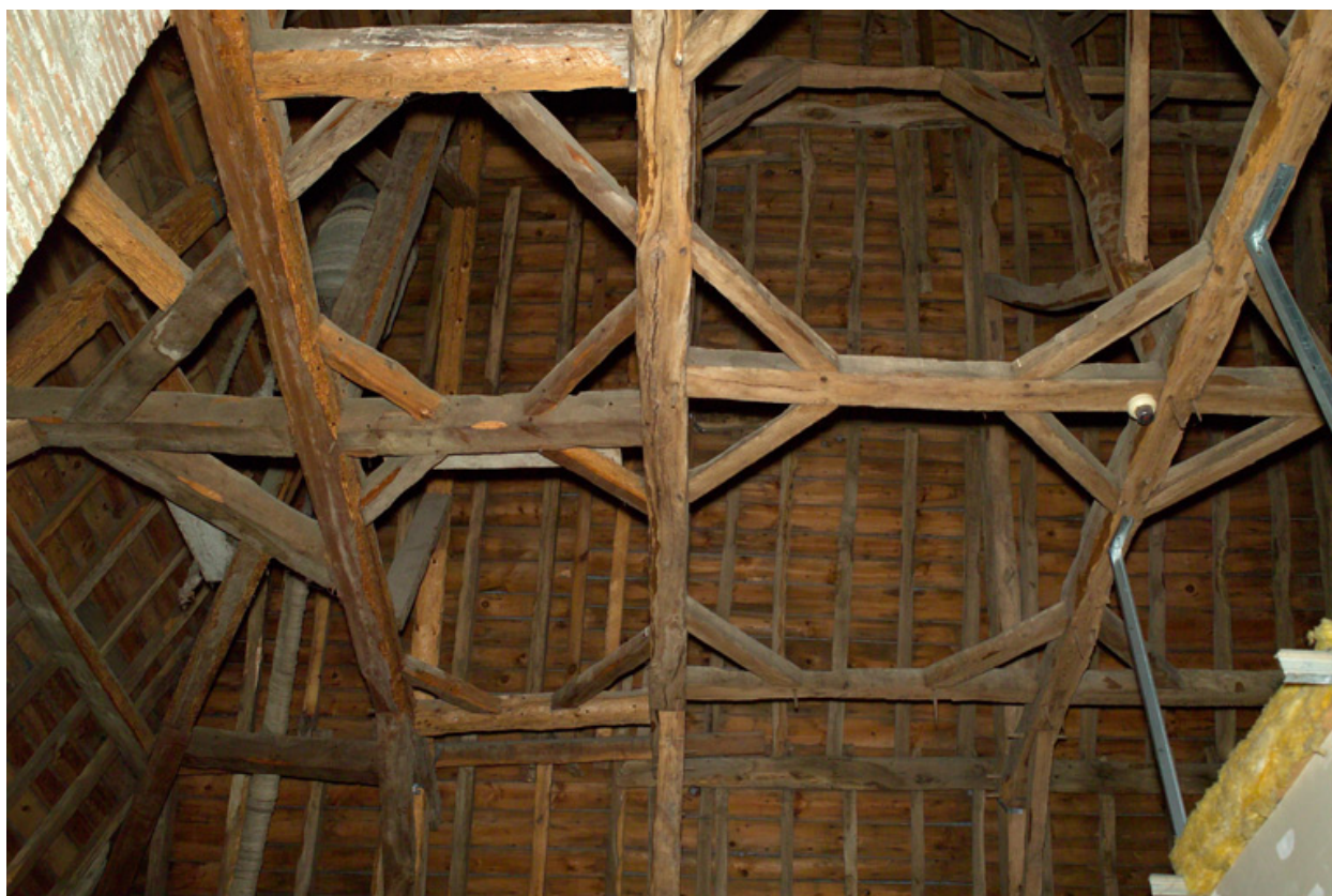
Charpente de l'aile est.
