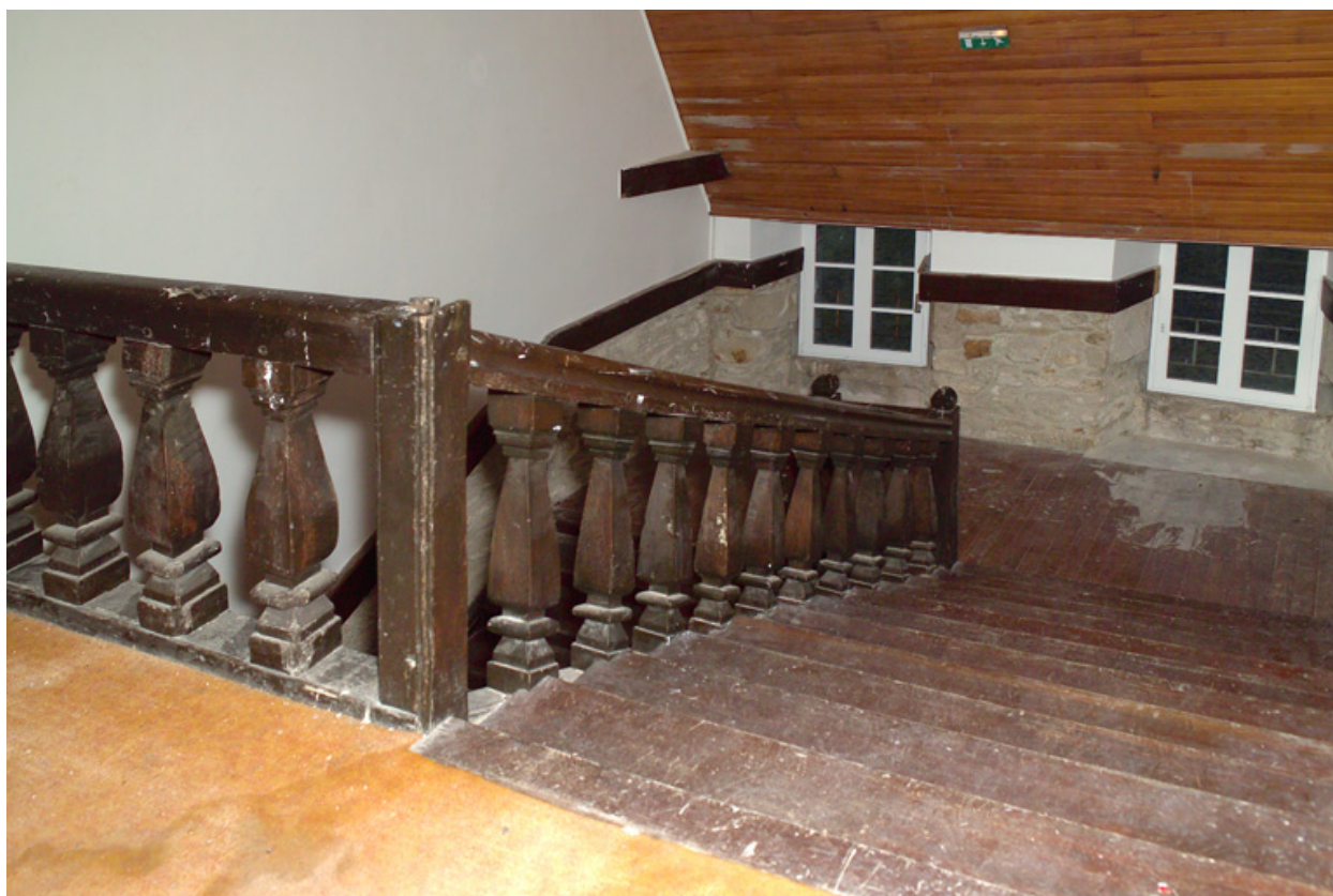
Escalier en bois du bâtiment est.
