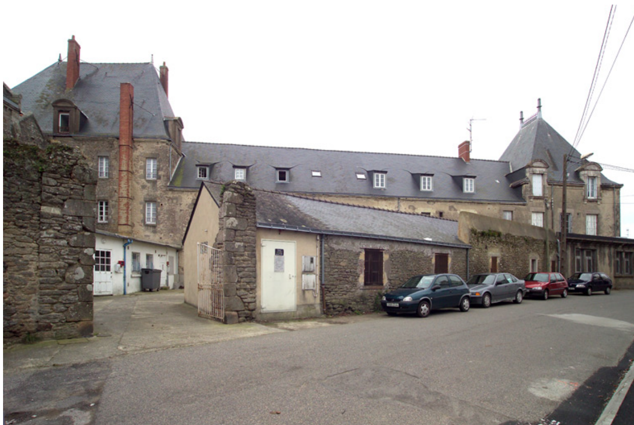
Vue générale de la façade nord.
