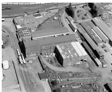
Bâtiments de l'ancienne centrale électrique de Chantenay, 1989. Phot. Denis Pillet IVR52_19894401159X
