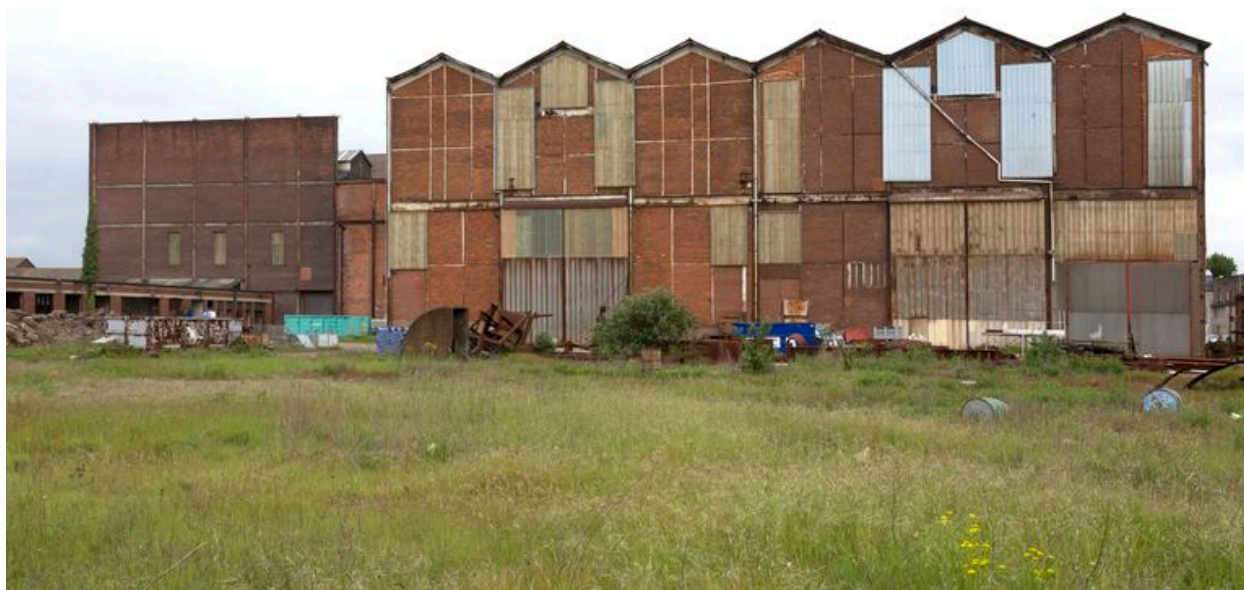
Chaufferie et extension de la grande halle, vue de la Loire.
