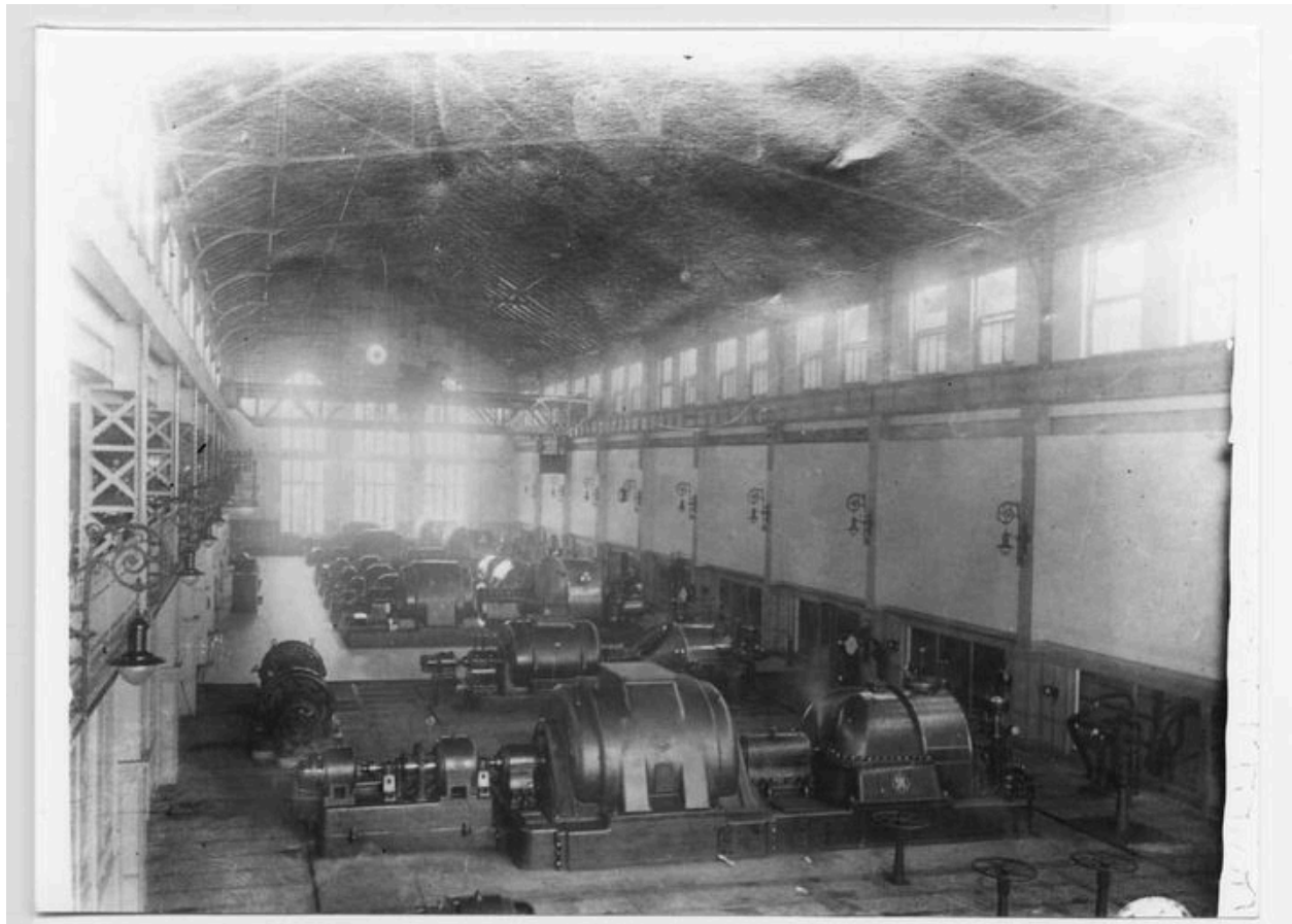
Centrale électrique de Chantenay : la grande halle et les turboalternateurs en place.
