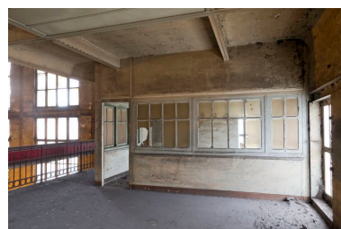
Bureaux, 2ème étage du bas côté nord. Phot. Denis Pillet IVR52_20134401793NUCA
