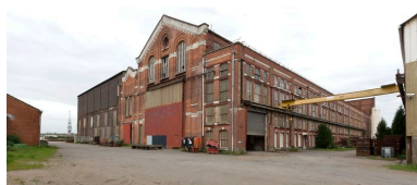
Vue d'ensemble de la centrale électrique. Phot. Denis Pillet IVR52_20134401453NUCA
