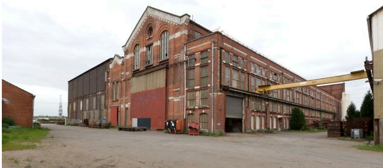
Vue d'ensemble de la centrale électrique.
