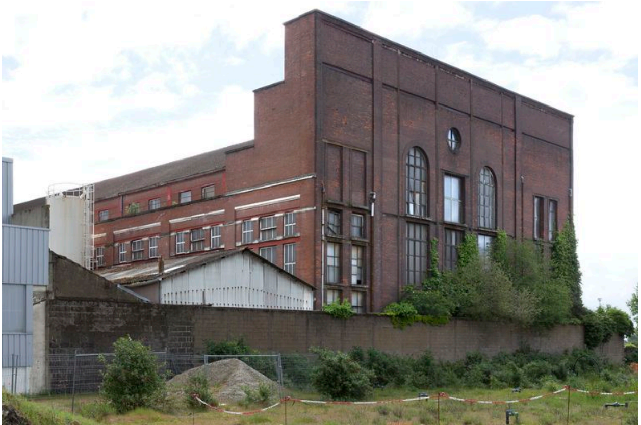
Façade ouest de la grande halle.
