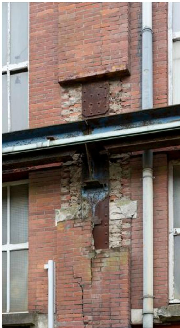
Détail de perte de décor en briques lié à l'installation d'un pont-roulant.
