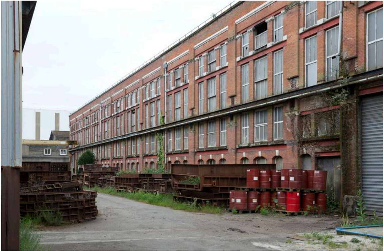
Vue du bas côté nord.
