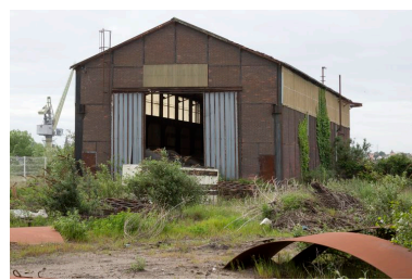
Chambre de décantation. Phot. Denis Pillet IVR52_20134401487NUCA
