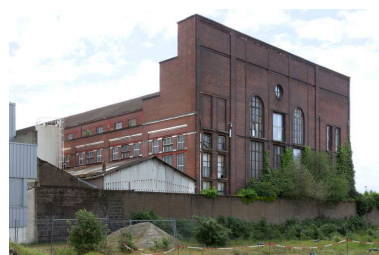
Façade ouest de la grande halle. Phot. Denis Pillet IVR52_20134401802NUCA
