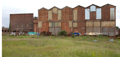
Chaufferie et extension de la grande halle, vue de la Loire. Phot. Denis Pillet IVR52_20134401478NUCA
