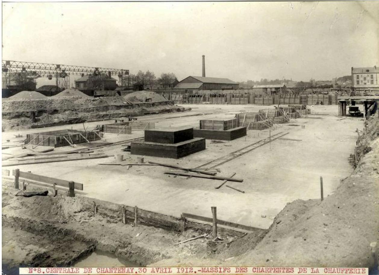
Construction de la centrale électrique de Chantenay : massifs des structures de la chaufferie.
