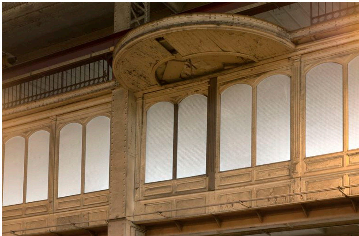
Détail de la galerie fermée de menuiseries du bas côté nord.
