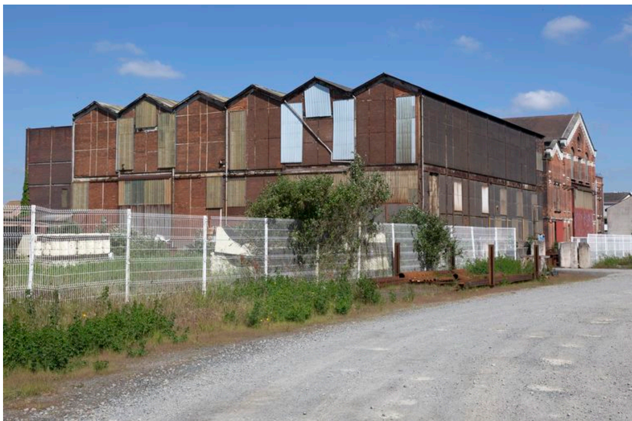
Chaufferie et halle centrale.
