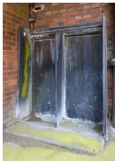
Urinoirs en ardoises des Ardoisières d'Angers. Phot. Denis Pillet IVR52_20134401489NUCA
