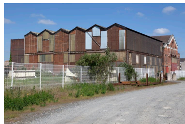
Chaufferie et halle centrale. Phot. Denis Pillet IVR52_20134402161NUCA
