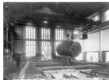
Construction de la centrale électrique de Chantenay : mise en place d'un condenseur dans la grande halle.
