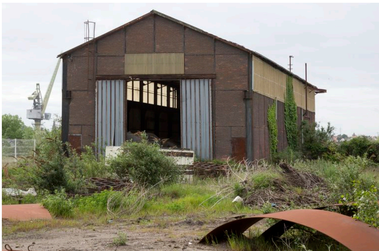
Chambre de décantation.
