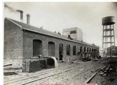
Construction des bâtiments annexes : les vestiaires. Phot. Patrick (reproduction) Jean IVR52_20134400846NUCA
