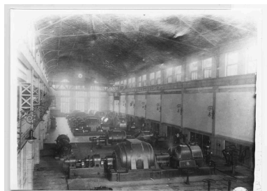
Centrale électrique de Chantenay : la grande halle et les turboalternateurs en place. Phot. Patrick (reproduction) Jean IVR52_20124400460NUCA
