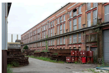
Vue du bas côté nord. Phot. Denis Pillet IVR52_20134401468NUCA
