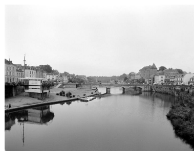
Vue d'amont depuis le pont Mac Racken. Phot. François Lasa IVR52_20025301214X
