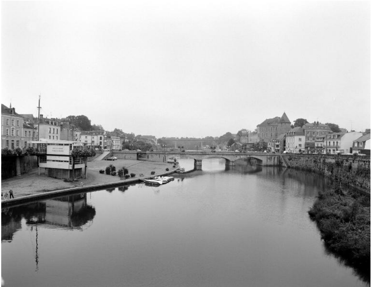
Vue d'amont depuis le pont Mac Racken.
