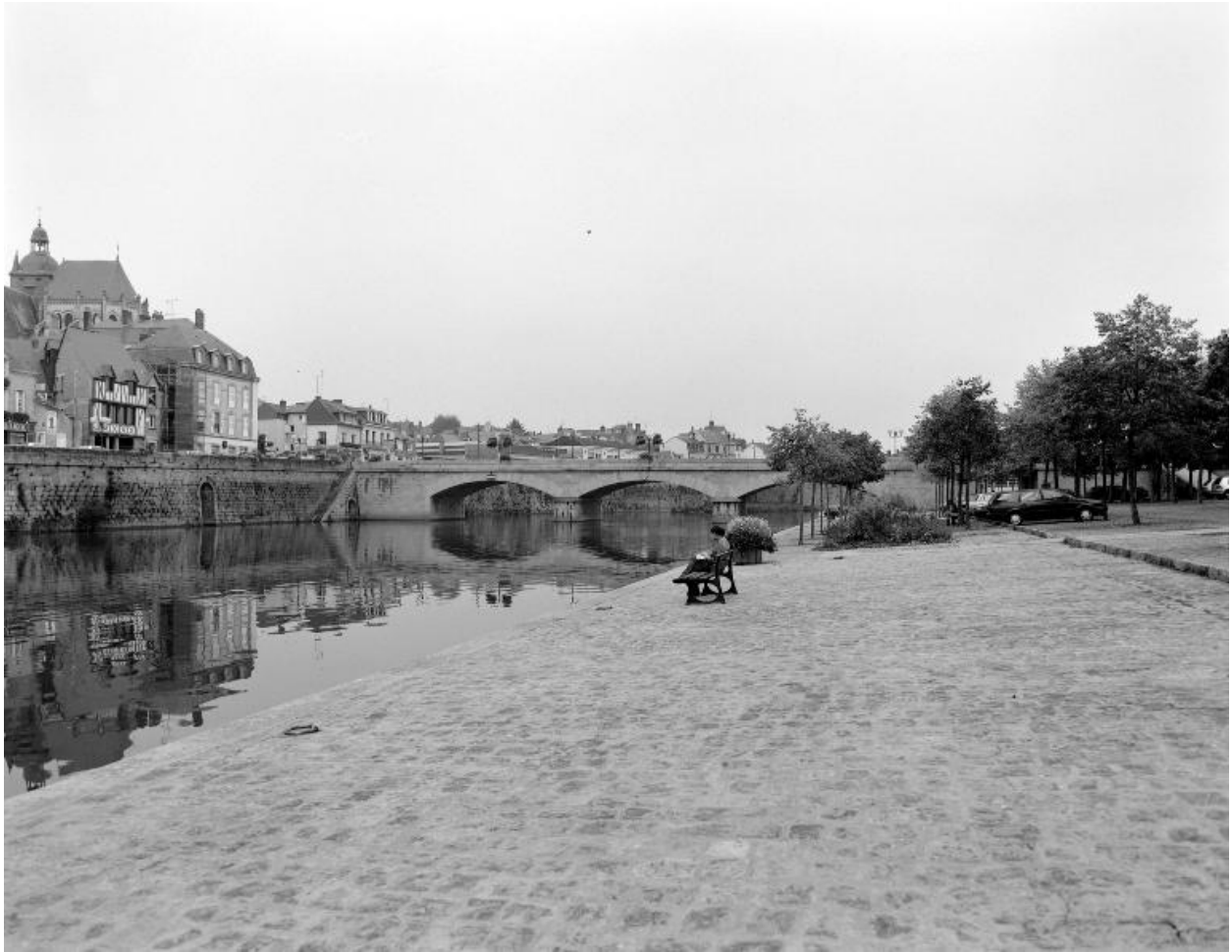
Vue d'aval depuis le port.
