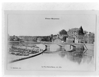
Vue d'amont, vers 1872. Autr. A. Chevrinaiis, Repro. François Lasa IVR52_20025301183X
