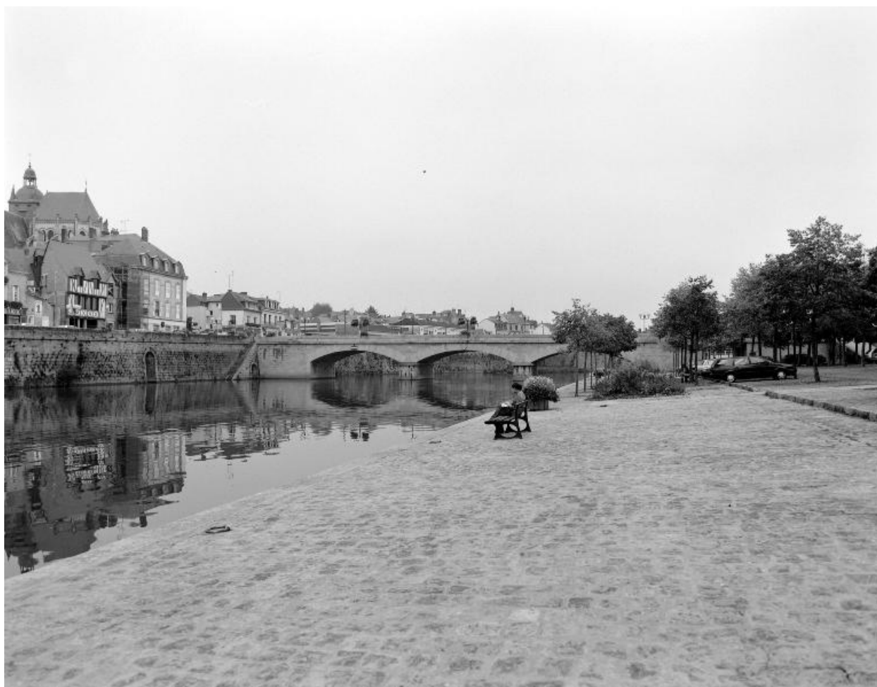
Vue d'aval depuis le port.
