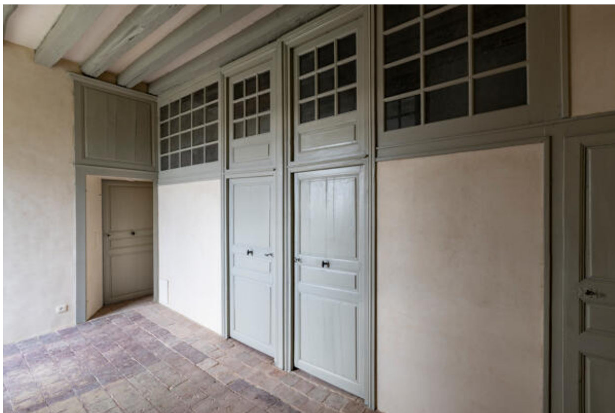
Aménagements avec portes à impostes et chassis vitrés.
