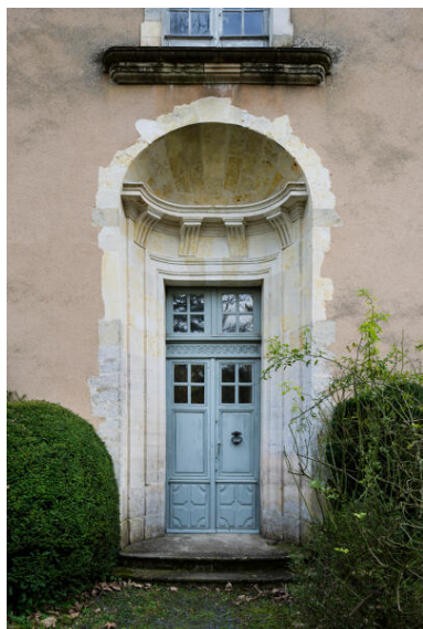
Porte ouest. Phot. Thierry Seldubuisson IVR52_20247200464NUCA
