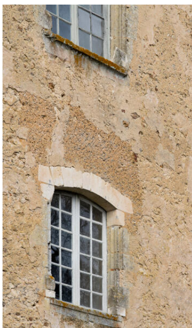
Façade est : fenêtres. Phot. Thierry Seldubuisson IVR52_20247200471NUCA
