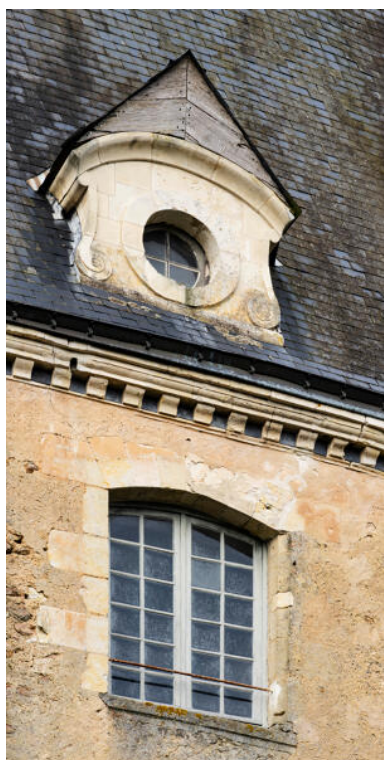
Façade est : lucarne et fenêtre. Phot. Thierry Seldubuisson IVR52_20247200469NUCA
