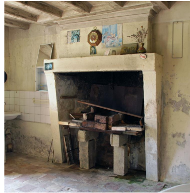
Maison 2 : cheminée. Phot. Jean-Baptiste Darrasse IVR52_20107200923NUCA
