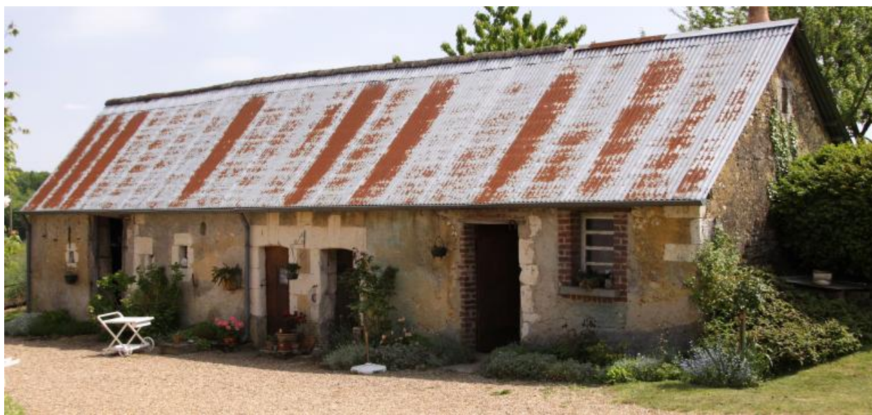
Grange, étables et buanderie, façade sur cour, face à la maison 1.
