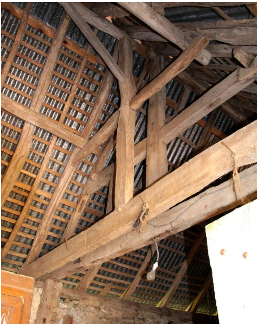
Etables et buanderie : détail de la charpente.
