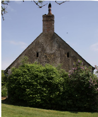
Maison 2 : mur-pignon ouest. Phot. Jean-Baptiste Darrasse IVR52_20107200922NUCA
