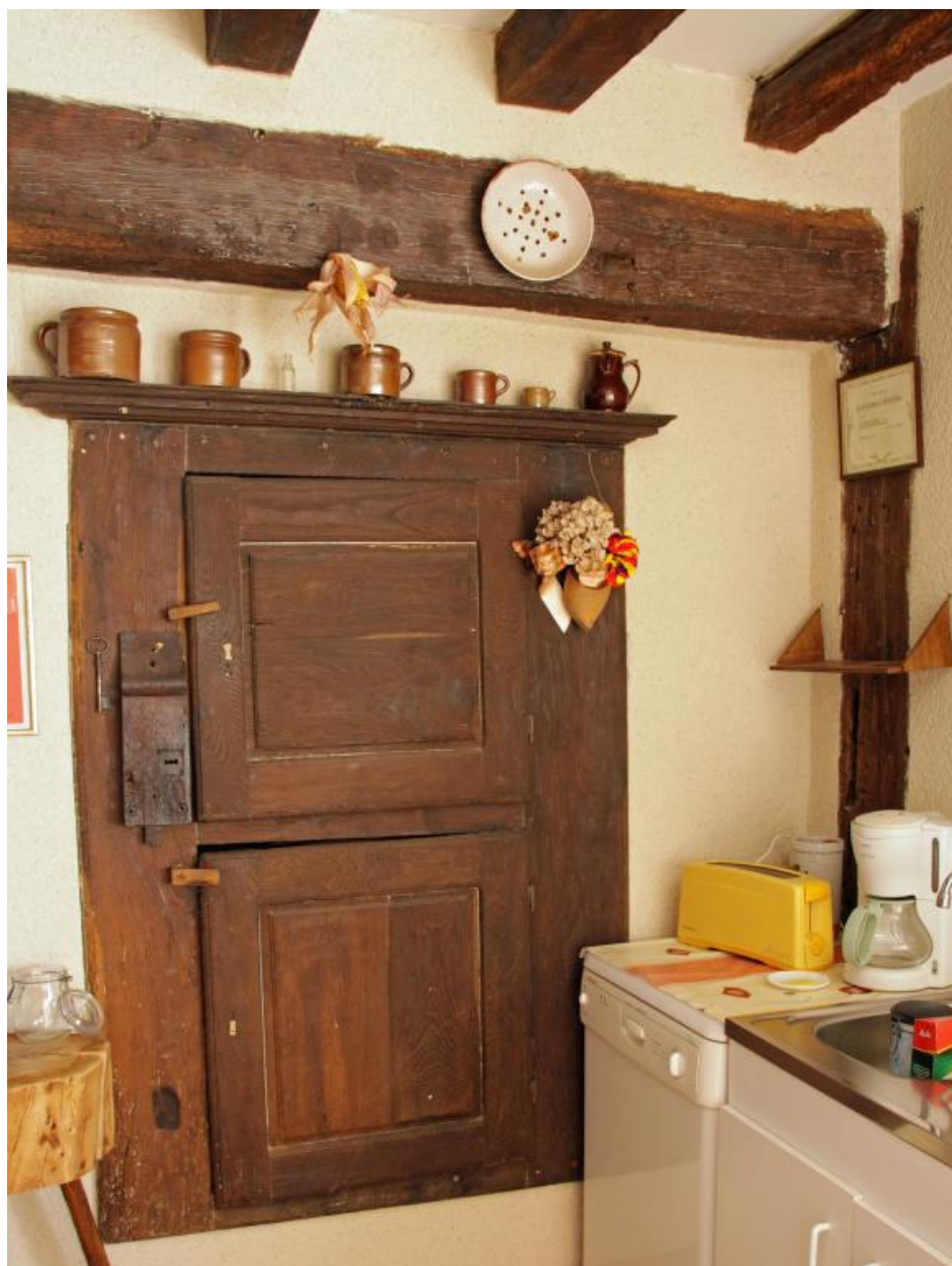
Habitat 1 (côté est) : poteau de bois et placard mural (à droite de la cheminée refaite).
