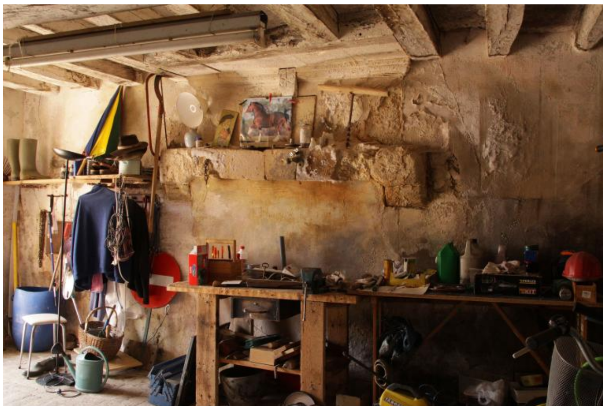
Habitat 1 (côté ouest) : vestiges de la cheminée.
