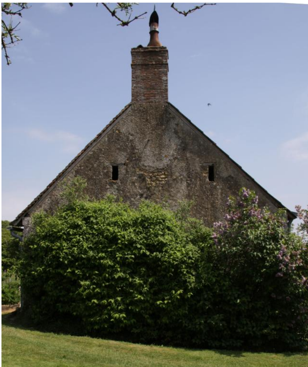
Maison 2 : mur-pignon ouest.
