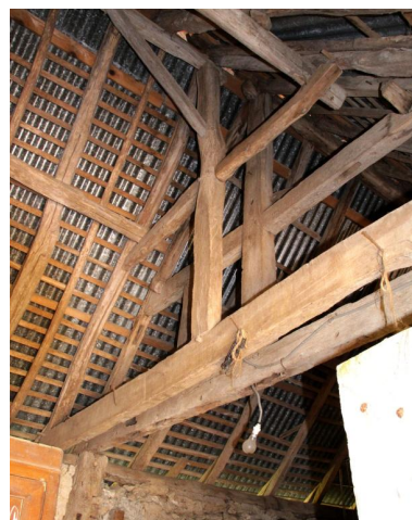
Etables et buanderie : détail de la charpente. Phot. Jean-Baptiste Darrasse IVR52_20107200927NUCA
