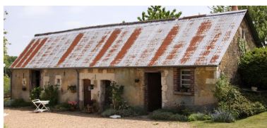
Grange, étables et buanderie, façade sur cour, face à la maison 1. Phot. Jean-Baptiste Darrasse IVR52_20107200926NUCA
