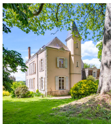
L'aile sud et sa tour. Phot. Pierre-Bernard Fourny IVR52_20235301339NUCA
