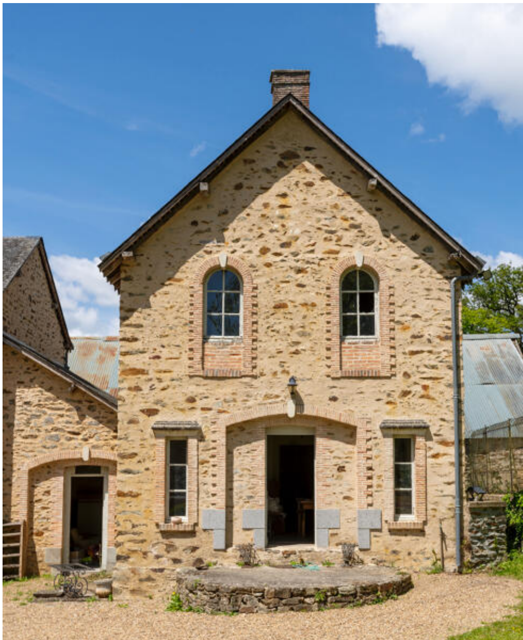
Les communs, détail du logis du personnel.
