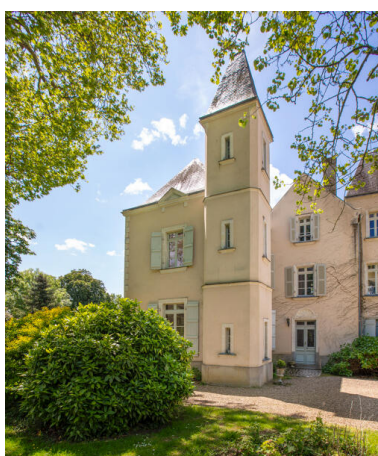
L'aile sud et sa tour. Phot. Pierre-Bernard Fourny IVR52_20235301338NUCA
