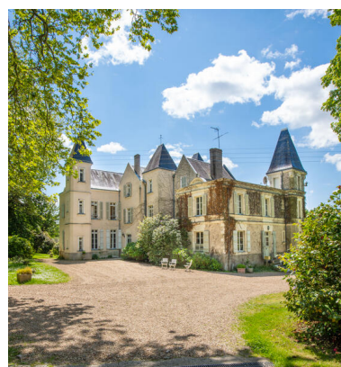
L'élévation sur cour. Phot. Pierre-Bernard Fourny IVR52_20235301333NUCA
