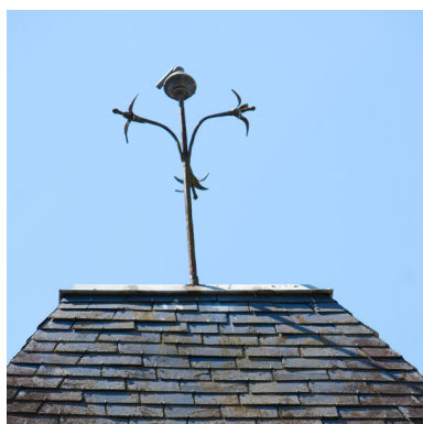
Un épi de fâitage. Phot. Pierre-Bernard Fourny IVR52_20235301358NUCA
