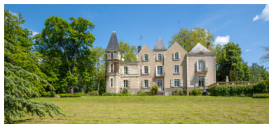
L'élévation sur le parc. Phot. Pierre-Bernard Fourny IVR52_20235301344NUCA
