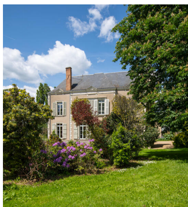
L'aile sud. Phot. Pierre-Bernard Fourny IVR52_20235301340NUCA
