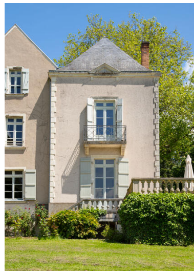
L'aile sud. Phot. Pierre-Bernard Fourny IVR52_20235301348NUCA
