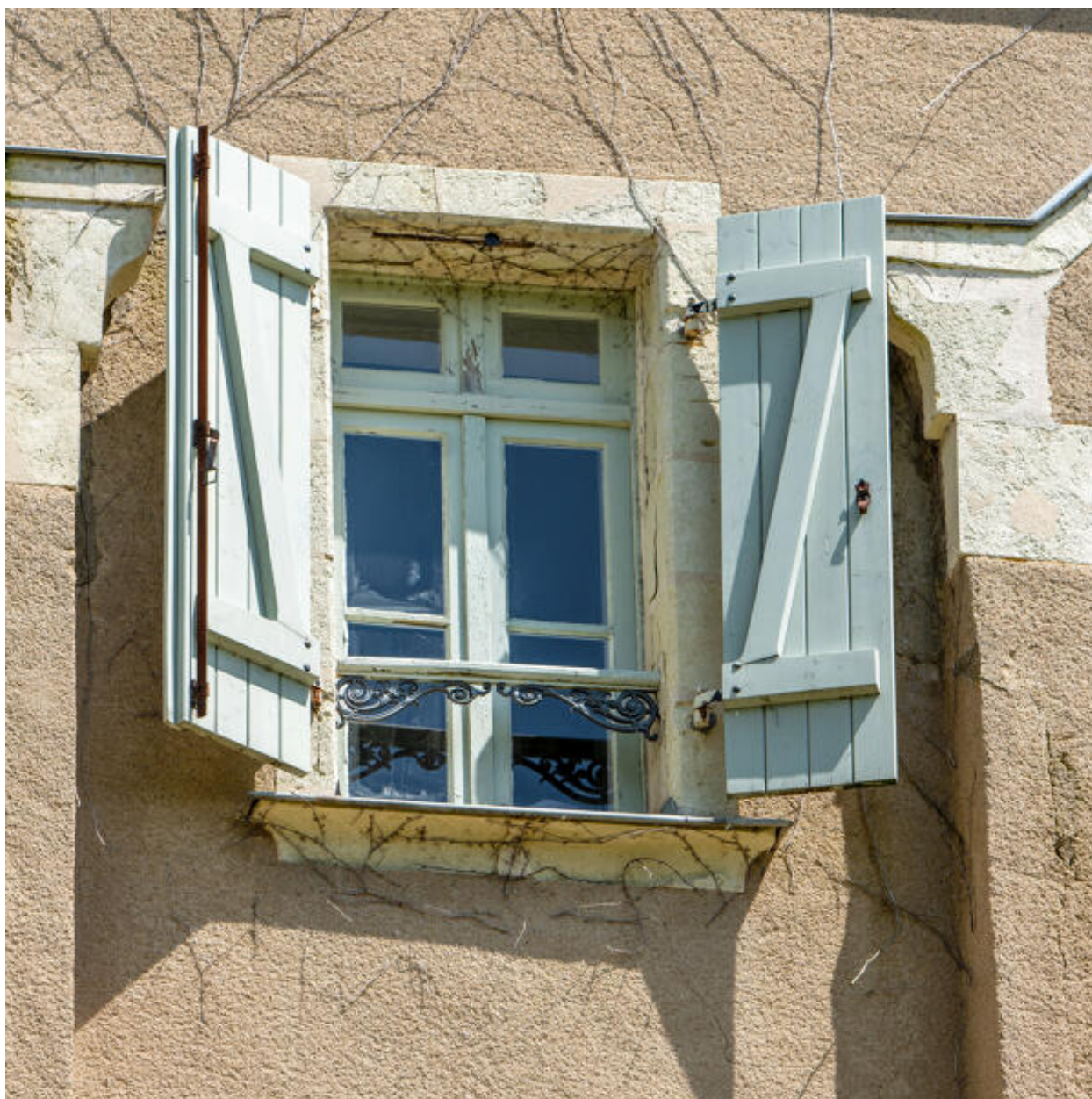
Une fenêtre du corps central.
