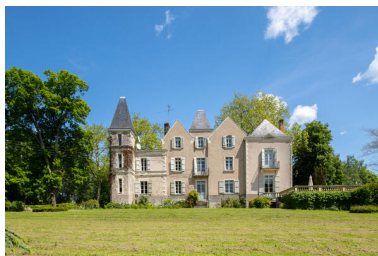
L'élévation sur le parc. Phot. Pierre-Bernard Fourny IVR52_20235301345NUCA
