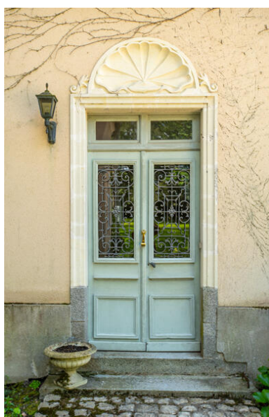
La porte sur cour. Phot. Pierre-Bernard Fourny IVR52_20235301337NUCA
