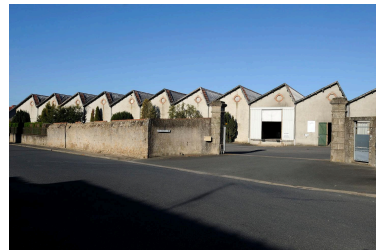
Vue générale de l'usine de ferblanterie et de conserverie Griffon de Torfou. Phot. Bruno Rousseau IVR52_20104901882NUCA
