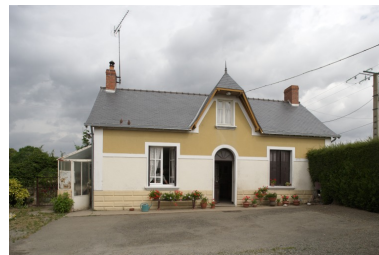
Le logis vu depuis l'est. Phot. François Lasa IVR52_20055301916NUCA
