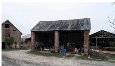
Remise. Phot. Thierry Seldubuisson IVR52_20247200130NUCA
