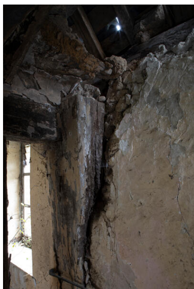
Logis : poteau de l'élévation antérieure. Phot. Thierry Seldubuisson IVR52_20247200123NUCA
