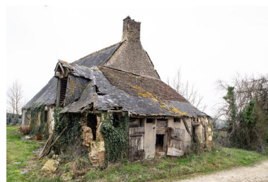
Four à pain et porcherie adossés au logis. Phot. Thierry Seldubuisson IVR52_20247200128NUCA
