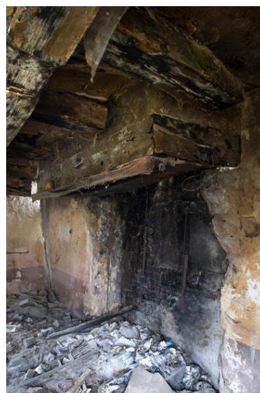
Logis : cheminée. Phot. Thierry Seldubuisson IVR52_20247200122NUCA
