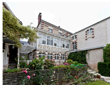
Façades sur jardin : vue d'ensemble. Phot. Yves Guillotin IVR52_20135300633NUCA
