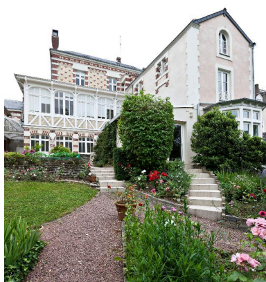
Façades sur jardin : vue d'ensemble. Phot. Yves Guillotin IVR52_20135300631NUCA
