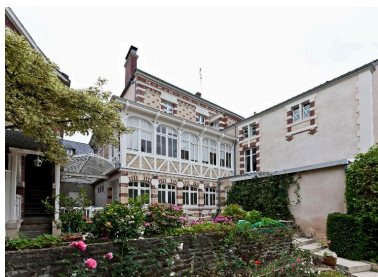
façades sur jardin : vue d'ensemble. Phot. Yves Guillotin IVR52_20135300632NUCA
