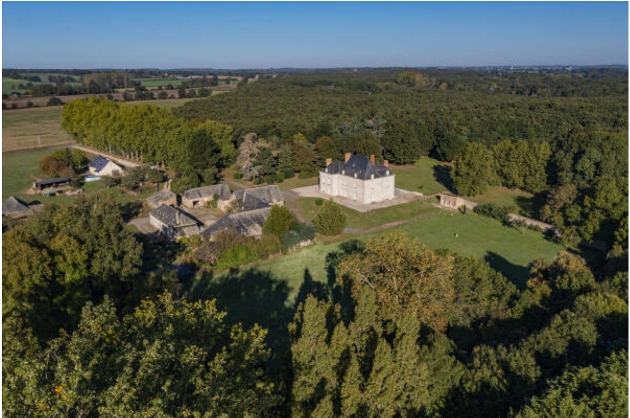
Une vue aérienne du site de la Rivière.
