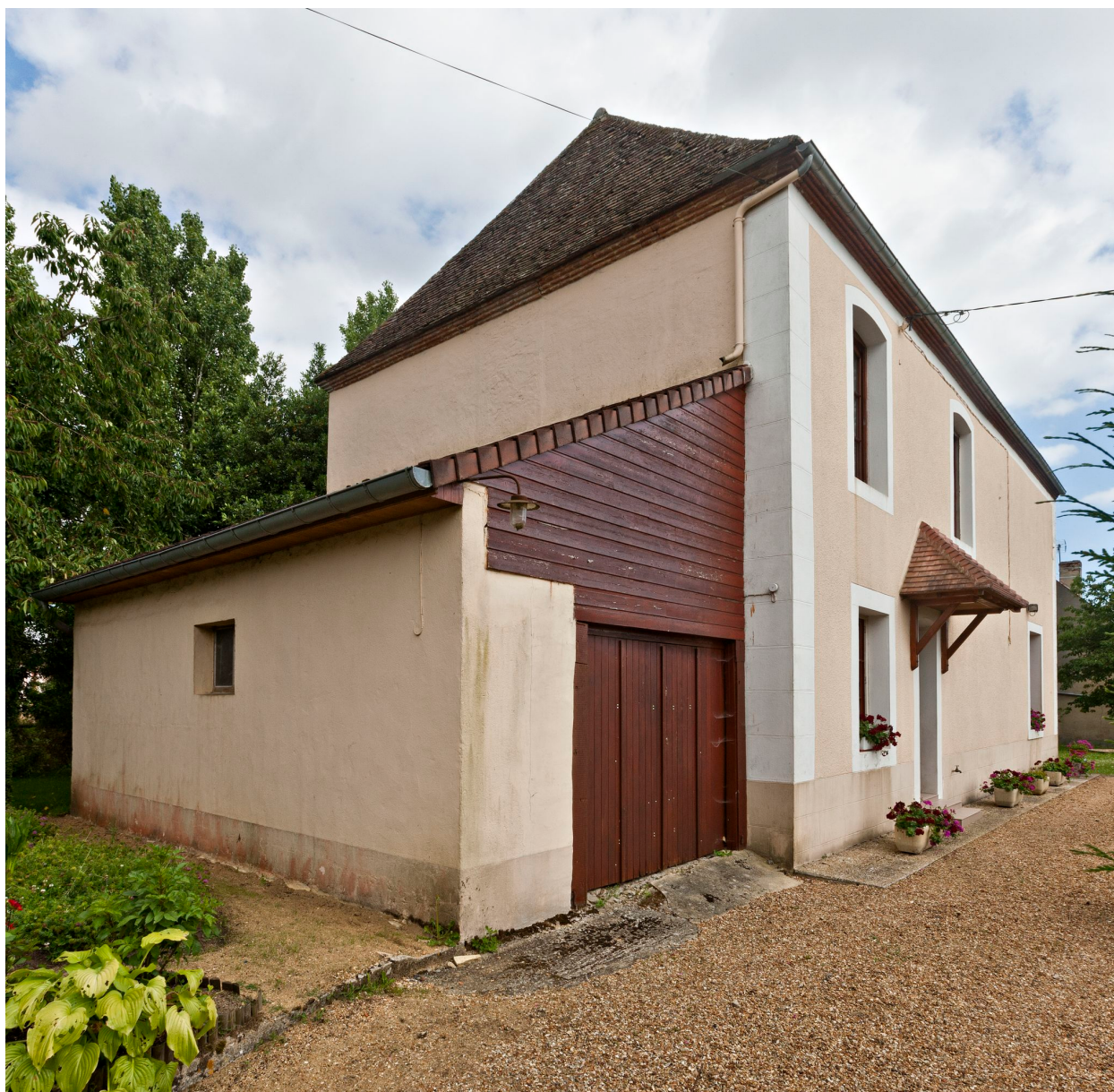
La partie subsistante du presbytère vue depuis la rue.
