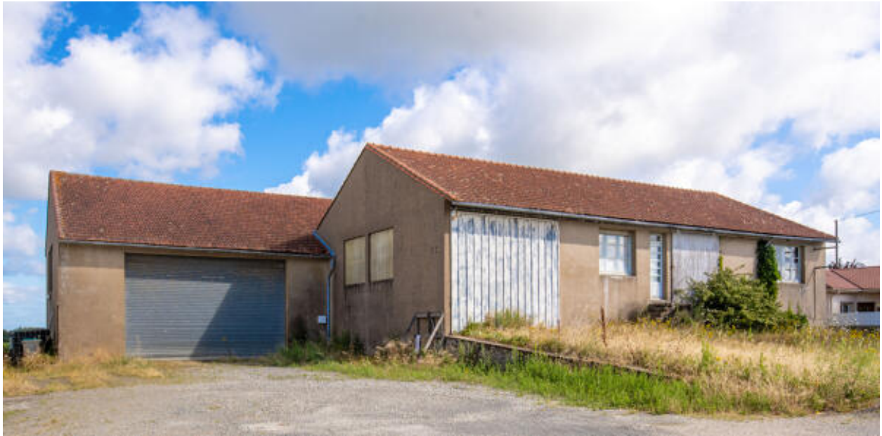
Vue générale du bâtiment d'origine et de son extension
