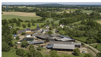
Bourg de Rennes-en-Grenouilles, vue aérienne. Phot. Yves Guillotin IVR52_20215300836NUCA
