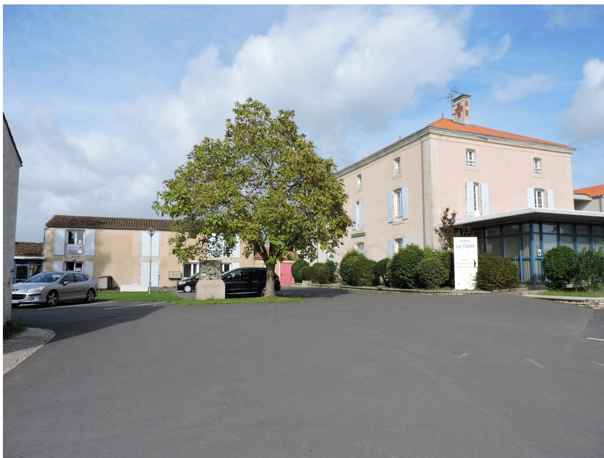
La propriété vue depuis le sud.
