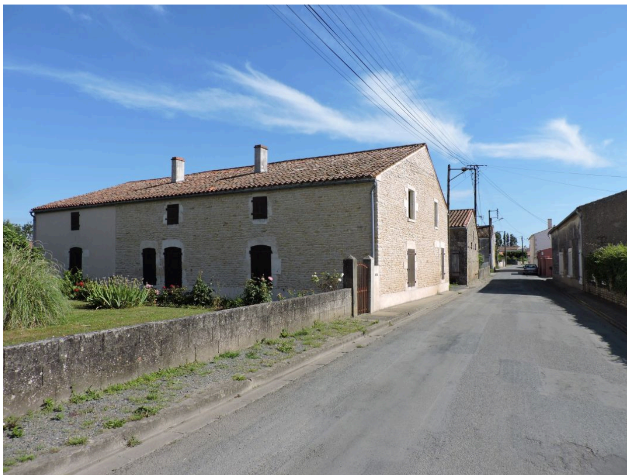
Le logis et la rue de la Guilletrie vus depuis le sud.
