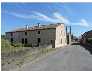
Le logis et la rue de la Guilletrie vus depuis le sud. Phot. Yannis Suire IVR52_20198501948NUCA
