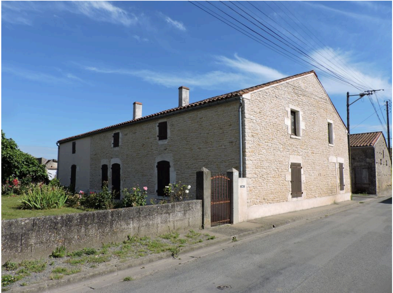
Le logis vu depuis le sud.
