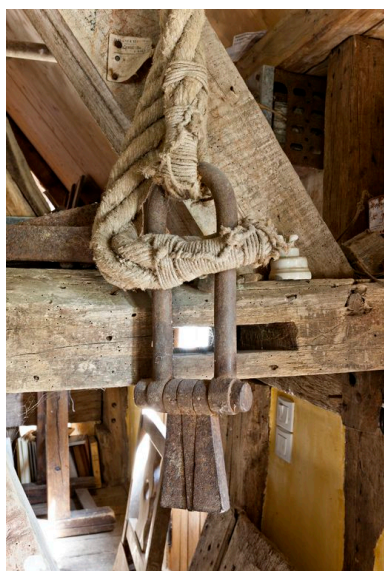
Louve du treuil à lever les meules Phot. Yves Guillotin IVR52_20137200486NUCA
