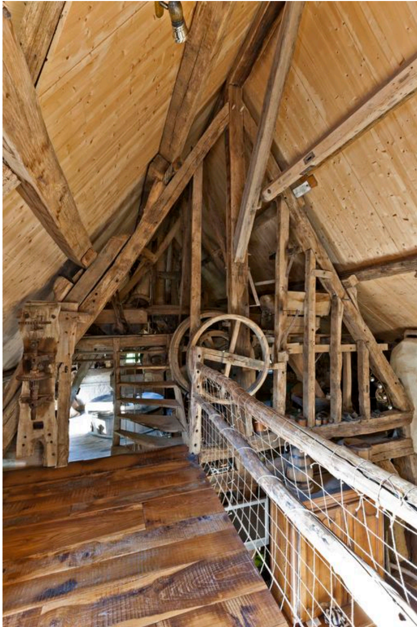
Vue intérieure de l'étage de comble du moulin. A droite, vestige du blutoir ?
