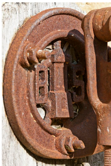
Détail de la pompe à eau Phot. Yves Guillotin IVR52_20137200462NUCA
