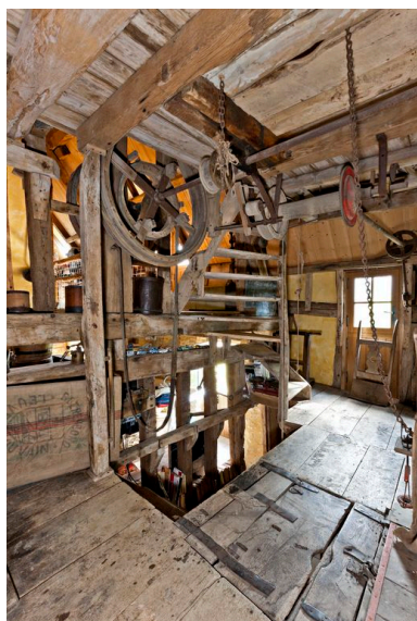
Vestiges d'un treuil lève-sacs (poulies et trappe dans le plancher). Phot. Yves Guillotin IVR52_20137200476NUCA
