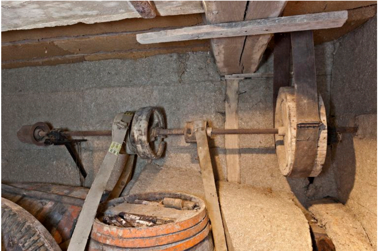
Détail de la poquerie : arbre de transmission secondaire
