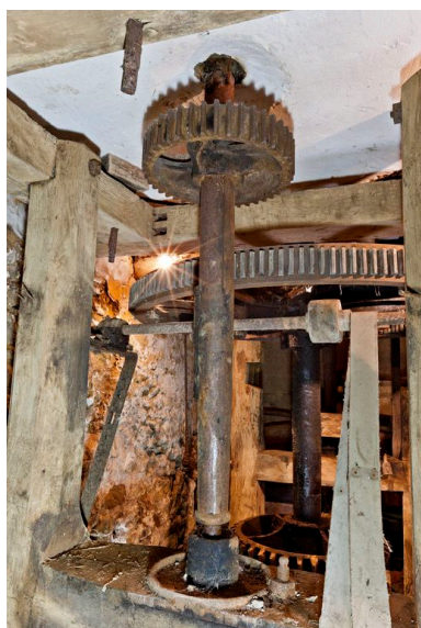
Détail de la poquerie : arbre latéral actionnant la paire de meules gauche Phot. Yves Guillotin IVR52_20137200484NUCA
