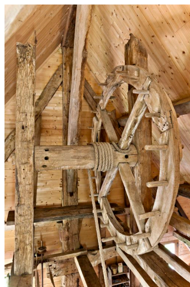
Détail du treuil à lever les meules Phot. Yves Guillotin IVR52_20137200467NUCA
