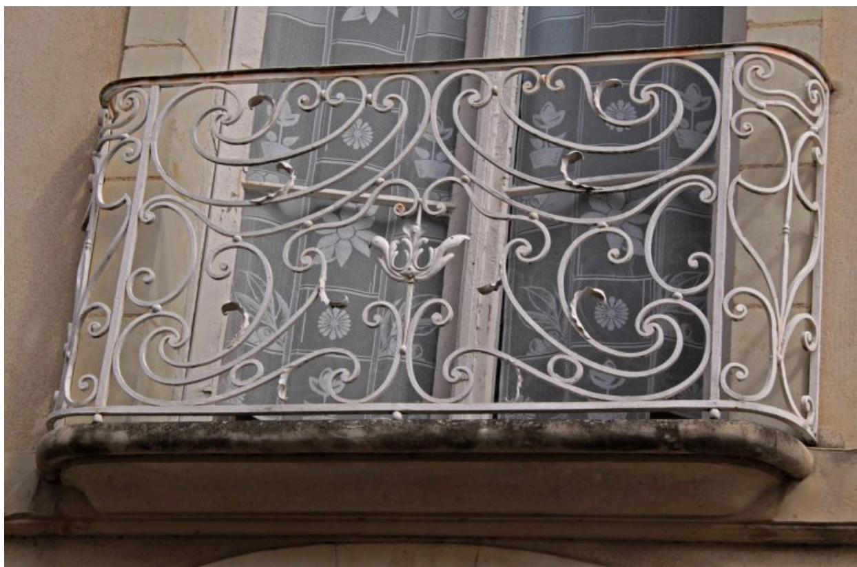
Façade antérieure, détail : grille de balcon en fer forgé.
