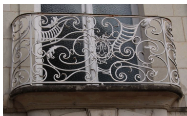
Façade antérieure, détail : grille de balcon en fer forgé. Phot. Jean-Baptiste Darrasse IVR52_20107201685NUCA
