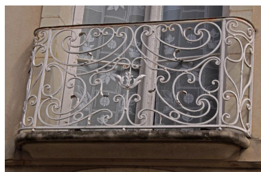
Façade antérieure, détail : grille de balcon en fer forgé. Phot. Jean-Baptiste Darrasse IVR52_20107201686NUCA
