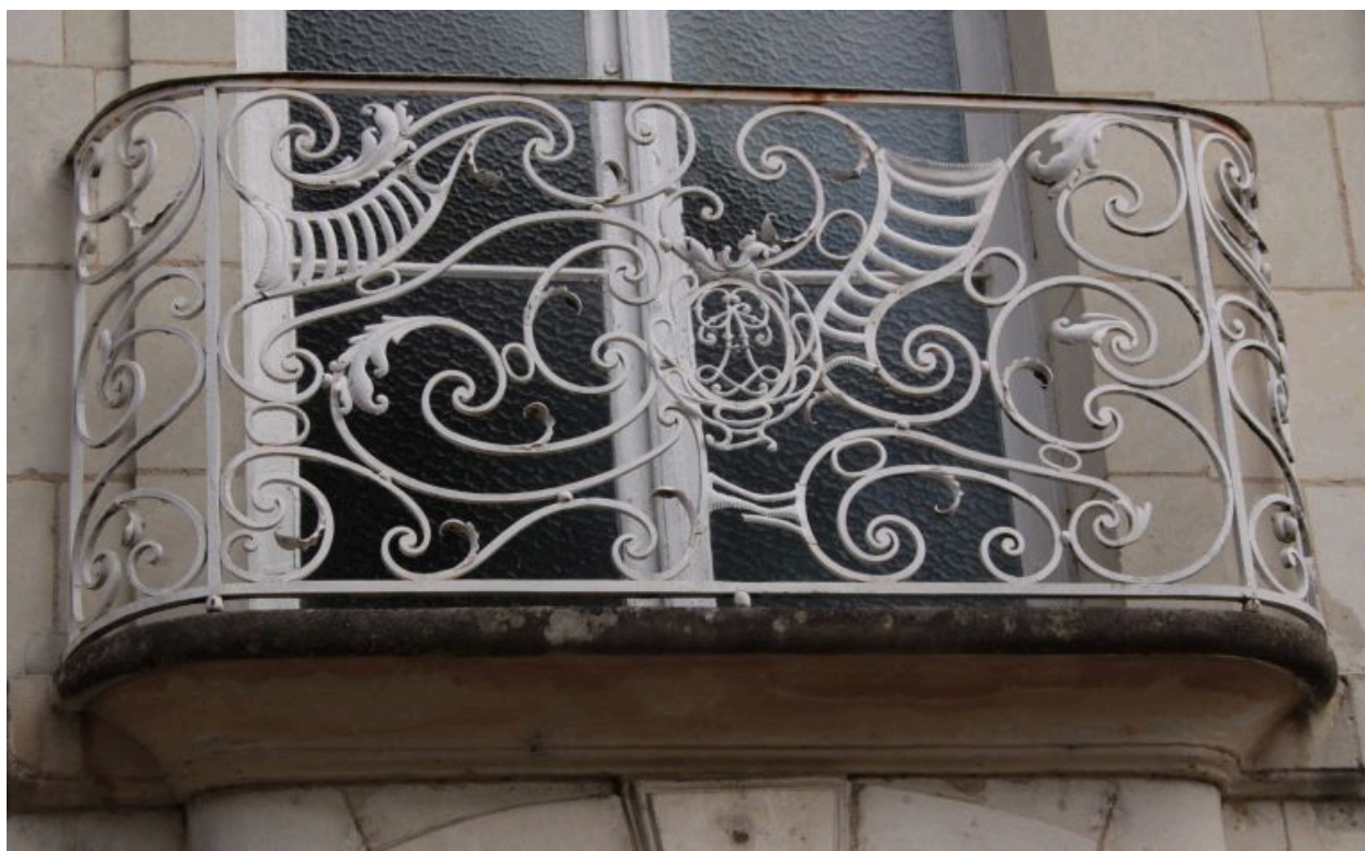
Façade antérieure, détail : grille de balcon en fer forgé.
