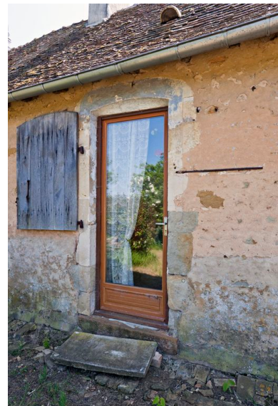
Logis : porte de l'élévation postérieure. Phot. Yves Guillotin IVR52_20117200552NUCA
