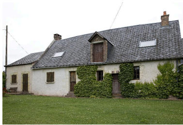
Maison, façade sur cour. Phot. Pierre-Bernard Fourny IVR52_20147200489NUCA
