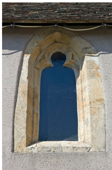
Fenêtre sud de la chapelle. Phot. Yves Guillotin IVR52_20117200496NUCA
