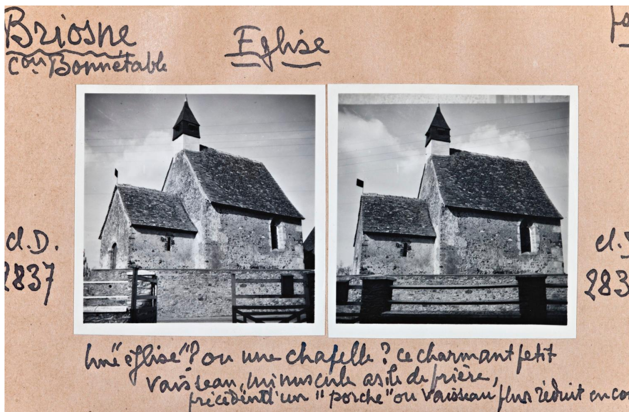
Elévation sud en 1961.
