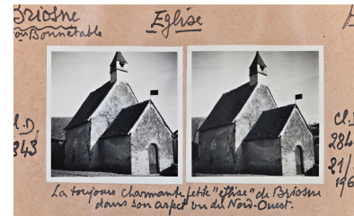
Elévations nord et ouest en 1961. Autr. Paul Cordonnier, Repro. Yves Guillotin IVR52_20127200581NUCA
