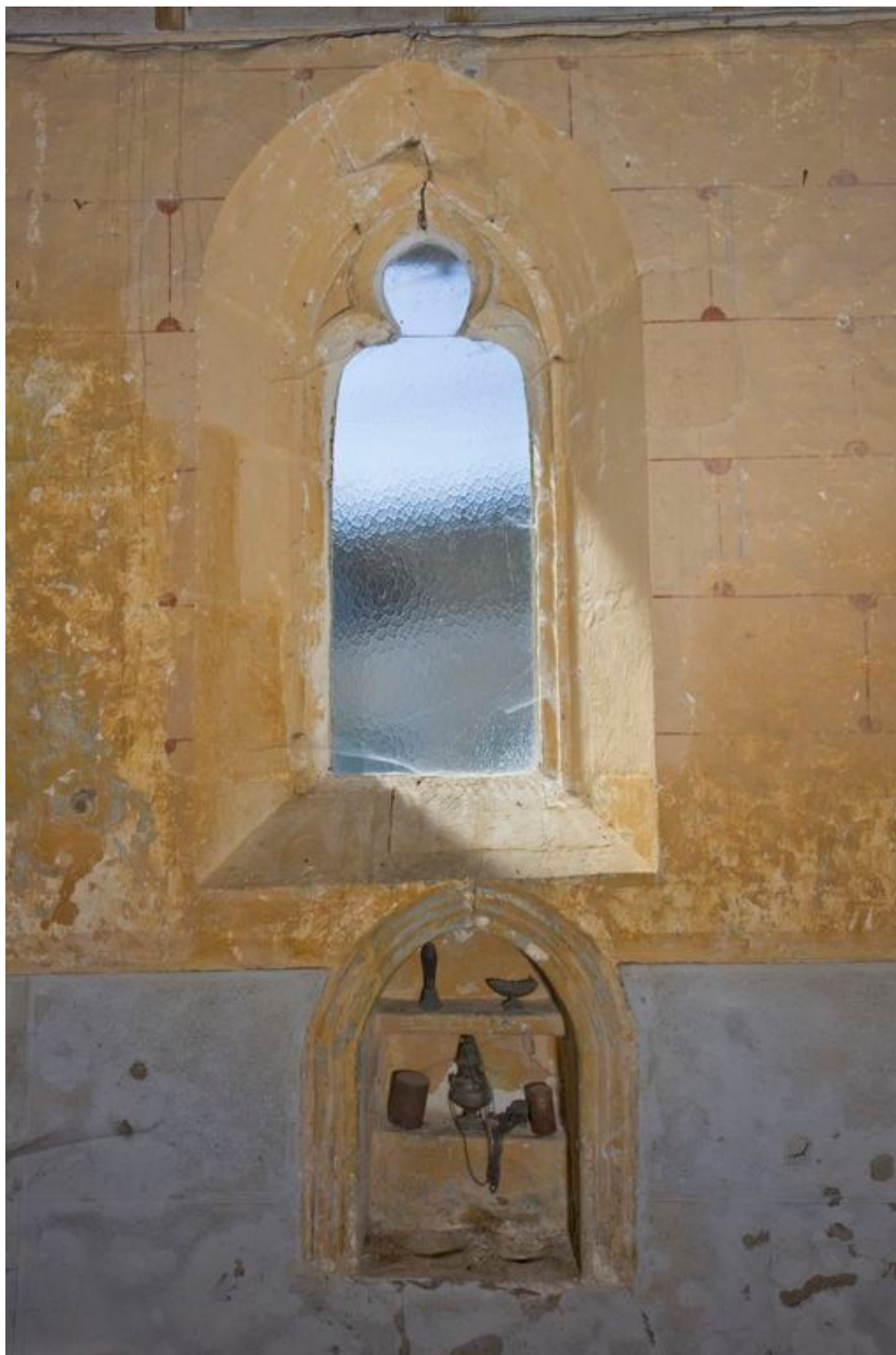
Lavabo et fenêtre sud de la chapelle.
