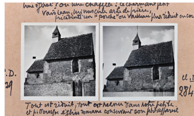
Elévation sud en 1961. Autr. Paul Cordonnier, Repro. Yves Guillotin IVR52_20127200579NUCA
