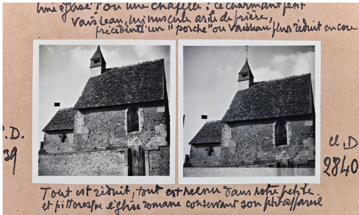
Elévation sud en 1961.
