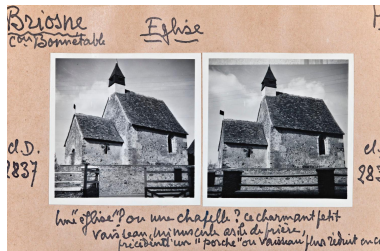
Elévation sud en 1961. Autr. Paul Cordonnier, Repro. Yves Guillotin IVR52_20127200578NUCA
