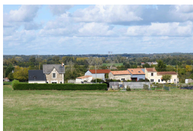
Vue d'ensemble de la maison dite le Chalet (à gauche) et du petit écart de l'Alleu (à droite). Phot. Armelle Maugin IVR52_20244901044NUCA
