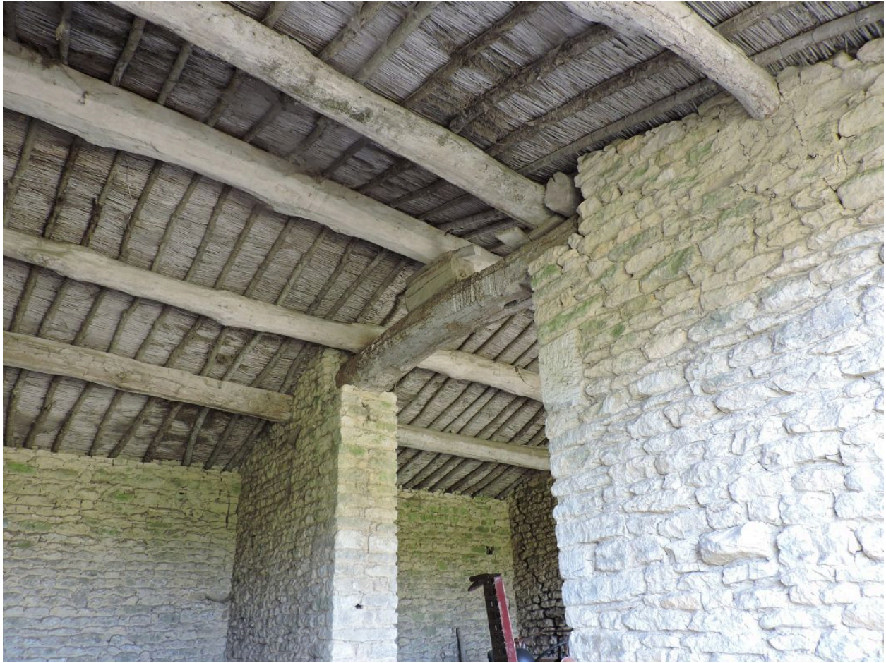
Toit en roseau du hangar en pierre.
