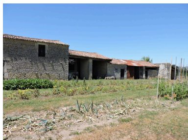
Alignement de dépendances à l'est, partie nord-est, vue depuis l'est : grange-étable, hangar, autres dépendances. Phot. Yannis Suire IVR52_20198502645NUCA
