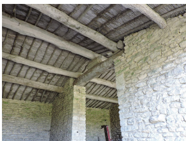
Toit en roseau du hangar en pierre. Phot. Yannis Suire IVR52_20198502608NUCA
