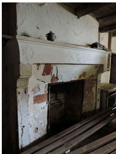
La cheminée à l'intérieur du logement sud.
