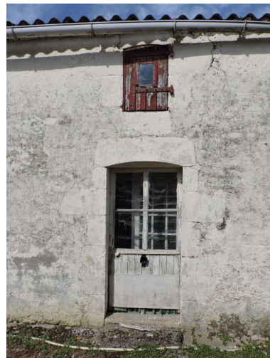
Ouvertures du logement au sud-ouest, avec linteaux en arc segmentaire ou délardé, du 18e siècle.
