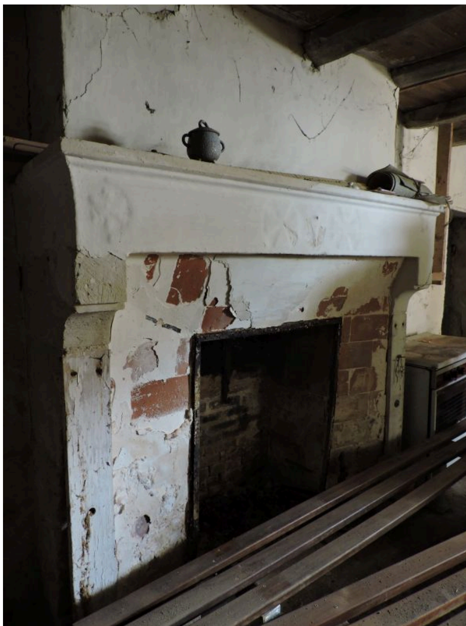
La cheminée à l'intérieur du logement sud.
