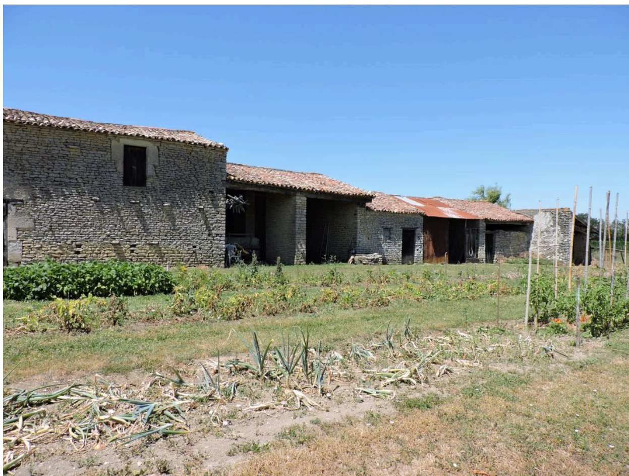
Alignement de dépendances à l'est, partie nord-est, vue depuis l'est : grange-étable, hangar, autres dépendances.
