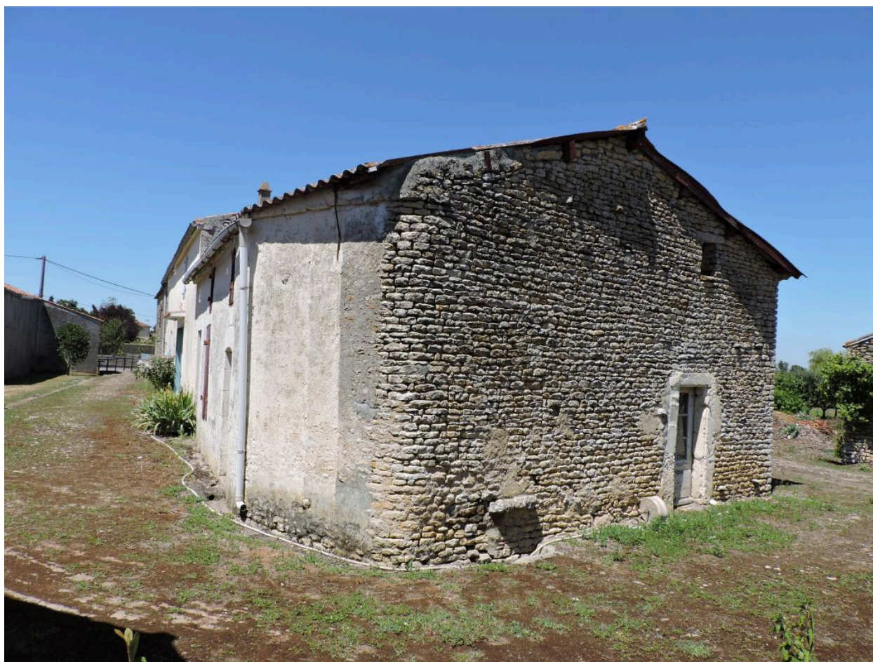
Le logis vu depuis le sud-est.
