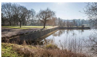
Vue de la jetée du lac depuis la rive nord. Phot. Pierre-Bernard Fourny IVR52_20197200277NUCA
