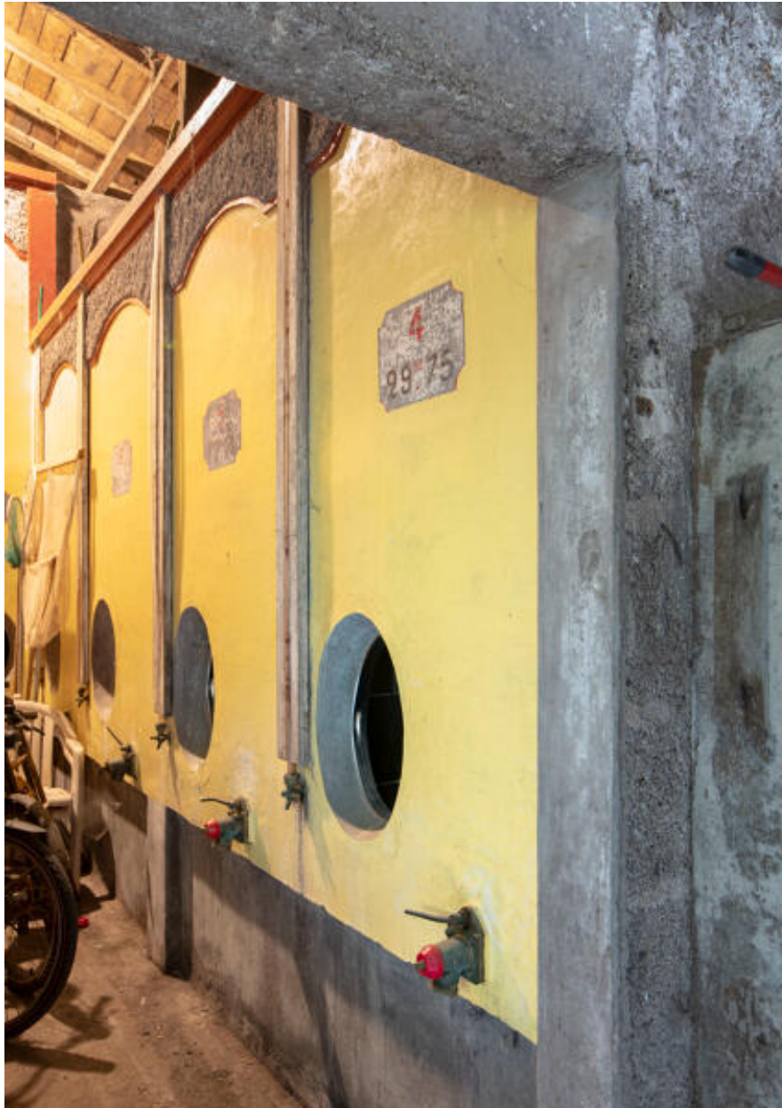
Cuverie dans le magasin primitif.
