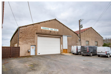
Magasin à vin principal. Phot. Pierre-Bernard Fourny IVR52_20234400090NUCA
