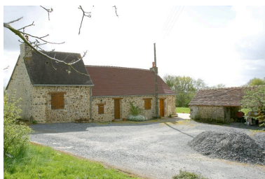
Logis est et toit à porcs-remise Phot. François Lasa IVR52_20035301397NUCA
