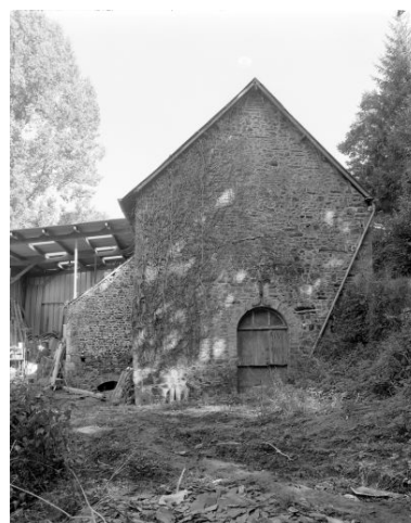
Pignon ouest du second corps de bâtiment du moulin et appentis surmontant le coursier Phot. François Lasa IVR52_19855300334X
