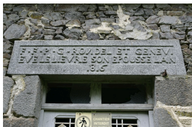
Façade principale de la maison, détail : l'inscription. Phot. François Lasa IVR52_20075300390NUCA
