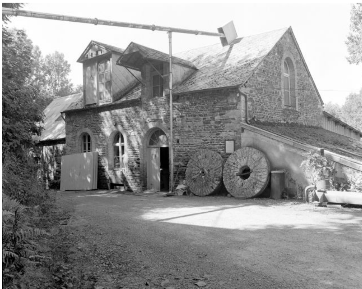
Façade principale, au sud.
