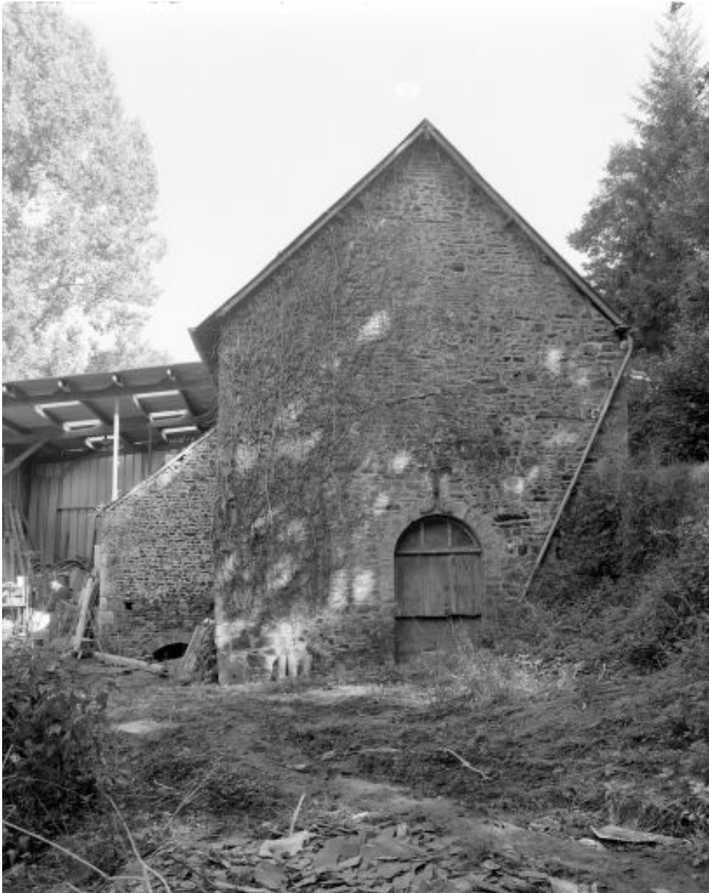
Pignon ouest du second corps de bâtiment du moulin et appentis surmontant le coursier
