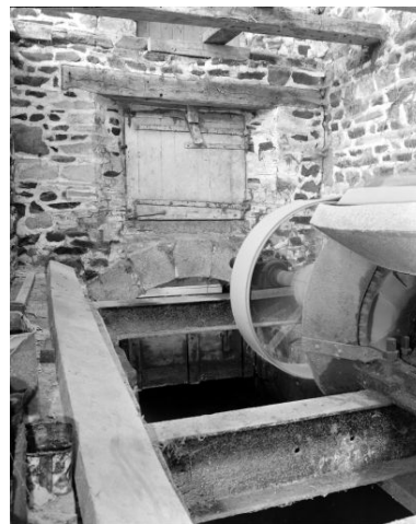
Vue intérieure du coursier. Phot. François Lasa IVR52_19855300335X
