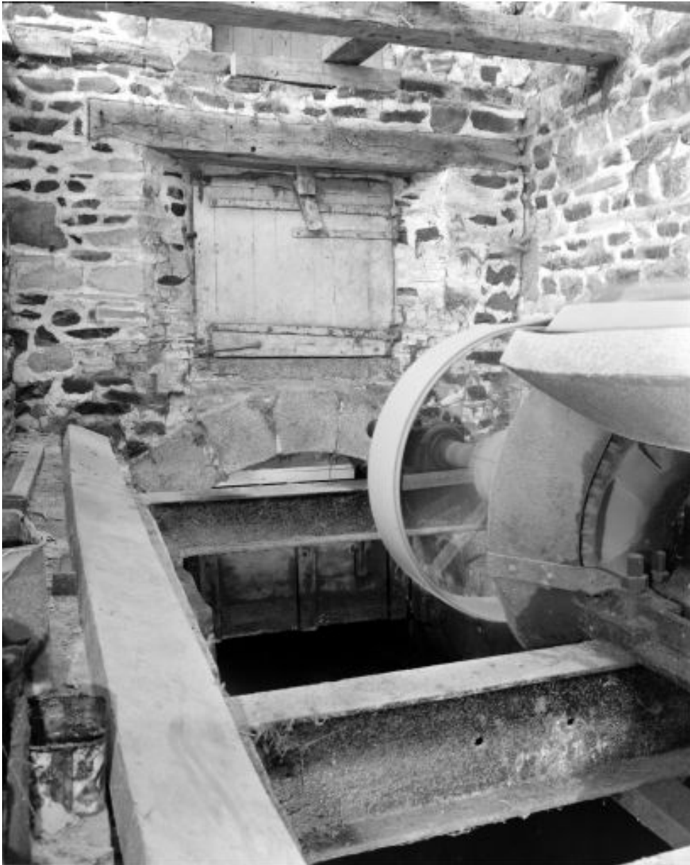
Vue intérieure du coursier.
