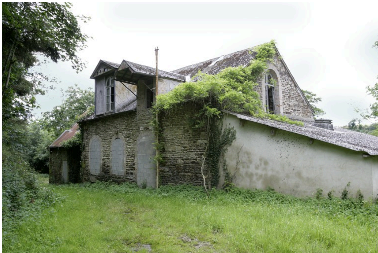
Le moulin vu depuis l'est : façade principale, au sud, et pignon est.
