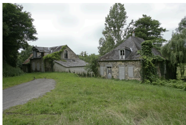
Vue d'ensemble depuis l'est en 2007 : le moulin, la maison. Phot. François Lasa IVR52_20075300388NUCA
