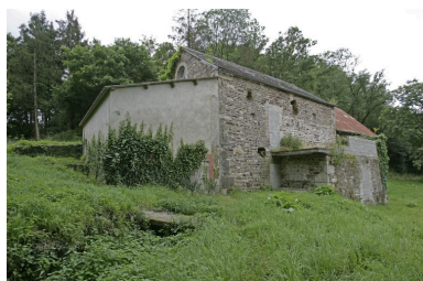
Le moulin vu depuis le nord-est. Au premier plan, l'emplacement du canal d'alimentation. Phot. François Lasa IVR52_20075300393NUCA
