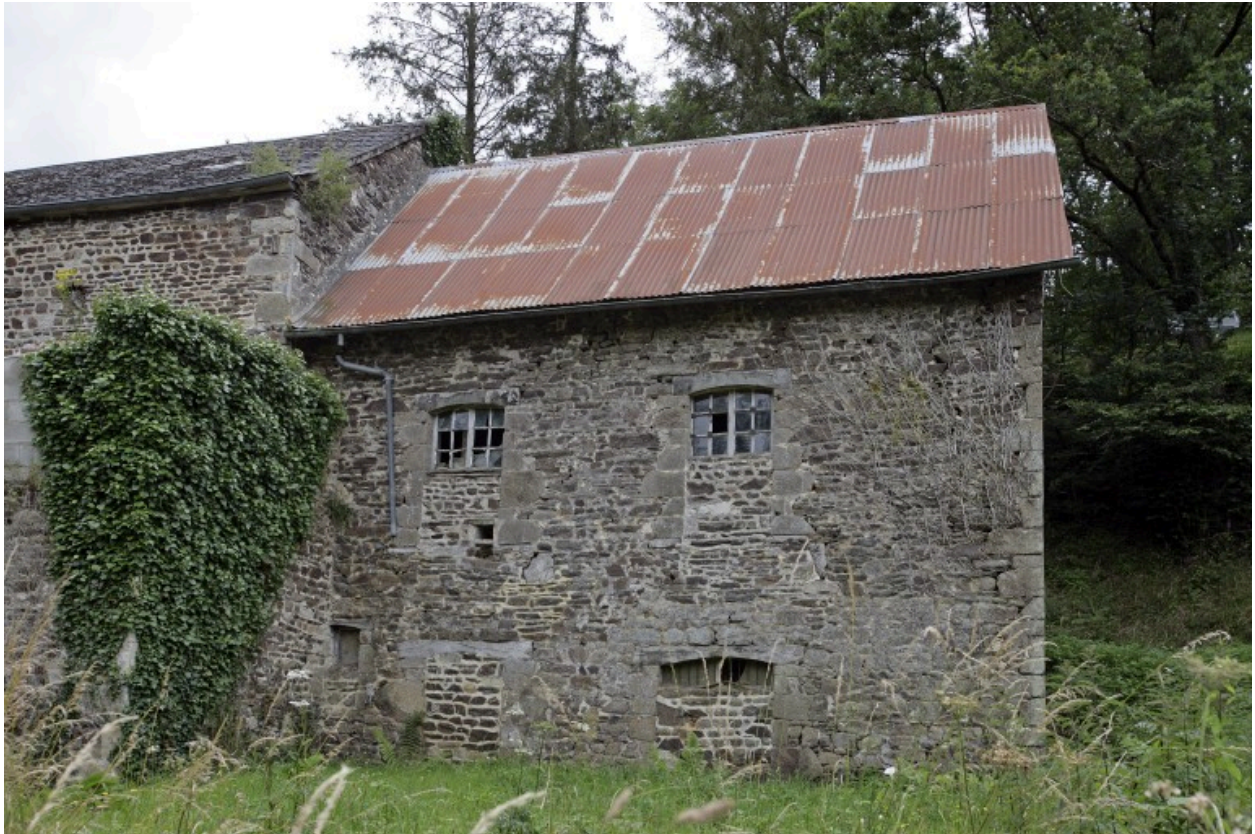
Le second corps de bâtiment du moulin vu depuis le nord.
