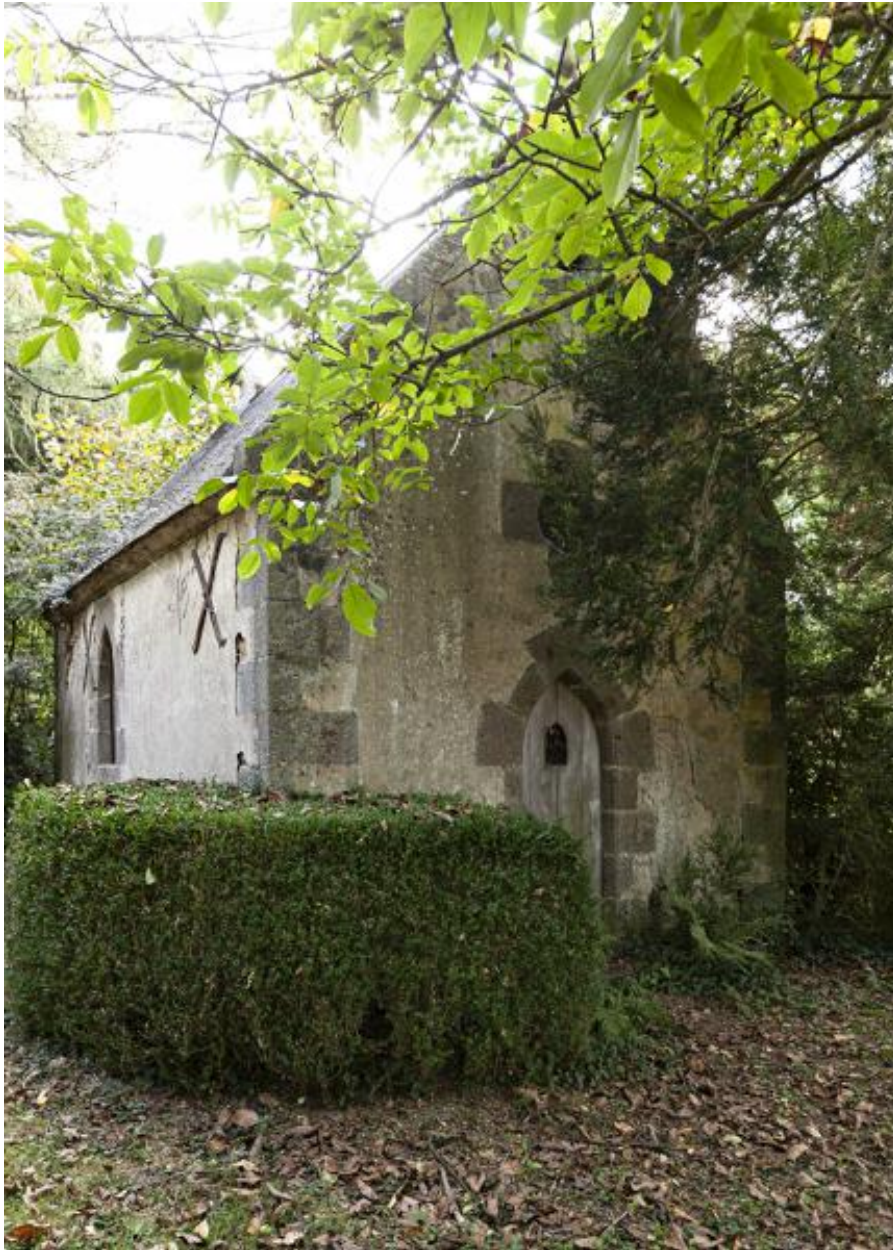
Chapelle de la Guette, façade nord.
