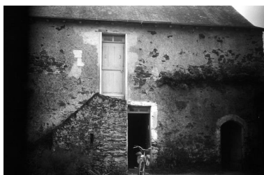
Façade principale de la ferme n° 2 de l'écart de la Binaudière. Phot. Marie-Anne Eon IVR52_19724900475Z
