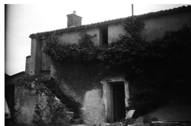
Façade principale de la ferme n° 4 de l'écart de la Binaudière. Phot. Marie-Anne Eon IVR52_19724900474Z
