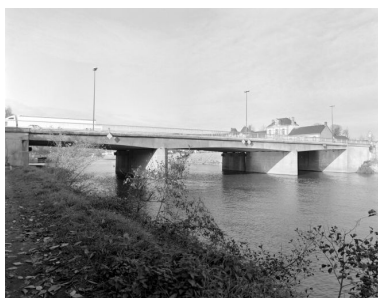
Vue d'ensemble du pont actuel depuis la rive droite et en aval. Phot. François Lasa IVR52_20025301976X
