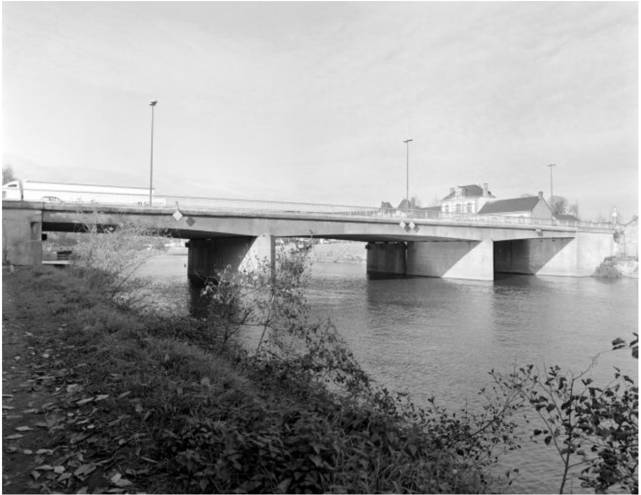
Vue d'ensemble du pont actuel depuis la rive droite et en aval.
