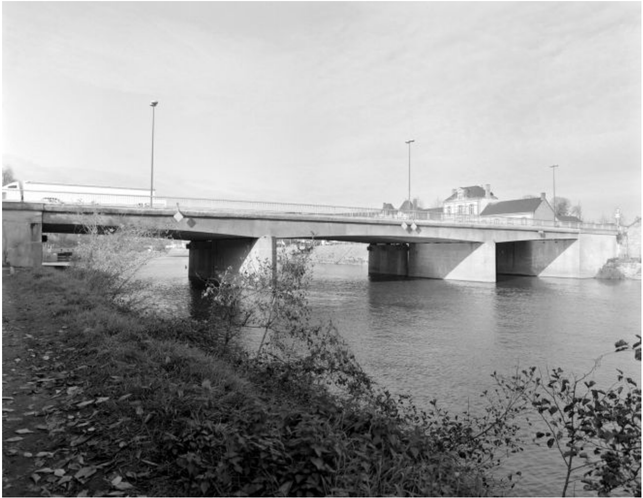
Vue d'ensemble du pont actuel depuis la rive droite en aval.
