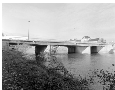
Vue d'ensemble du pont actuel depuis la rive droite en aval. Phot. François Lasa IVR52_20025301976X
