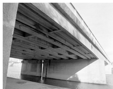
Vue de la structure du pont, sous le tablier, depuis la rive droite. Phot. François Lasa IVR52_20025301977X
