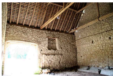
La grange : revers de la façade. Phot. Jean-Baptiste Darrasse IVR52_20067206232NUCA
