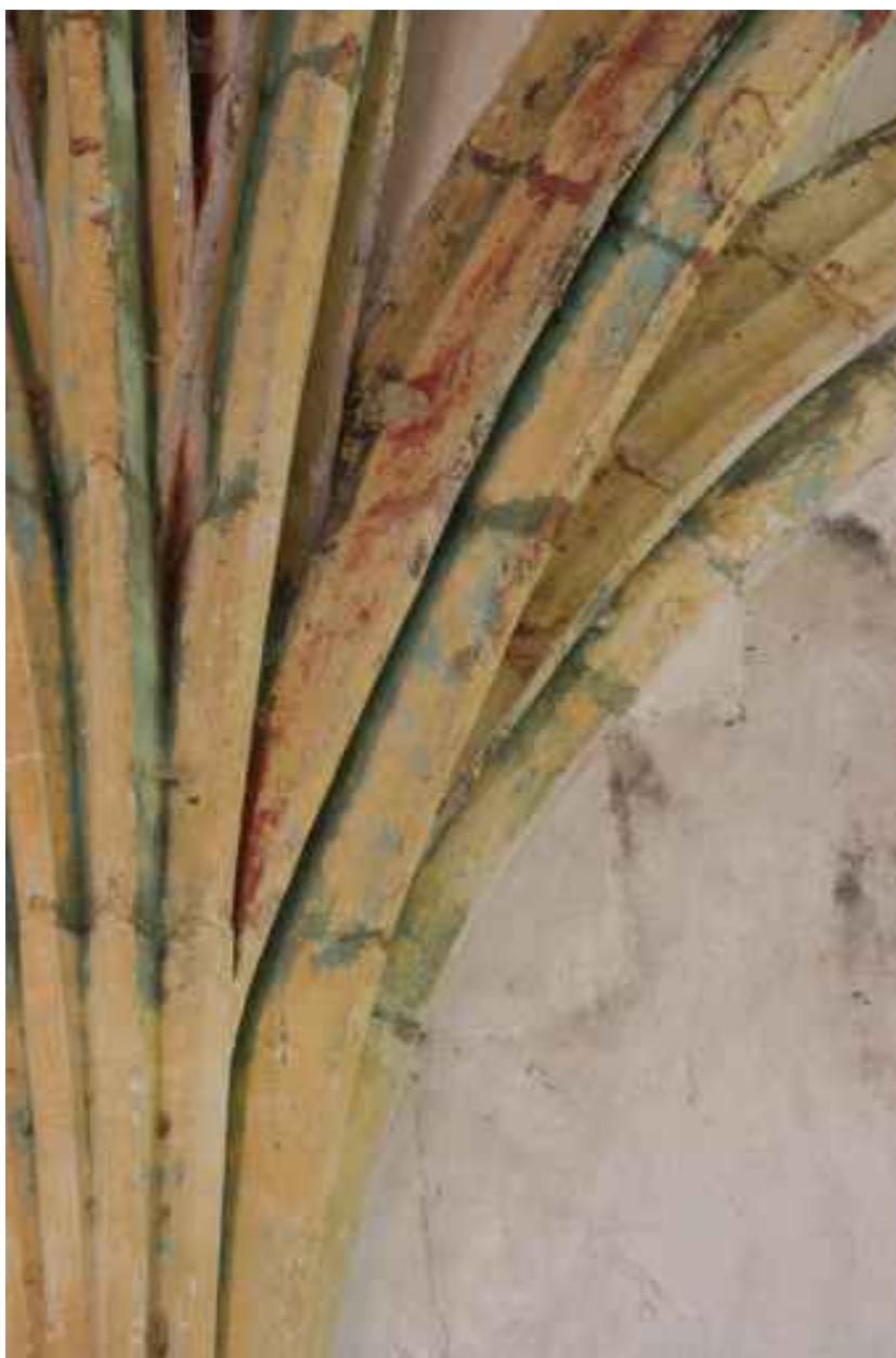
La chapelle : retombée des nervures de la voûte sur les chapiteaux.
