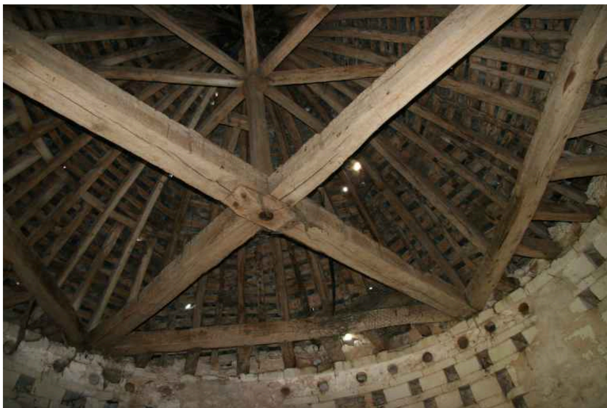
La tour pigeonnier : la charpente.
