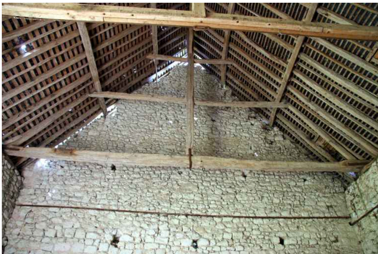
La grange : charpente à pannes.
