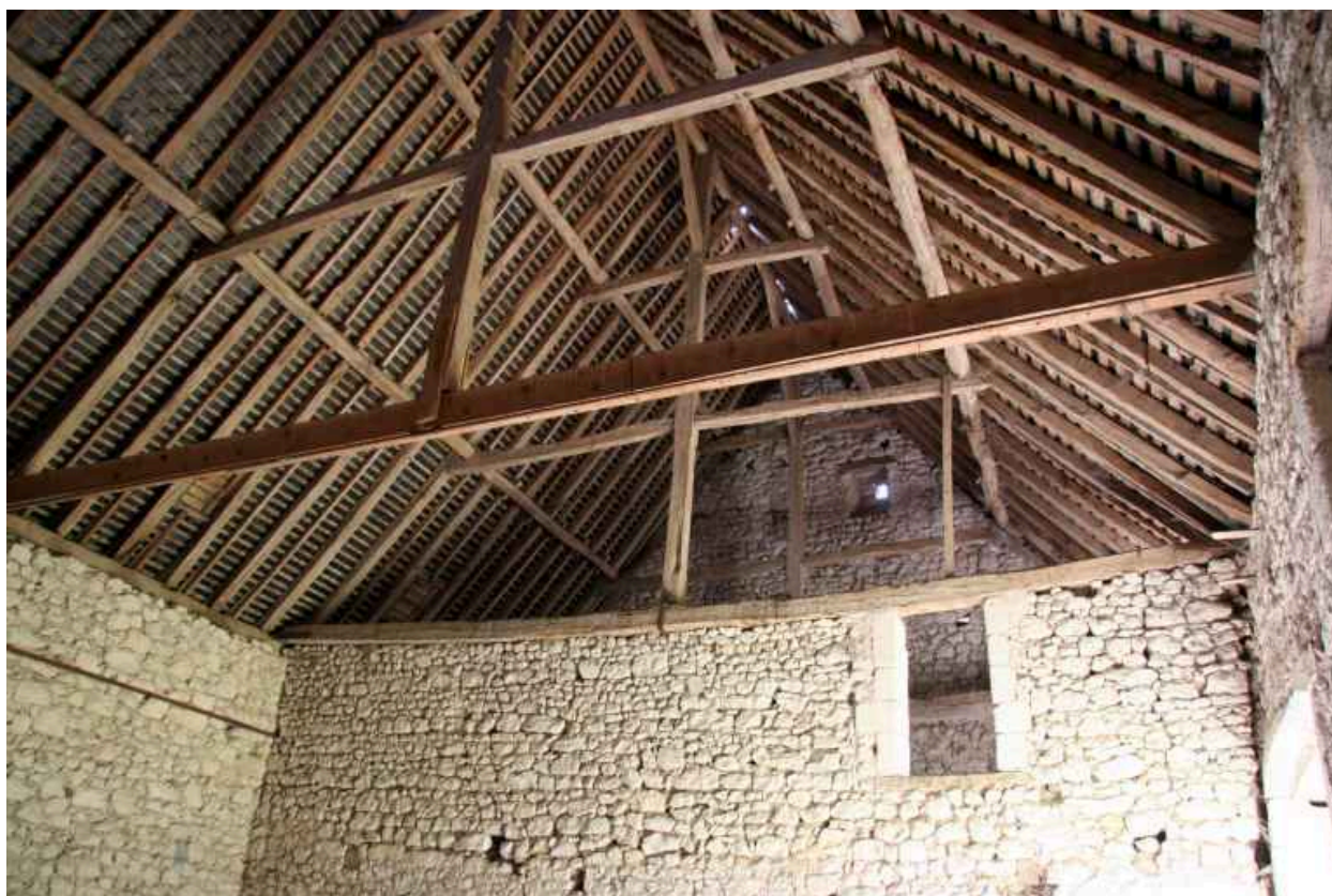
La grange : charpente à pannes sur faux entrails à encoches.
