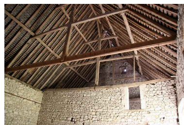
La grange : charpente à pannes sur faux entrails à encoches. Phot. Jean-Baptiste Darrasse IVR52_20067206233NUCA
