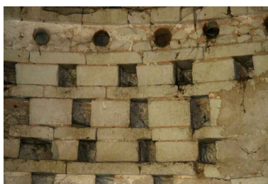
La tour pigeonnier : intérieur. Phot. Jean-Baptiste Darrasse IVR52_20067206258NUCA
