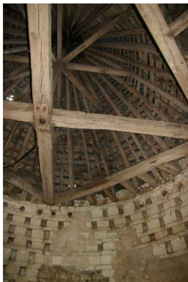
Le pigeonnier : la charpente est supportée par un rang de trous de boulins de terre cuite. Phot. Jean-Baptiste Darrasse IVR52_20067206256NUCA
