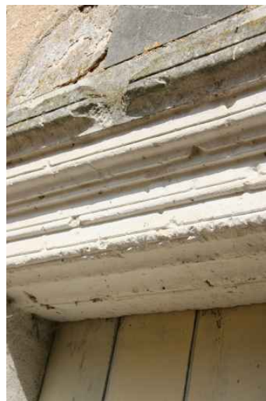
La chapelle, linteau de la porte d'entrée : détail. Phot. Jean-Baptiste Darrasse IVR52_20067206252NUCA
