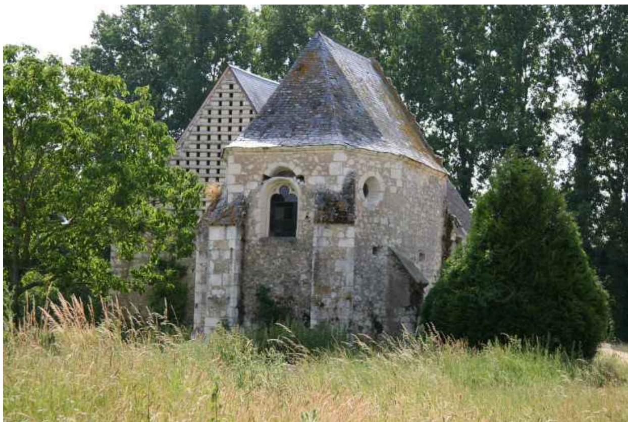
La chapelle : le chevet à pans coupés. Les oeils-de-boeuf ont été remaniés.
