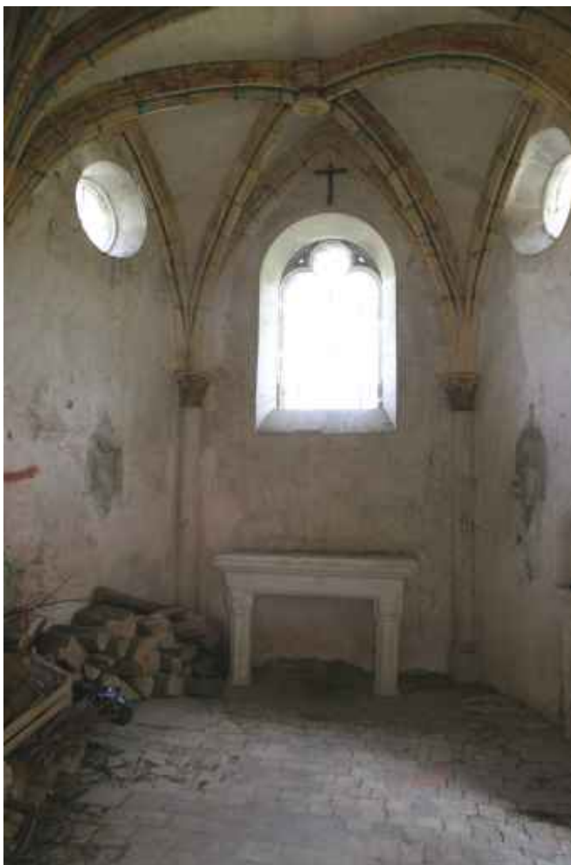
La chapelle : vue prise de la porte d'entrée.
