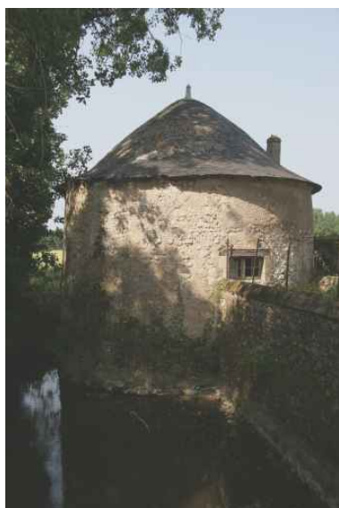
Angle nord-ouest de la plate-forme : le colombier.. Phot. Jean-Baptiste Darrasse IVR52_20067206253NUCA
