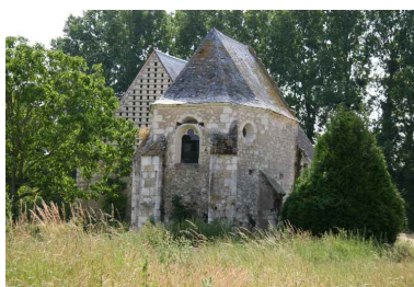
La chapelle : le chevet à pans coupés. Les oeils-de-boeuf ont été remaniés.
