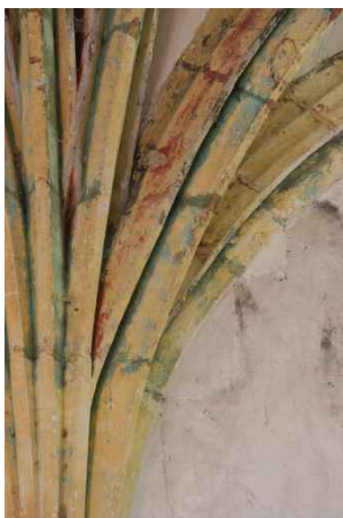
La chapelle : retombée des nervures de la voûte sur les chapiteaux. Phot. Jean-Baptiste Darrasse IVR52_20067206242NUCA
