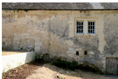
Vestiges de la grande croisée de la salle ajoutée en 1527 : noter le niveau plus bas. Phot. Jean-Baptiste Darrasse IVR52_20067206262NUCA
