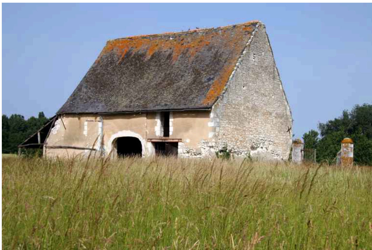
La grange : vue de volume.
