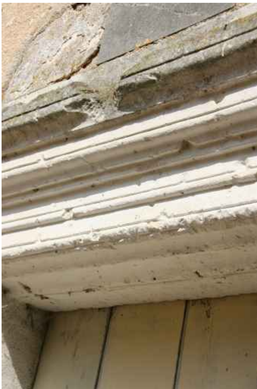
La chapelle, linteau de la porte d'entrée : détail.
